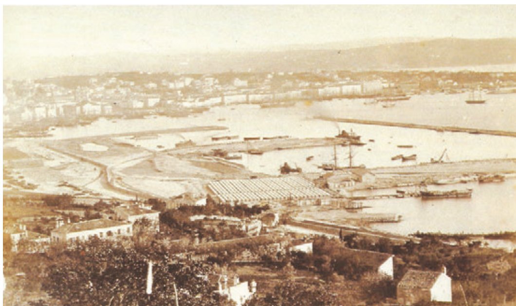
Figura 12 - Fotografia realizzata dal colle di Scorcola raffigurante i lavori di realizzazione del Hafengebäude: ben visibili moli, diga foranea e i depositi di materiale lapideo trasportato via mare dalle Cave della Baia di Sistiana. Giuseppe Wulz, 1890, Museo della Città di Trieste
