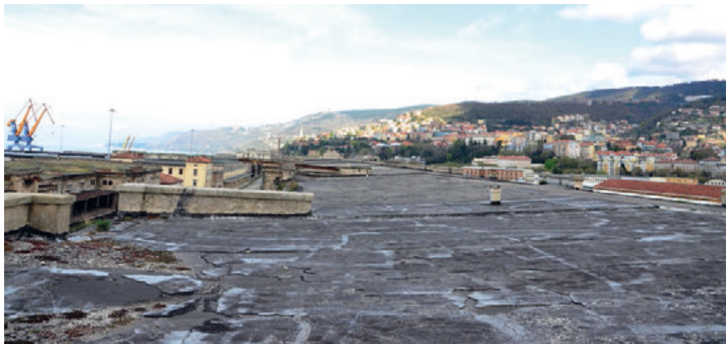
Figura 18 - Copertura tipo Hoelzmett del Magazzino 10
