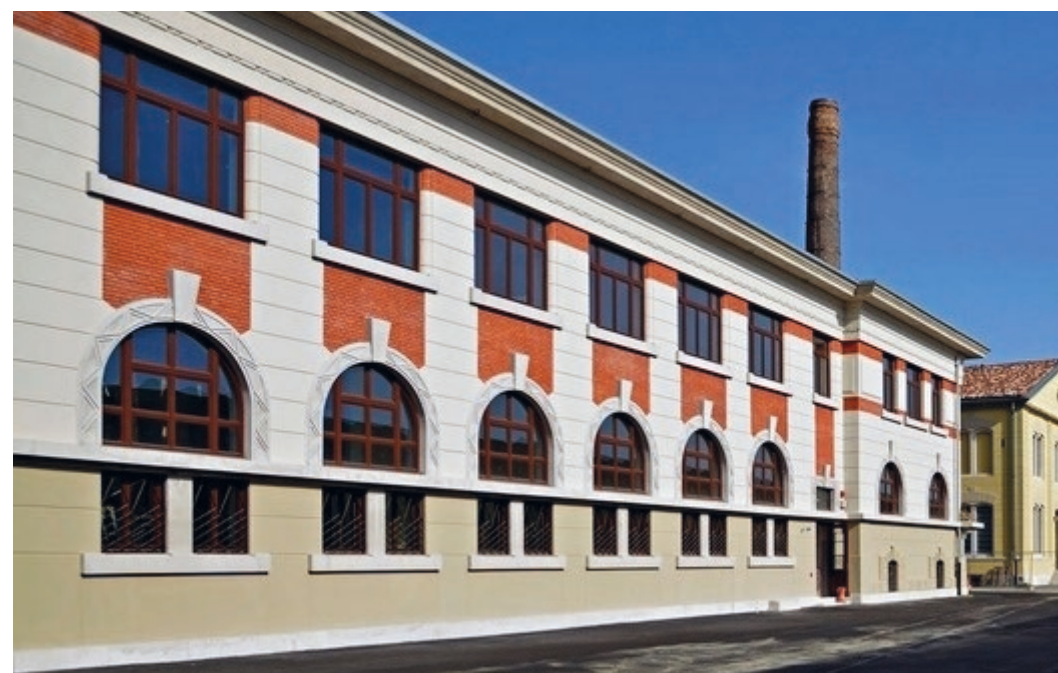
Figura 38 - Sottostazione di trasformazione elettrica restaurata www.konradnews.org
