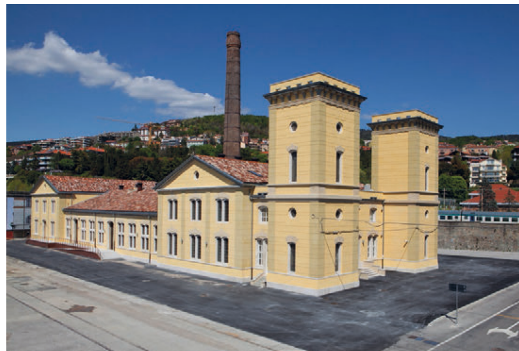
Figura 37 - Centrale Idrodinamica restaurata www.triestecultura.it
