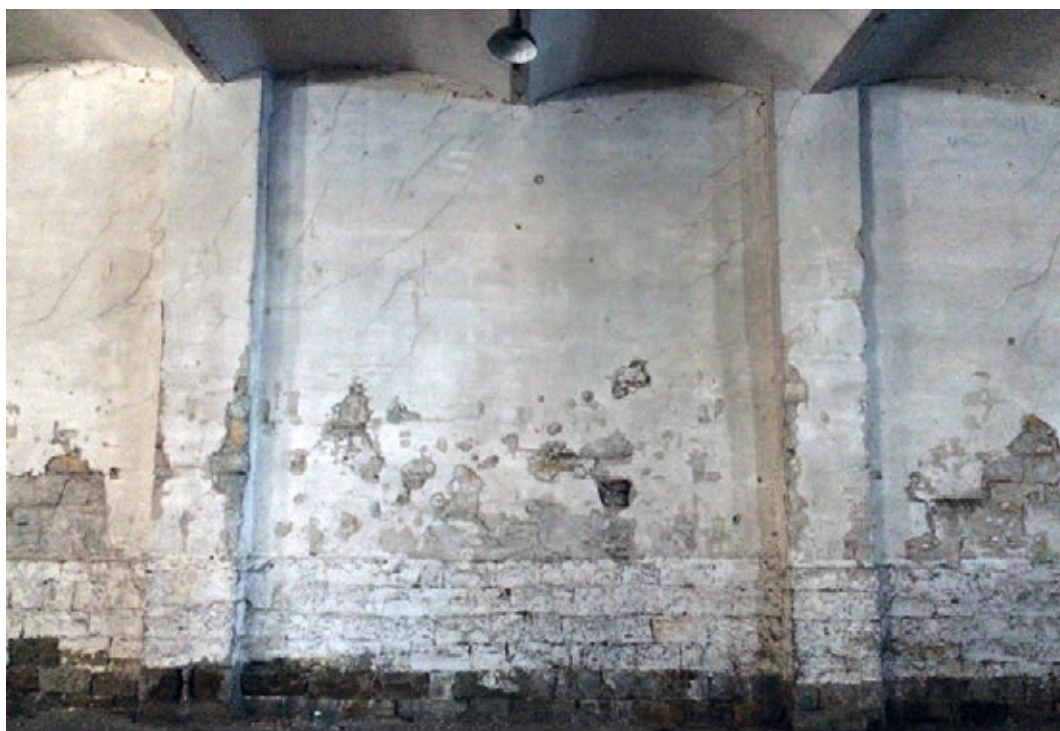
Figura 19 - Partizione interna verticale realizzata in blocchi di pietra arenaria
