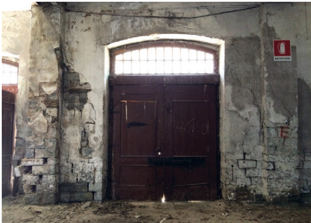
Figura 10 - Erosione e distacco di blocchi da un setto portante del piano terra
