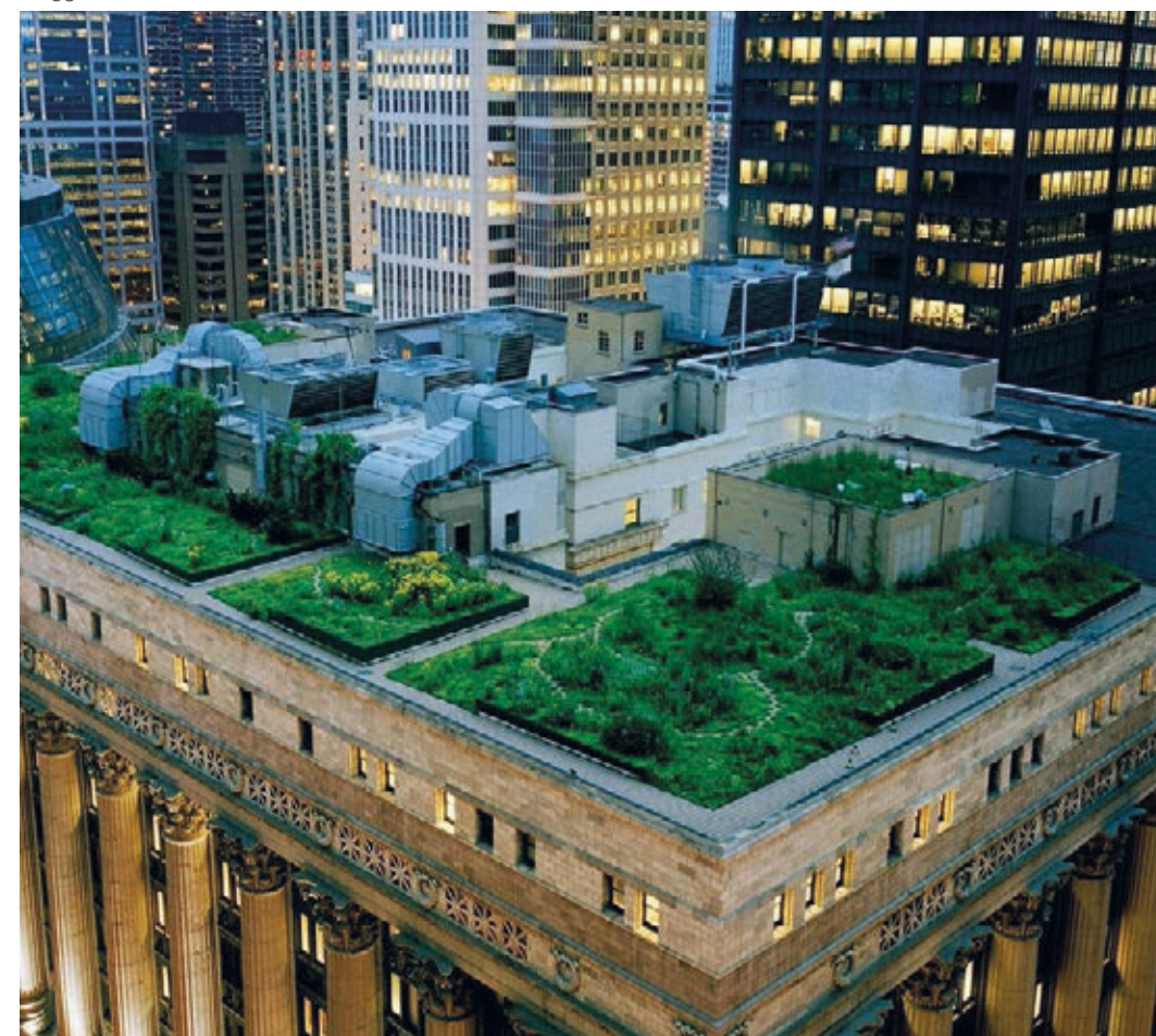
Figura 27 - Giardino pensile realizzato sulla copertura del Municipio di Chicago Marilyn Novy, Green Roofs, Maggio 2003
