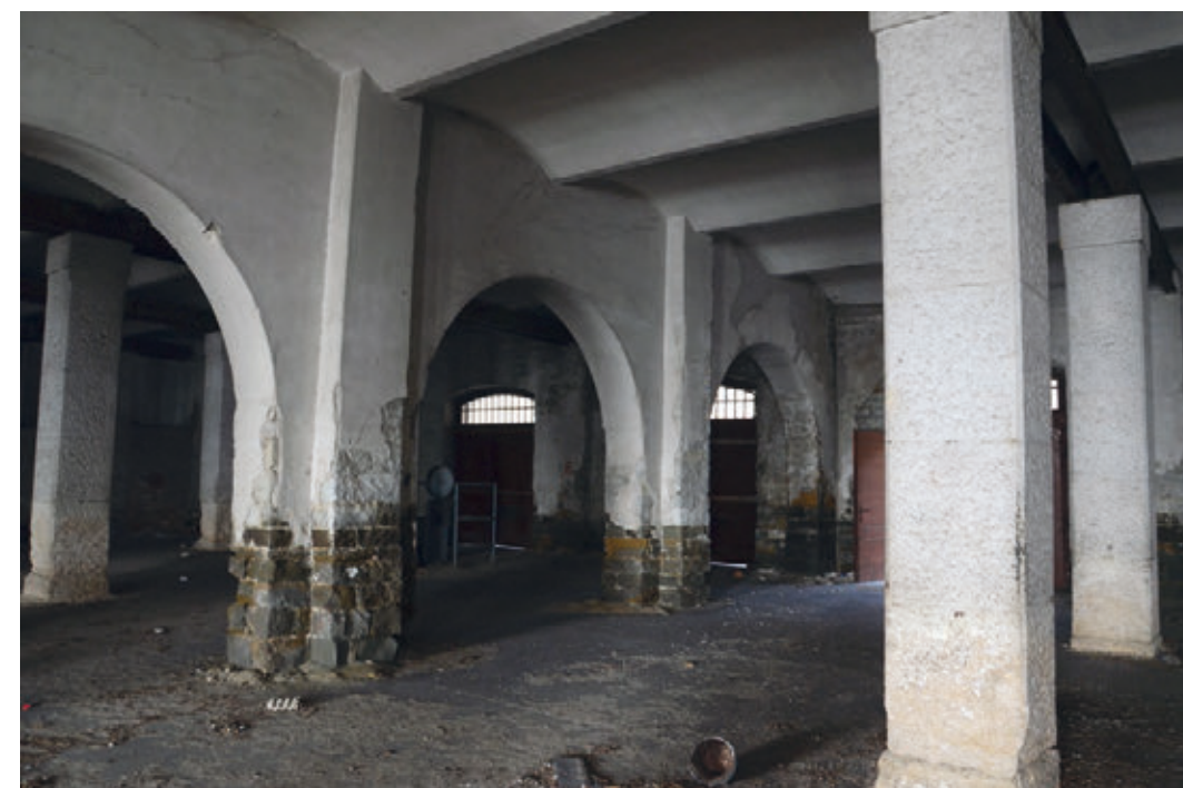
Figura 7 - Sistema di pilastri al piano terra di un Magazzino, sulla sinistra si osservano gli elementi realizzati in blocchi di pietra arenaria mentre sulla destra quelli in pietra calcarea
