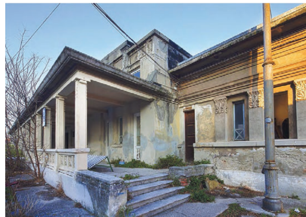
Figura 3 - Edificio ex-mensa, Casa degli operai Il Porto Vecchio di Trieste, Autorità Portuale di Trieste
