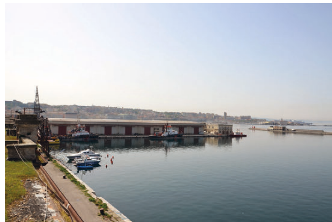
Figura 29 - Vista dalla copertura dalla copertura del Magazzino 9, prospiciente il Bacino 1
