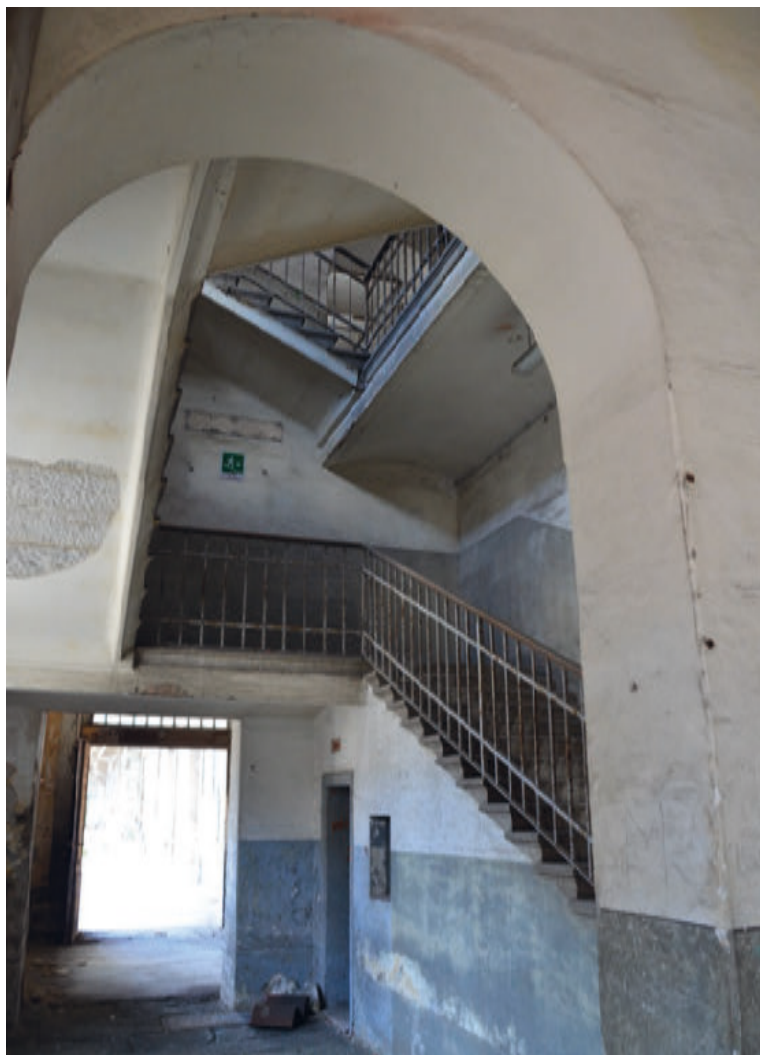
Figura 22 - Vano scale di un Magazzino del Porto
