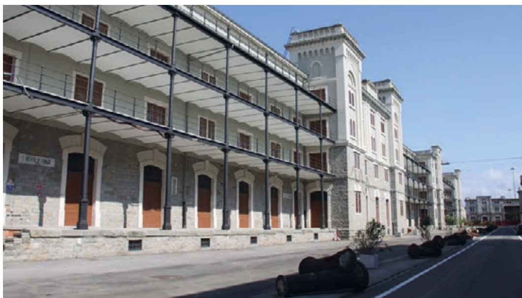
Figura 36 - Vista lato mare del Magazzino 26 a seguito del restauro portovecchio.comune.ts.it
