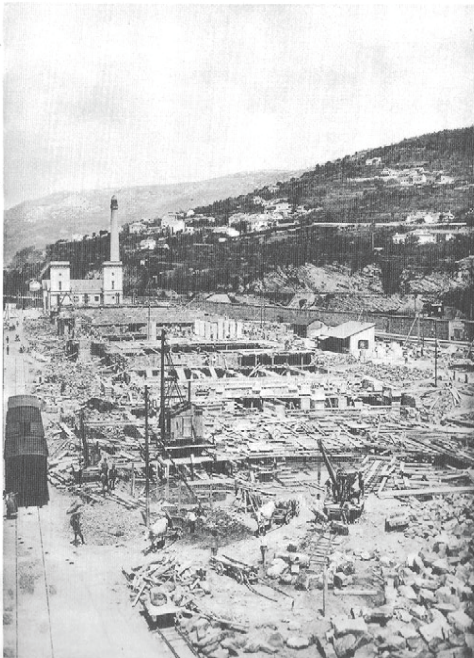
Figura 20 - Fotografia d'epoca che documenta le opere di realizzazione delle fondazioni del Magazzino 26 Il Magazzino 26 di Trieste, Documenti di un Restauro, Edizioni Lint, Trieste, 2011
