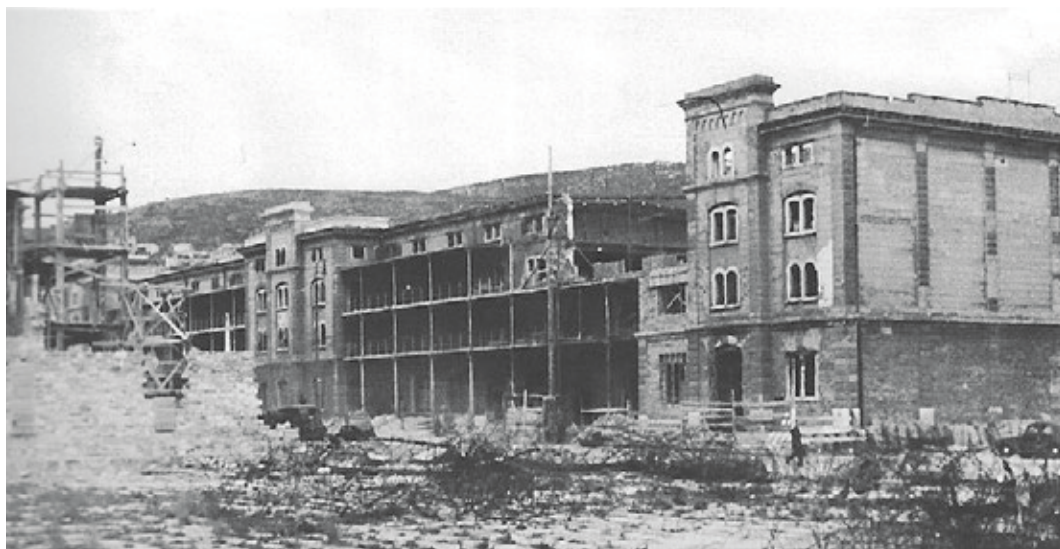
Figura 26 - Magazzino gravemente danneggiato a seguito del secondo conflitto mondiale F. Amodeo, A. Caroli, Trieste e il Porto: una storia per immagini, Editoriale FVG, Trieste 2007
