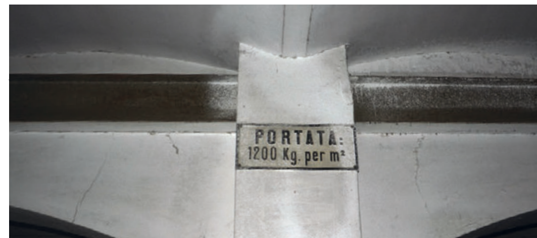
Figura 60 - Una delle targhette presenti su ciascun solaio degli edifici del porto rappresentante la portata per metro quadrato.
