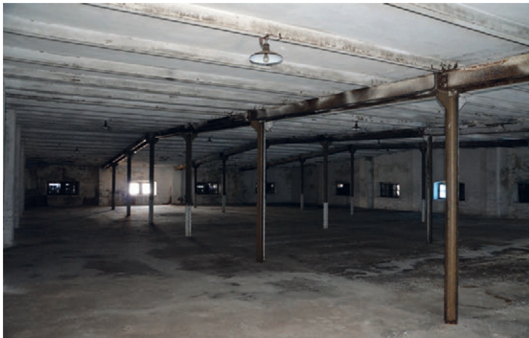
Figura 12 - Struttura elevazione orizzontale di copertura, in evidenza la struttura primaria composta dalle travi IPN340 e secondaria dall'orditura di travetti IPN200
