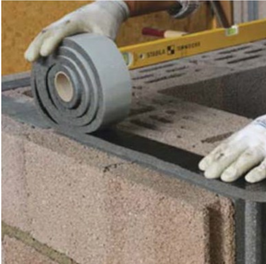
Posa in opera della striscia adesiva
