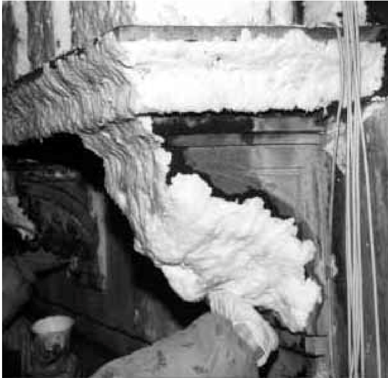
Figura 3 • Impacco in polpa di carta impregnata di biocida.
