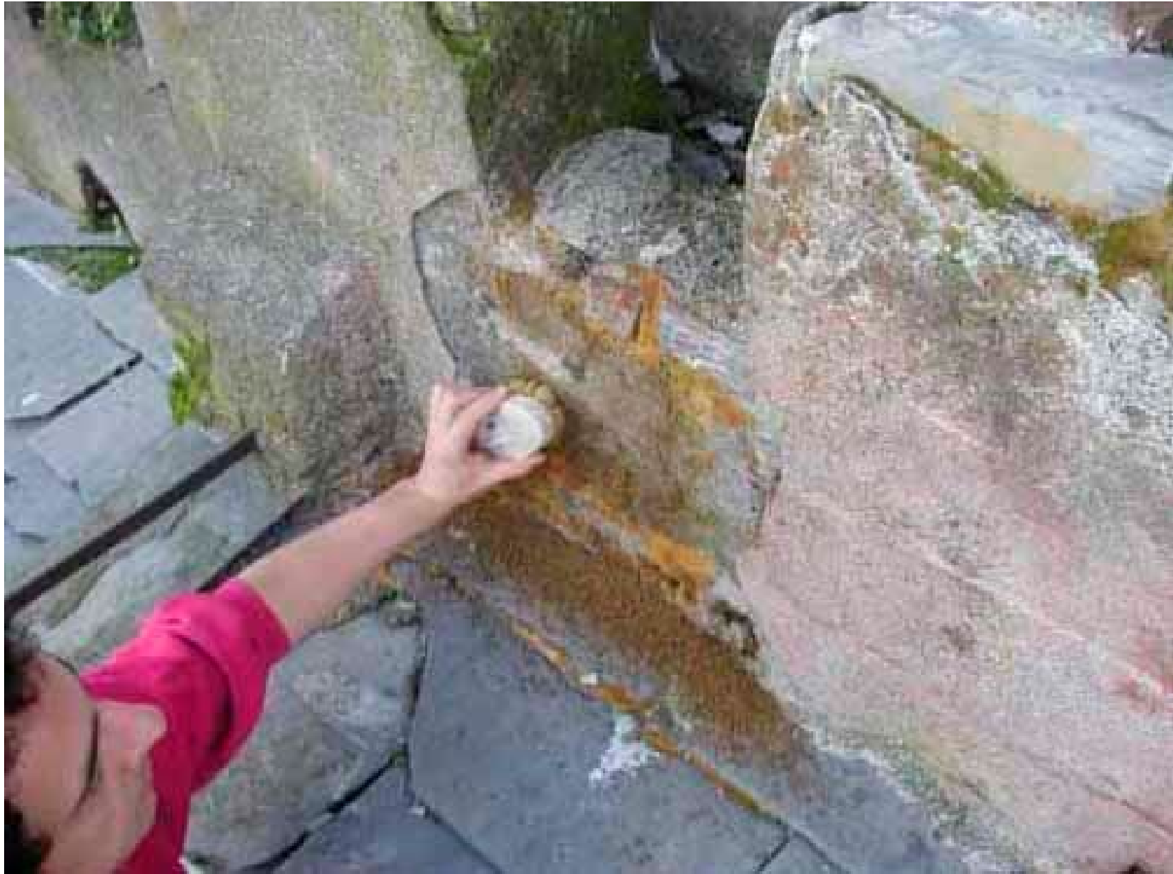
Figura 5 • Eliminazione della patina biologica secca, mediante spazzolatura.
