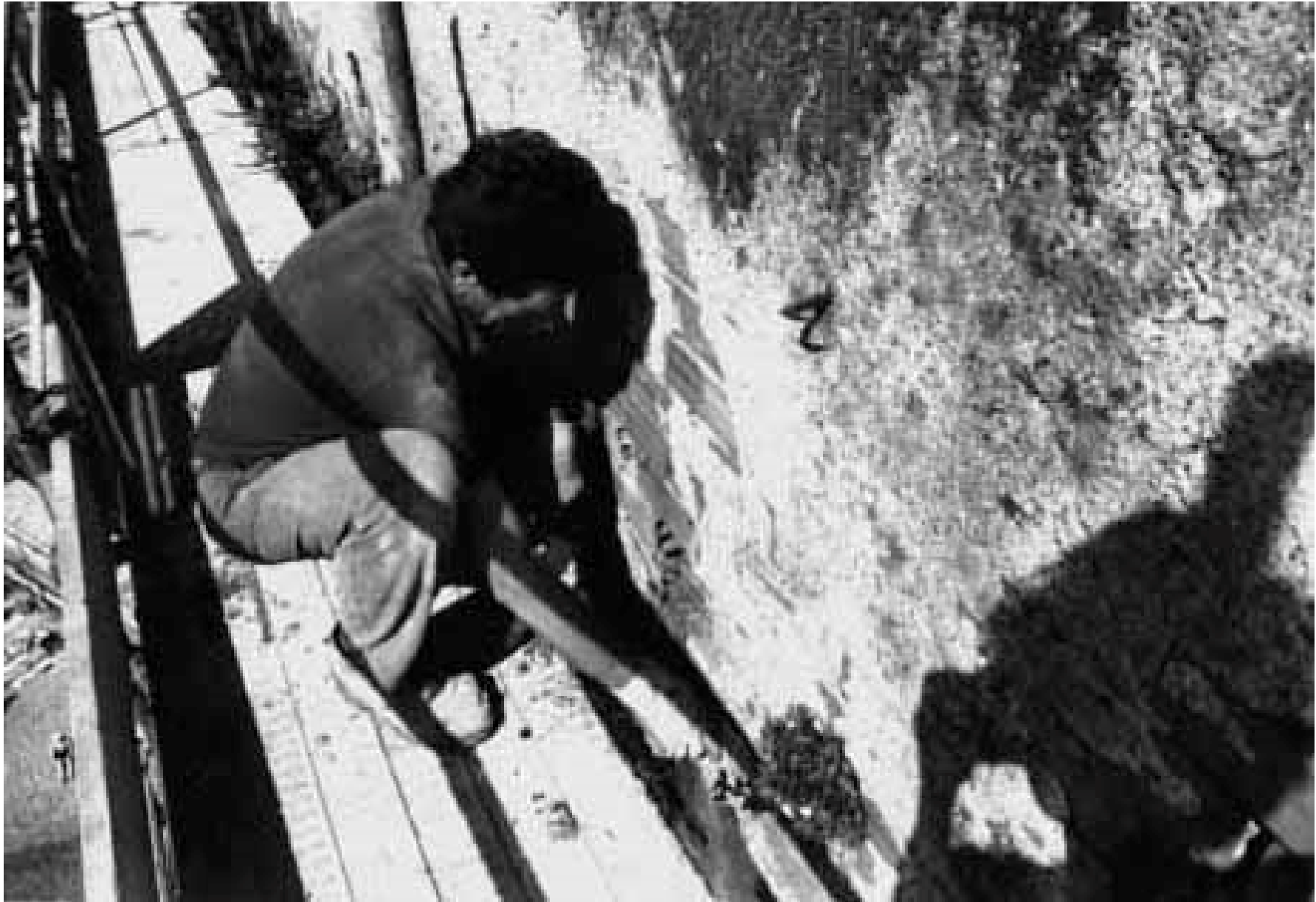
Figura 1 • Dopo l'applicazione di prodotto biocida l'operatore procede con l'estirpazione manuale della vegetazione infestante.
