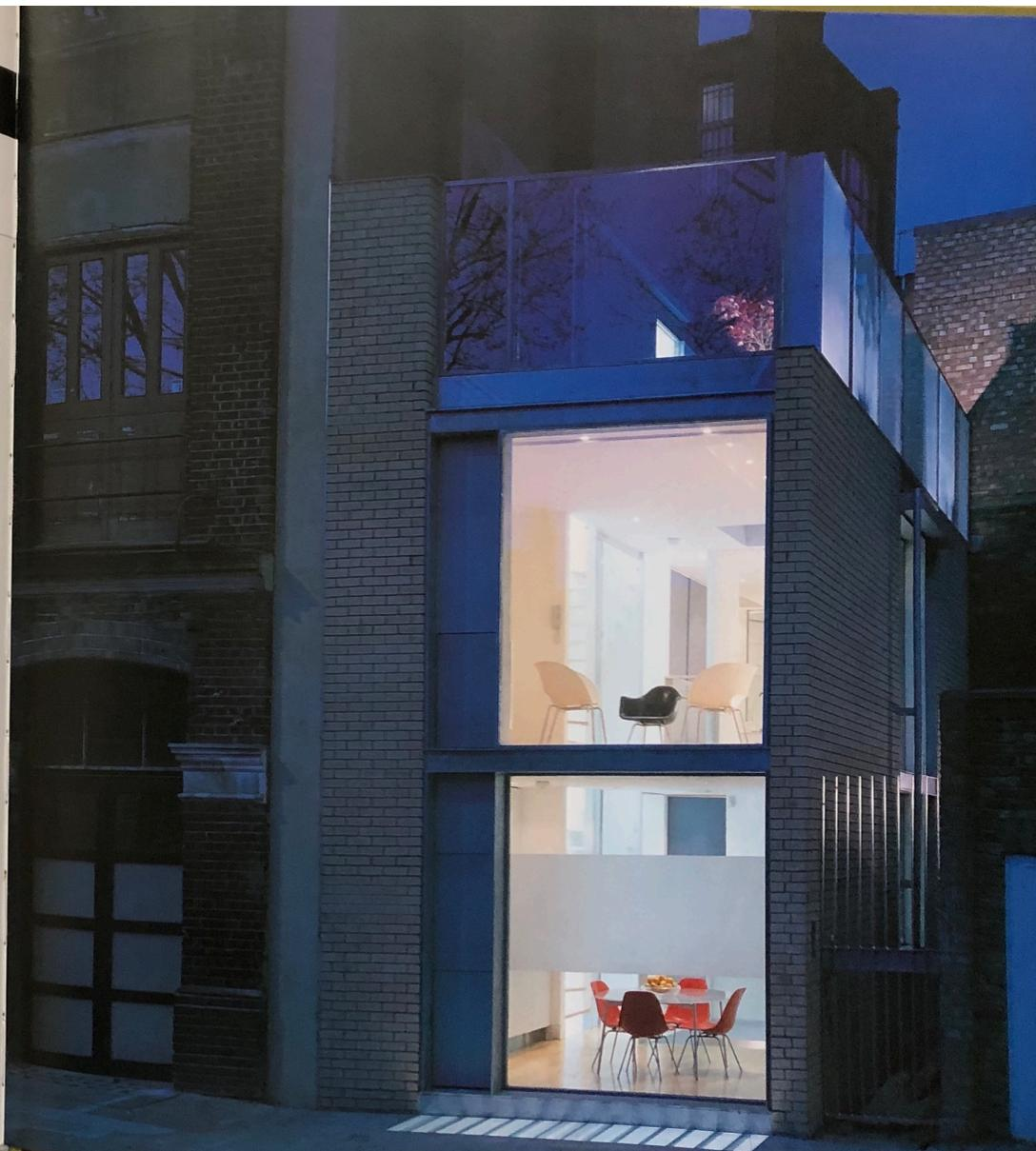
Le stanze da letto sono ventilate grazie all'atrio, durante l'inverno o direttamente dall'esterno, durante l'estate. Nelle finestre sono stati disposti vetri a E con telaio in acciaio e pannelli di ventilazione mobili e isolati con legno. La casa è stata disegnata perché sia energeticamente efficiente e, allo stesso tempo, totalmente aperta verso l'esterno.
