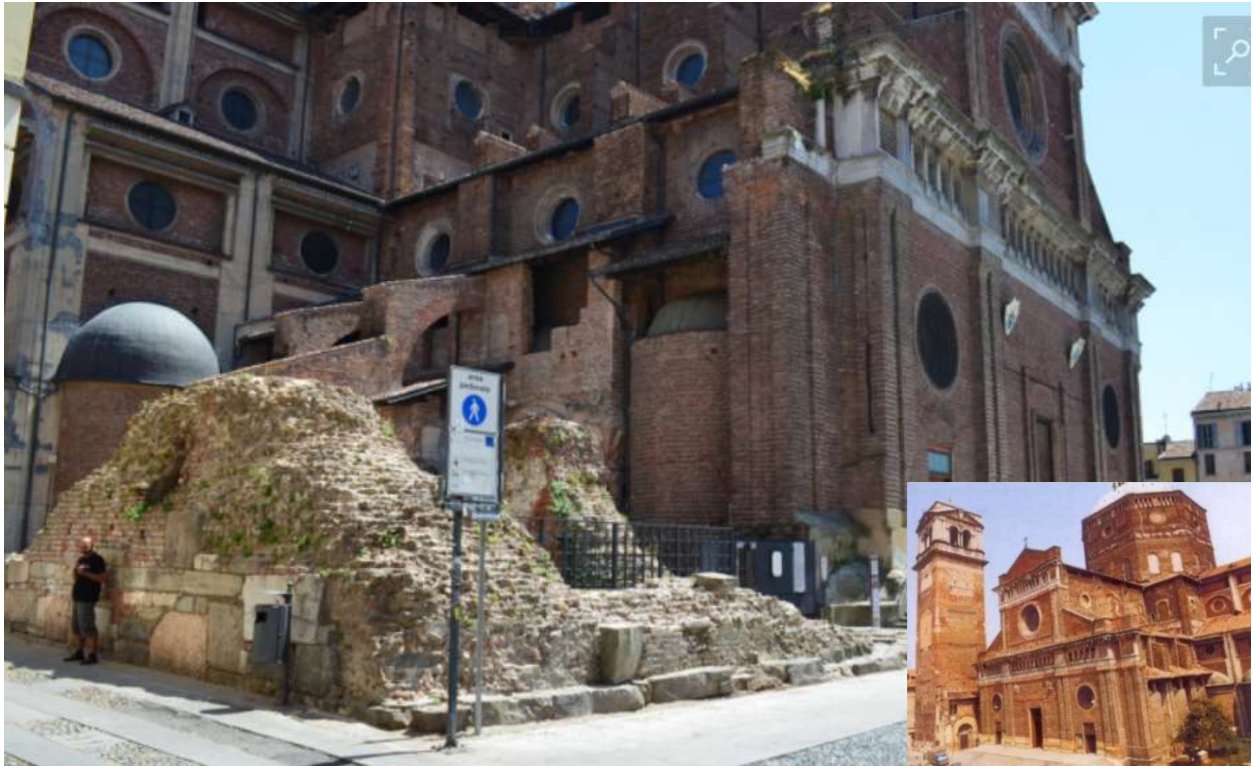
Crollo Torre Civica (marzo 1989)
