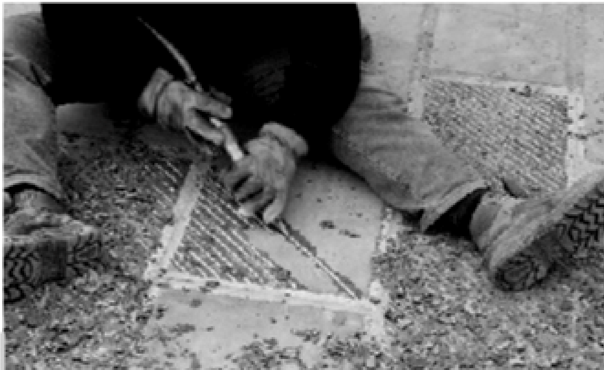
Figura 14 • Finitura in opera della superficie, mediante sabbia pneumatica.
