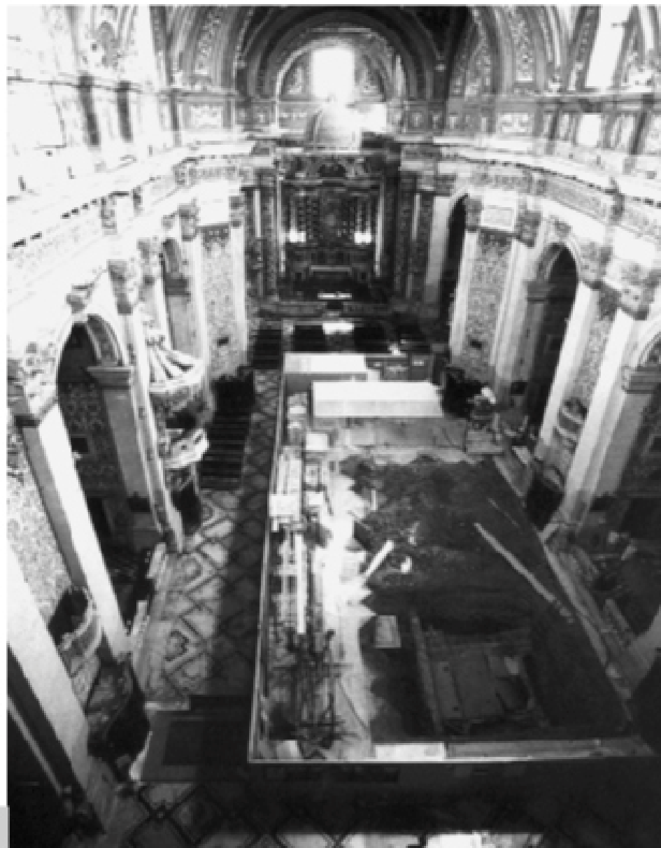
Figura 8 • Il pavimento dell'aula è stato smontato per restaurarne le superfici marmoree e consolidarne il sottofondo, consentendo, allo stesso tempo, l'apertura di un cantiere archeologico.
