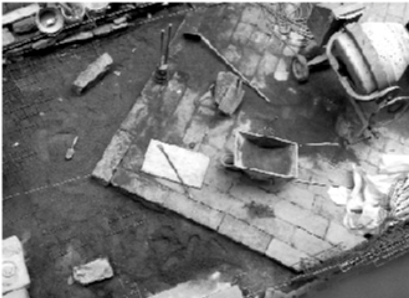
Figura 10 • Fase di rimontaggio della pavimentazione con ricollocazione dei tacchi. Sono visibili le principali attrezzature di cantiere.
