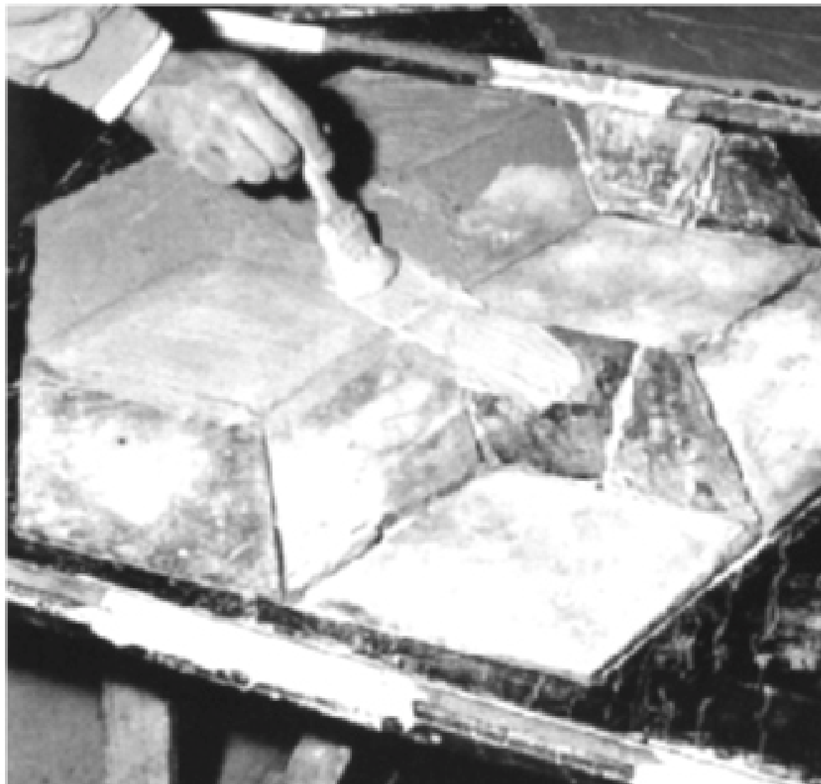
Figura 6 • Smontaggio del rivestimento marmoreo di un pavimento. Il riposizionamento e il fissaggio degli “steleri” delle tarsie marmoree è stato eseguito riproponendo la tecnica tradizionale con resina naturale (colofonia come legante e polvere di marmo come inerte). In questa fase sono stese a pennello due mani di resina sulla faccia inferiore degli esagoni.
