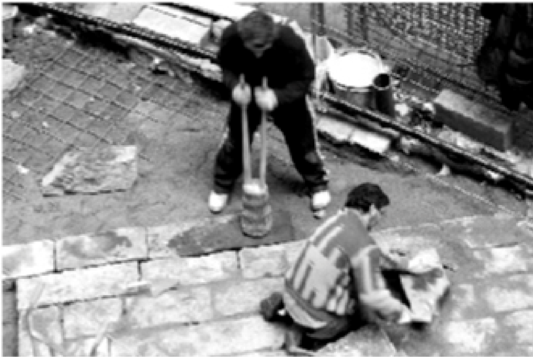
Figura 13 • Due momenti della lavorazione. Assestamento del blocco con il mazzapicchio e preparazione con la mazzetta di un altro blocco.
