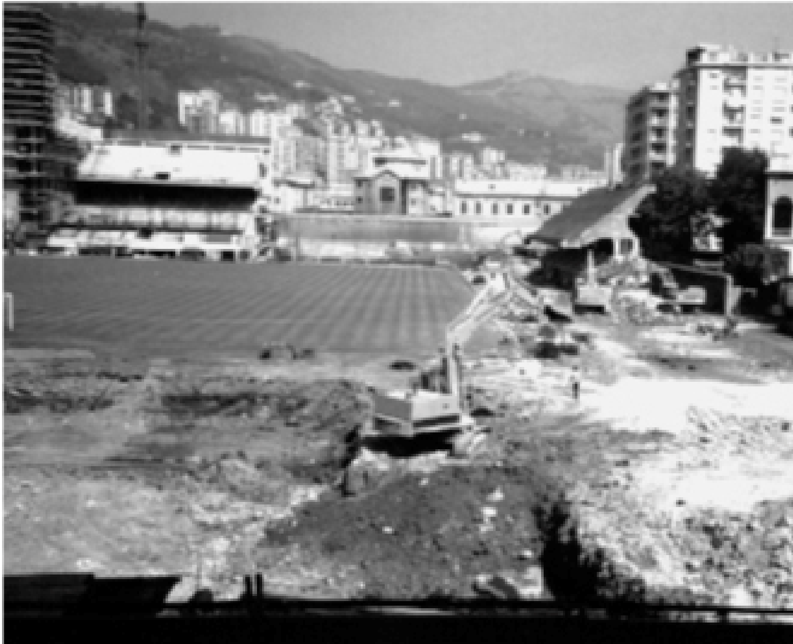
Figura 5 • Cantiere di demolizione totale delle tribune di uno stadio.
