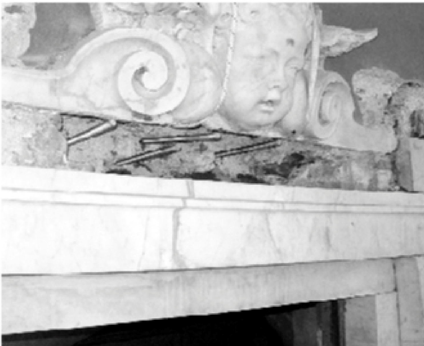
Figura 5 • Sostituzione degli elementi di connessione di una cornice di marmo: inserimento di perni filettati di acciaio inox alla base dell'architrave.
