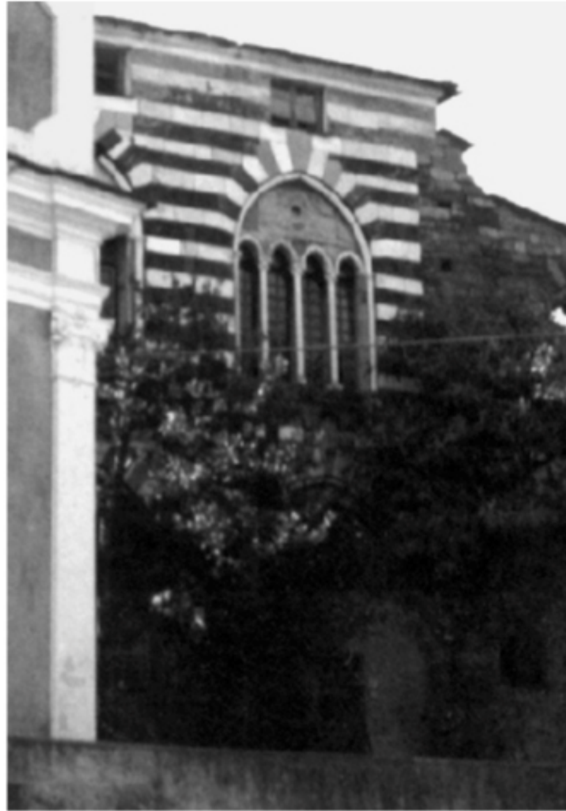
Figura 3 • Un altro prospetto dell'edificio della fig. 2 dopo la demolizione delle tamponature occludenti le finestre. Si noti come gli interventi di finitura abbiano radicalmente cambiato e "rinnovato" l'aspetto della vecchia costruzione.
