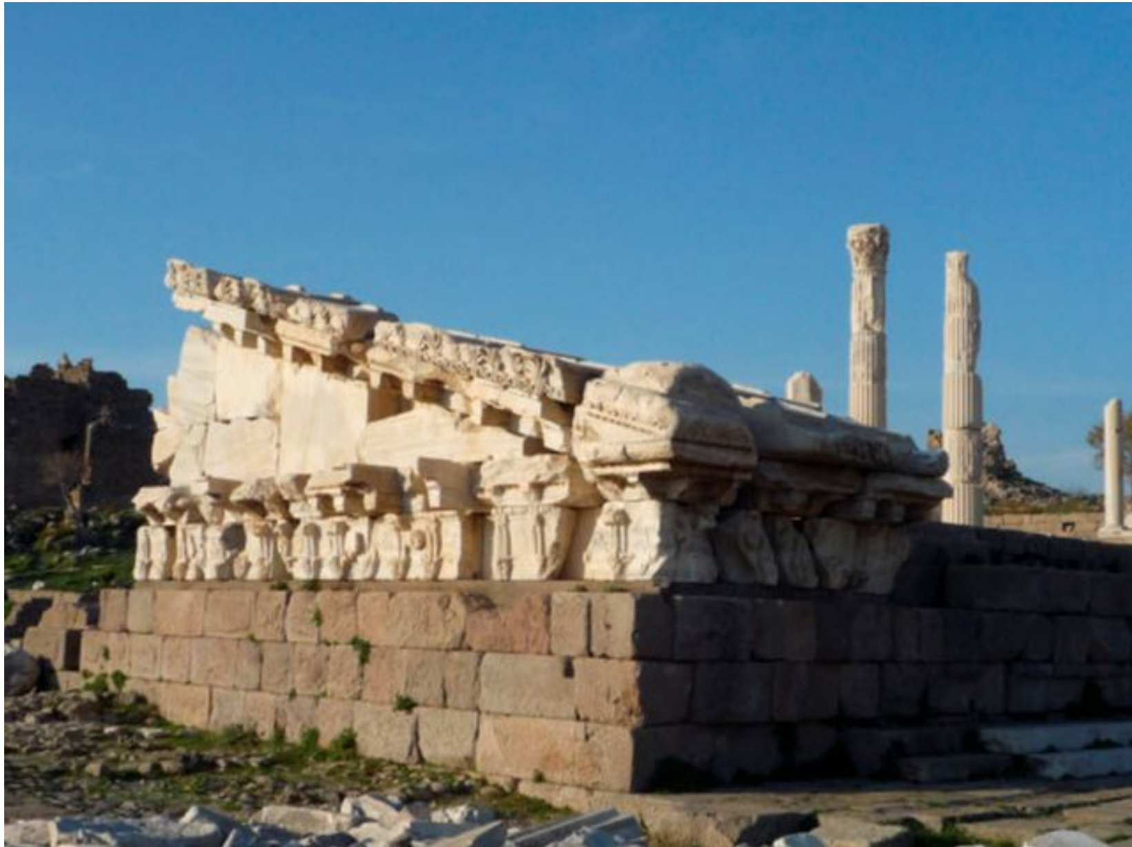
Figura 11 • Turchia, Acropoli di Pergamo: ricostruzione per anastilosi del Tempio di Traiano: particolare del frontone.
