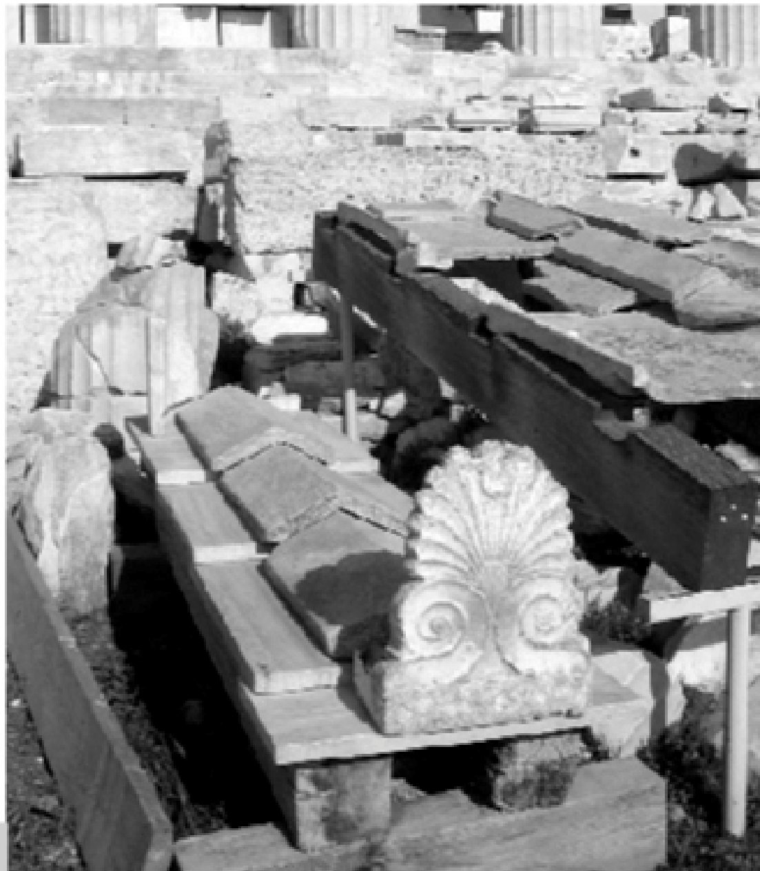
Figura 1 • Acropoli di Atene, parti costruttive a pie' d'opera, pronte per essere ricomposte.
