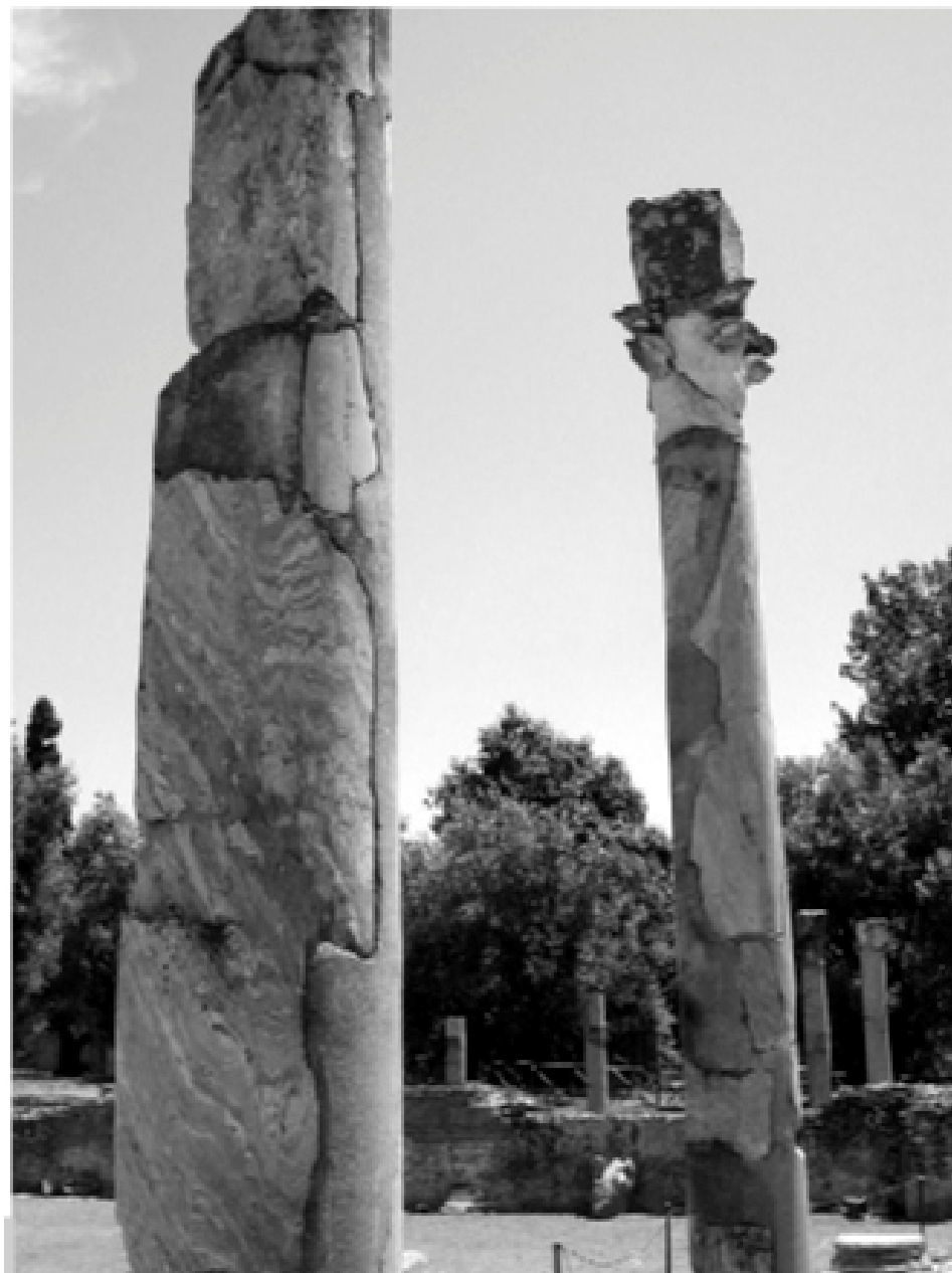
Figura 8 • Ricomposizione di colonne con integrazione di malta cementizia.
