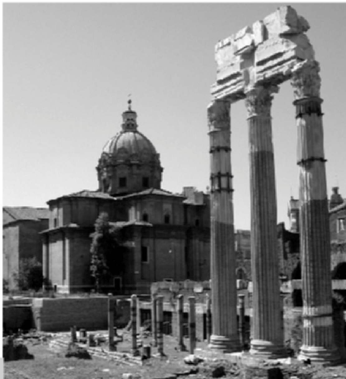
Figura 7 • Colonne ricomposte per anastilosi, con rilevanti integrazioni di pietra scanalata. Si notino le cerchiature metalliche sui rocchi antichi.
