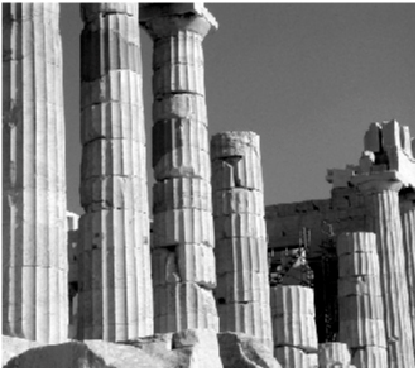
Figura 2 • Acropoli di Atene, colonne ricomposte con rocchi antichi e parti riprodotte.
