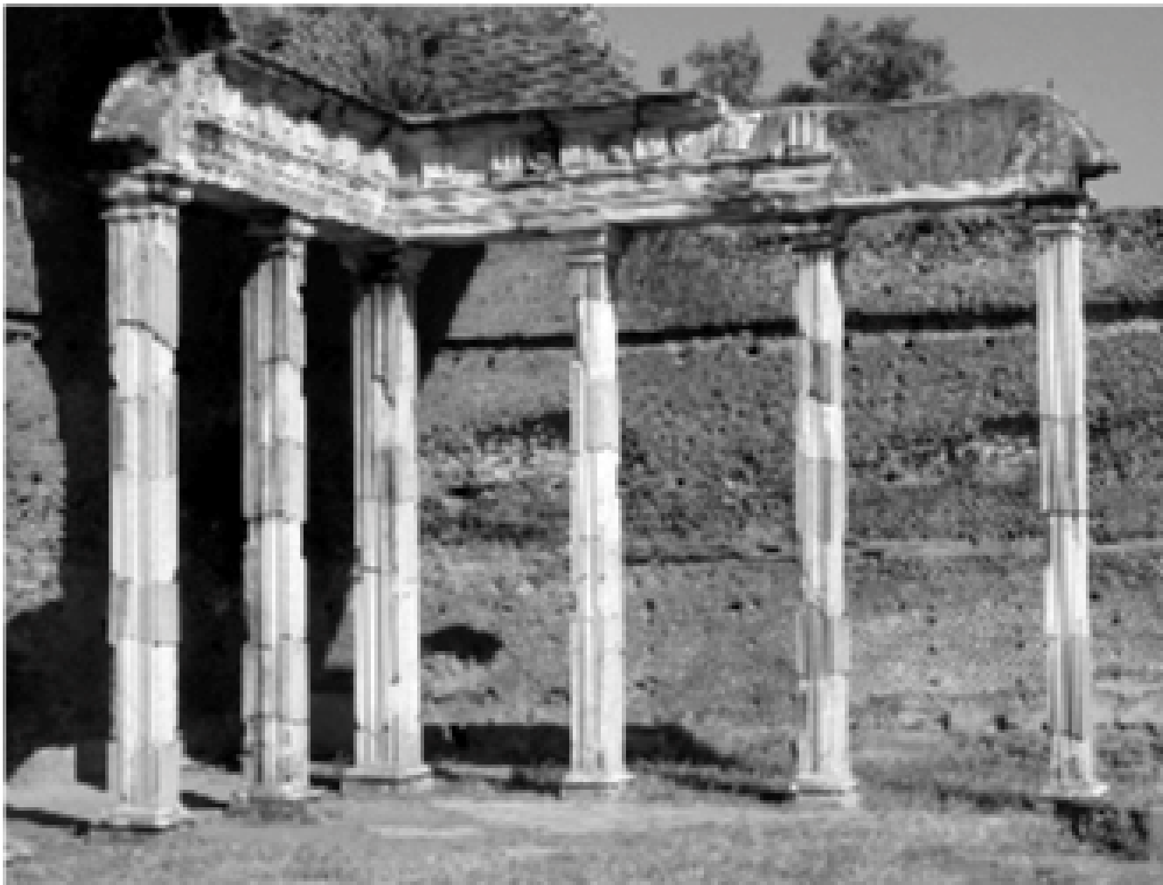
Figura 6 • Villa Adriana. Anastilosi con integrazione di blocchi di calcestruzzo lavorati come gli originali.
