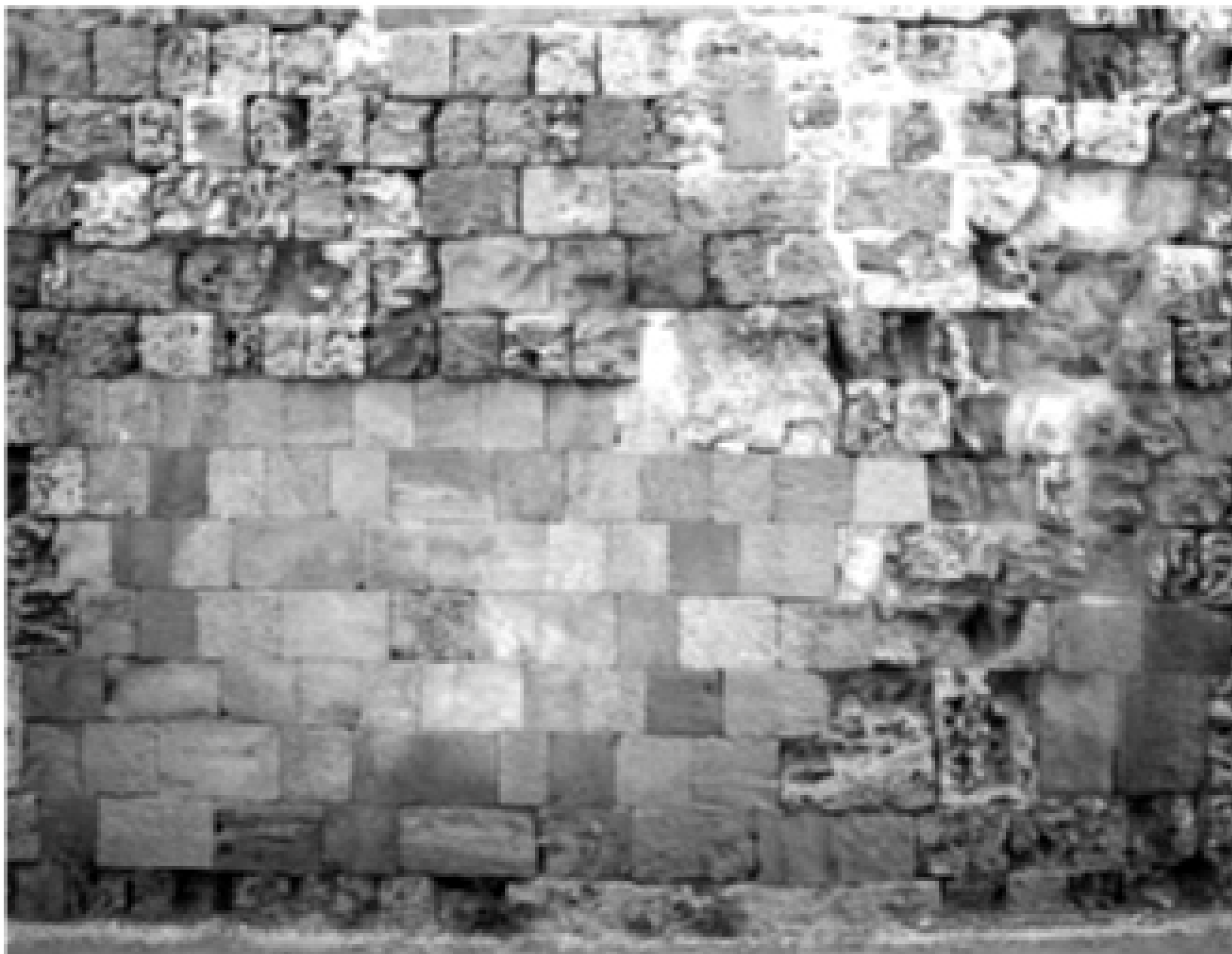
Figura 9 • Anche le operazioni di “cuci-scuci” sono un aspetto della demolizione.
