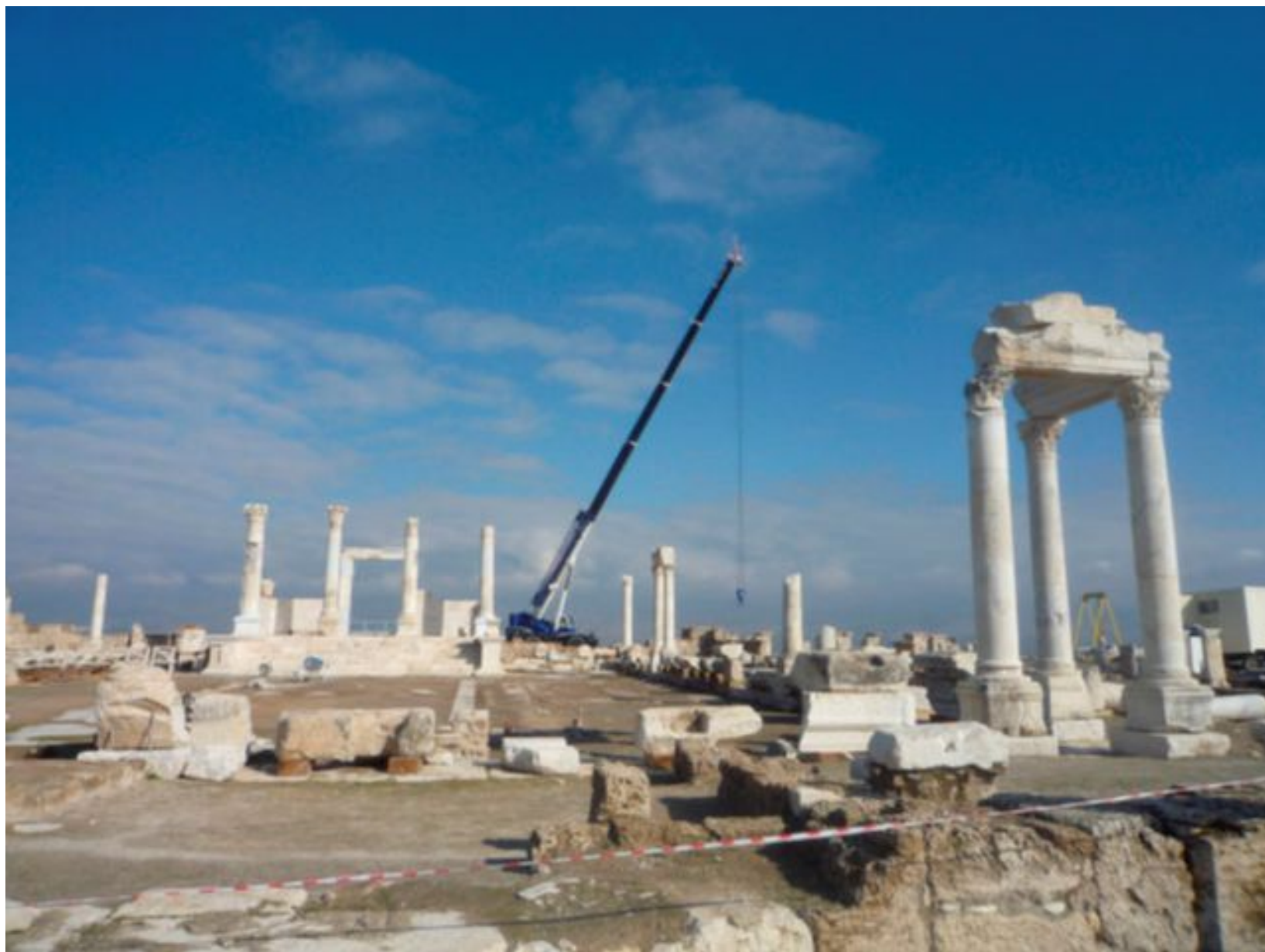
Figura 13 • Turchia, sito archeologico di Laodicea: è visibile il mezzo di sollevamento utilizzato per lo spostamento degli elementi di dimensioni maggiori.
