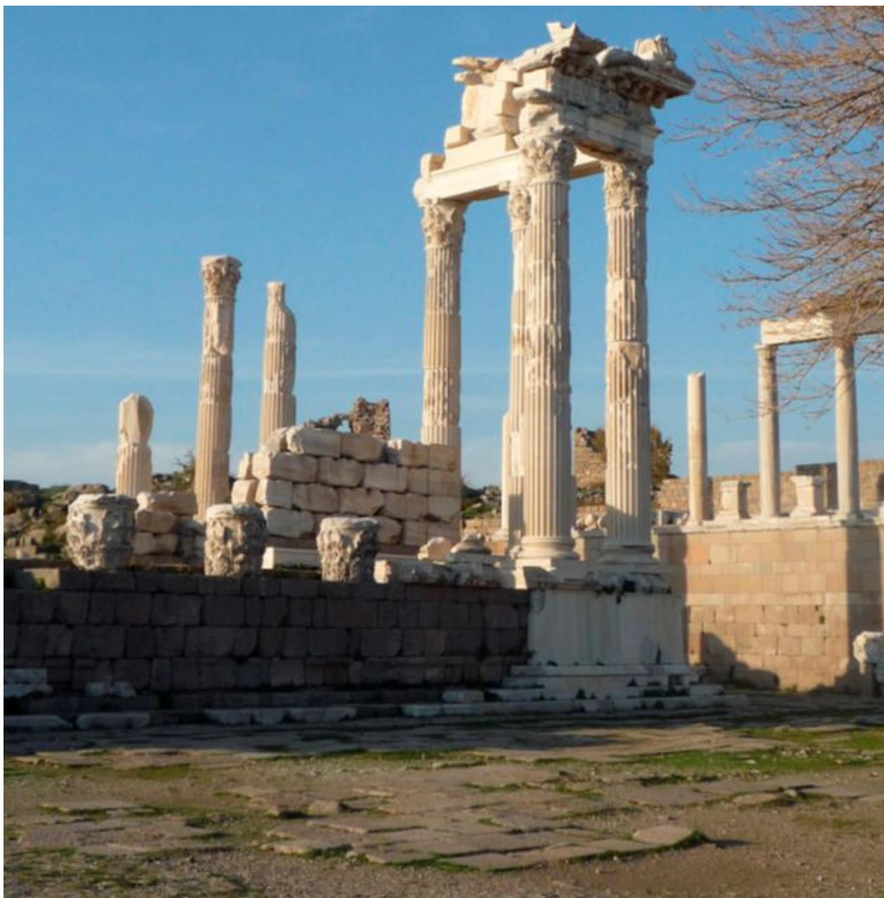
Figura 10 • Turchia, Acropoli di Pergamo: ricostruzione per anastilosi del Tempio di Traiano.
