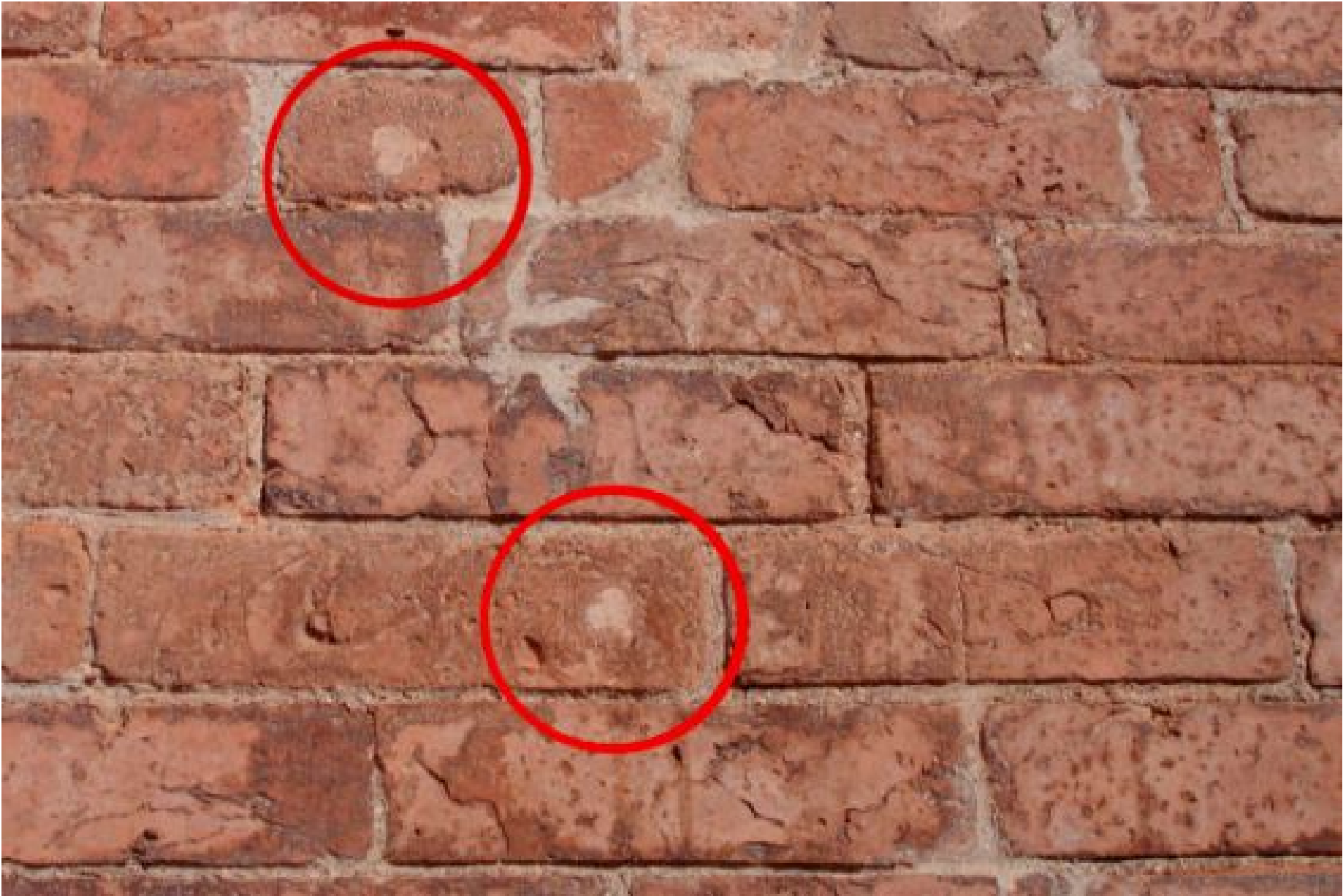
Fig. 8 • Localizzazione delle teste dei fori dopo la stuccatura eseguita con il formulato adesivo impastato con la polvere proveniente dal mattone perforato.
