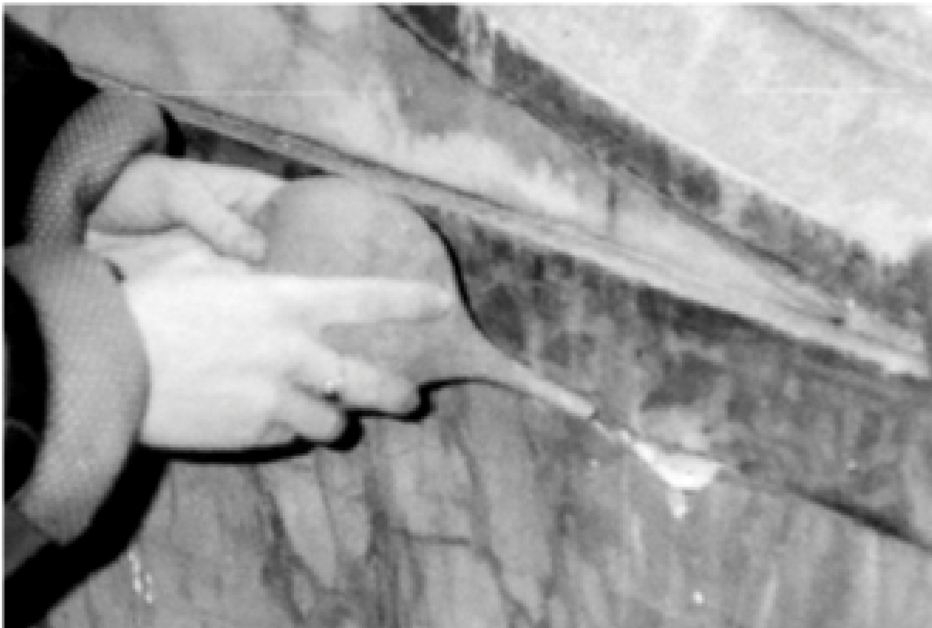
Figura 3 • Pulitura del foro dalla polvere prodotta durante l'operazione precedente.
