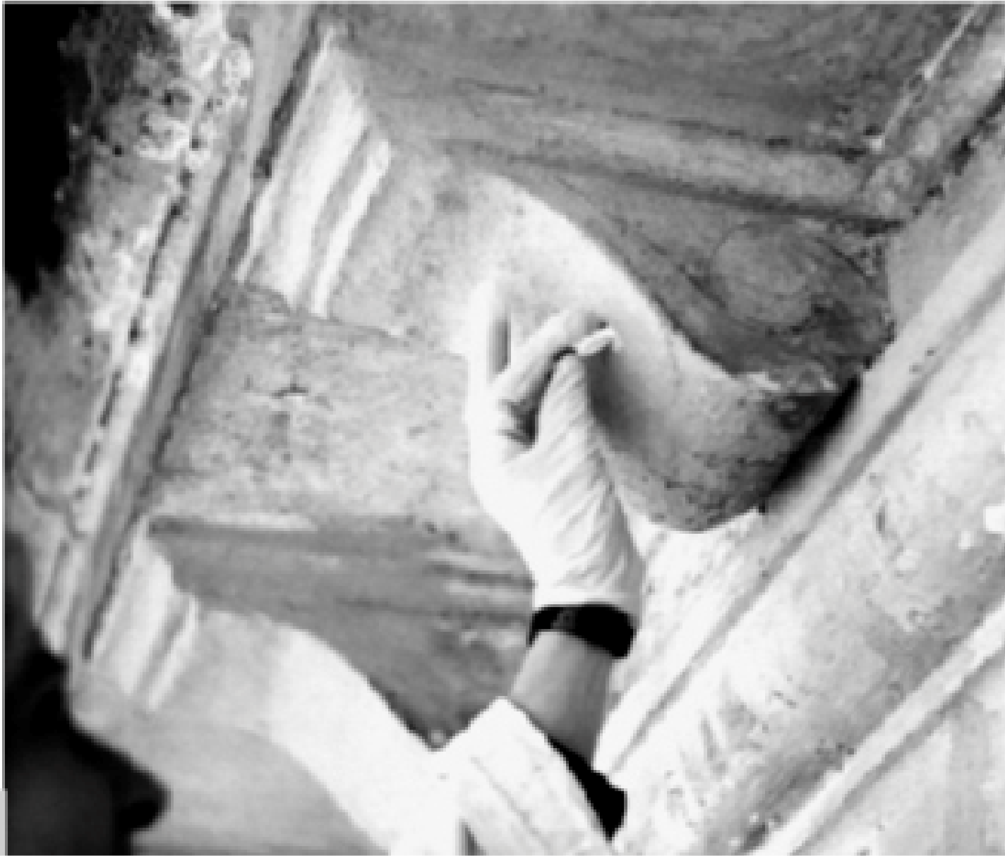
Figura 5 • È inserito il perno di acciaio inox, dopo averlo intinto nella stessa resina utilizzata per il fissaggio. Si inietta la seconda parte di resina.
