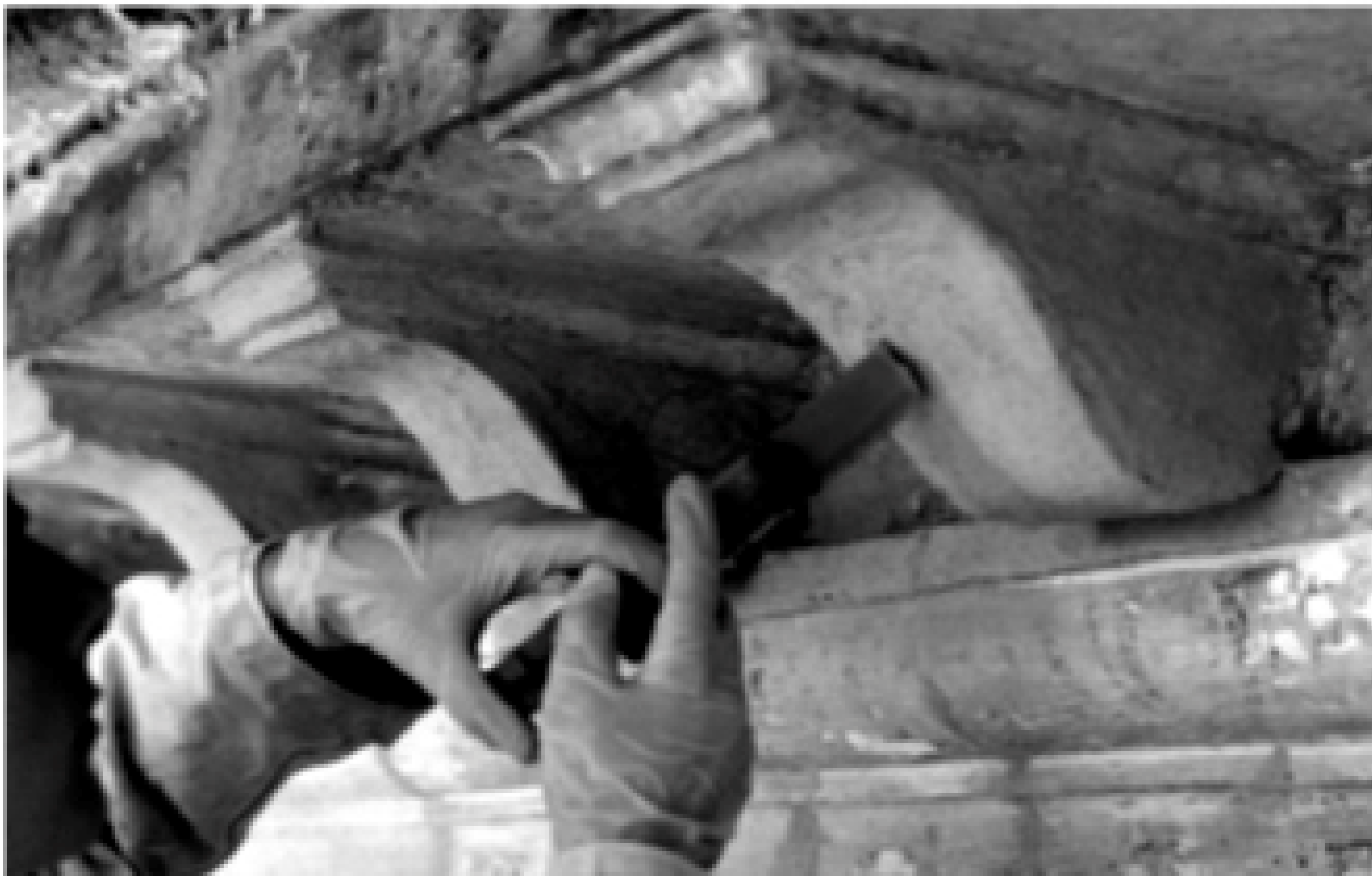
Figura 4 • È iniettata la prima parte di adesivo per fissare la testa del perno.
