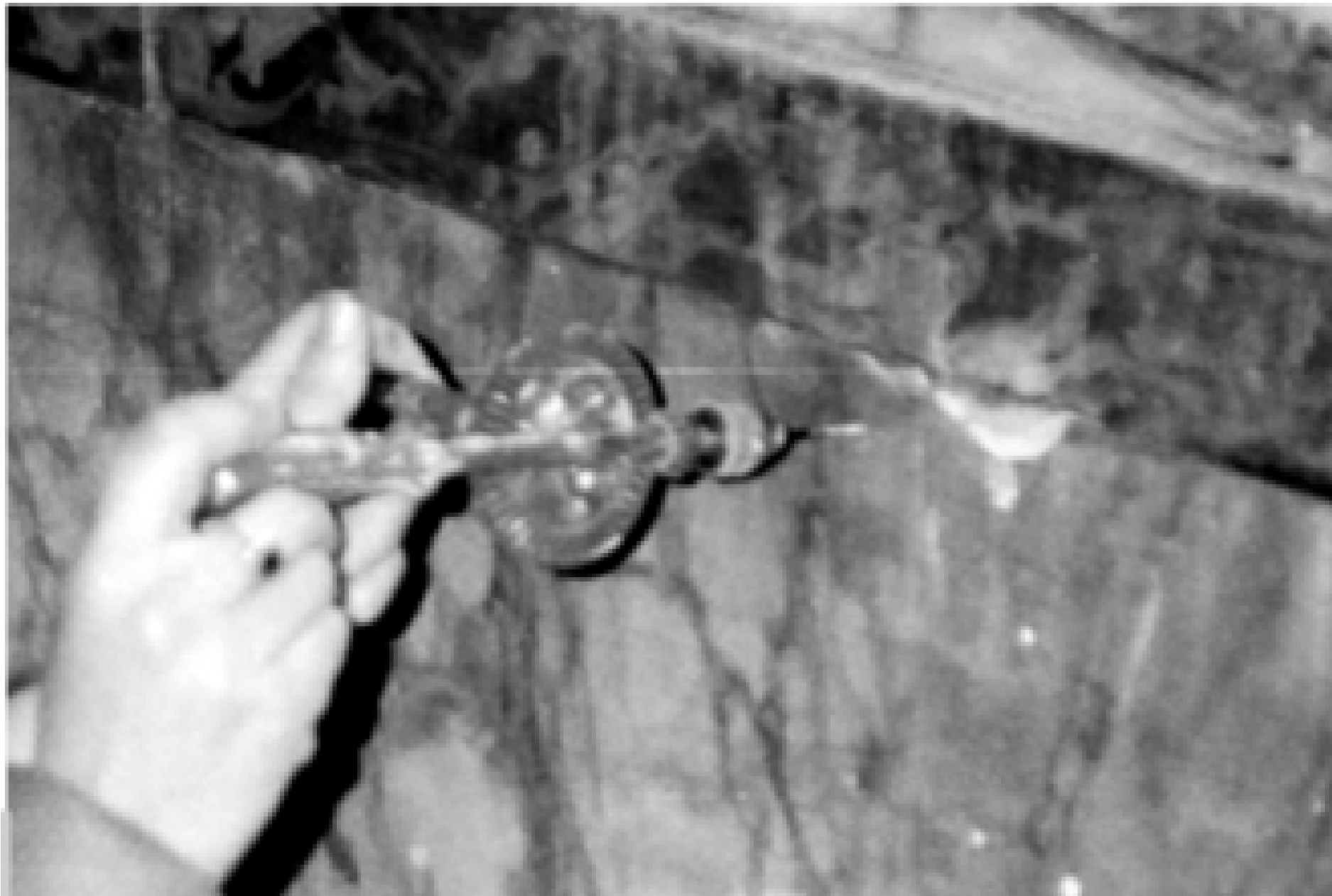
Figura 2 • Esecuzione del foro, con trapano manuale a rotazione, per l'iniezione del consolidante.
