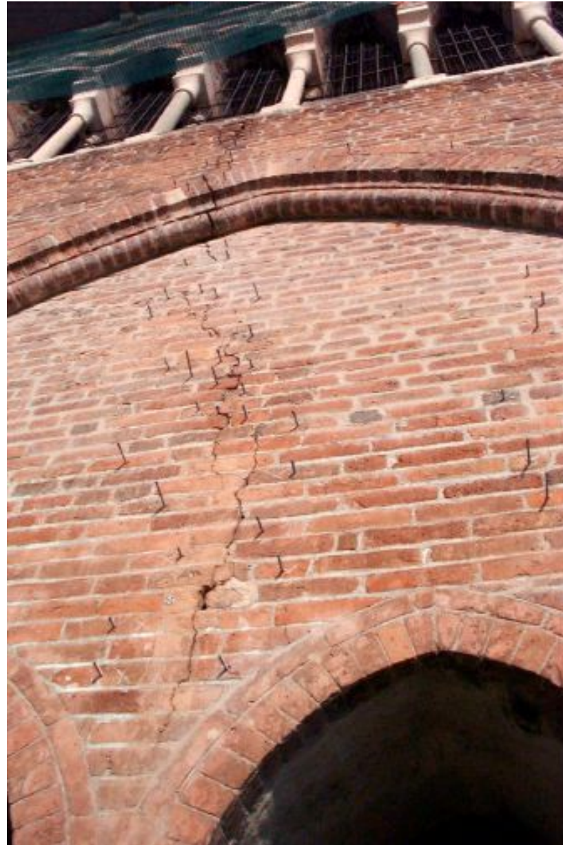
Fig. 6 • Torrazzo di Cremona. Ancoraggio dei laterizi distaccati della cortina esterna con perni in acciaio inox di piccolo diametro.
