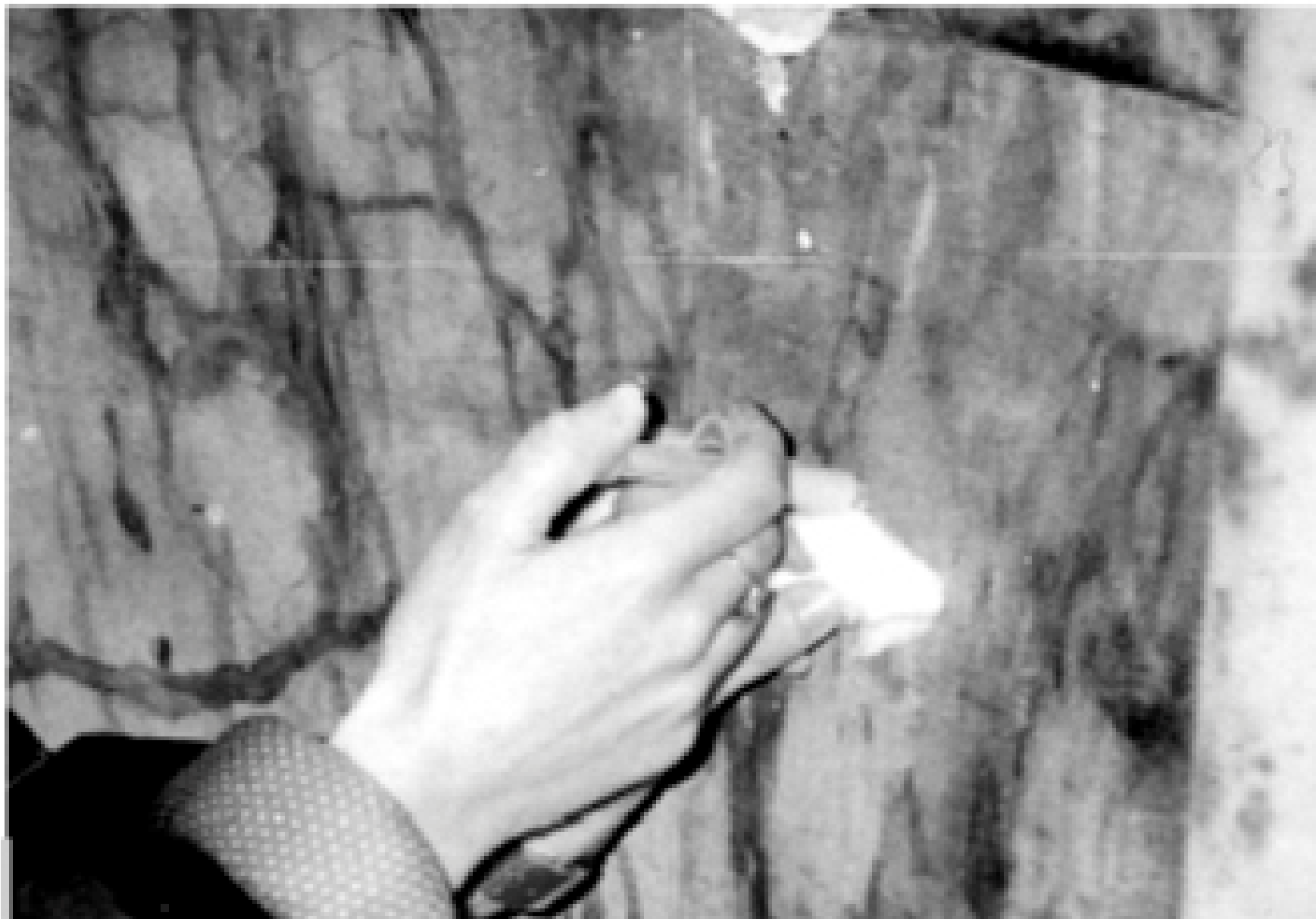
Figura 4 • Iniezione del consolidante. Con una piccola spugna umida si provvede alla immediata pulitura della superficie forata dall'eventuale fuoriuscita del consolidante.
