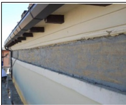
Figura 2.6 – Cordolature di piano realizzate con tessuti di PBO e acciaio.
