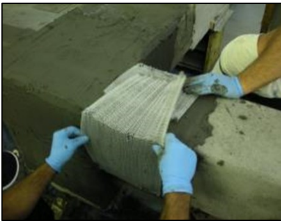
Figura 2.16 – Rinforzo di nodi travi-pilastro con tessuto metallico galvanizzato unidirezionale e malta.
