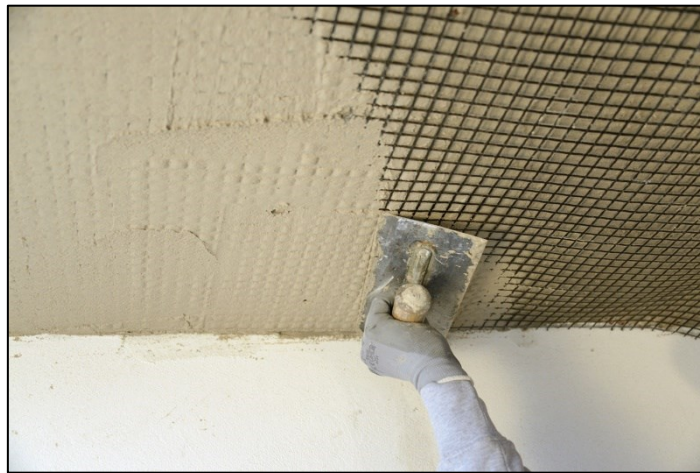
Figura 2.18 – Rinforzo di un solaio (antifondellamento).
