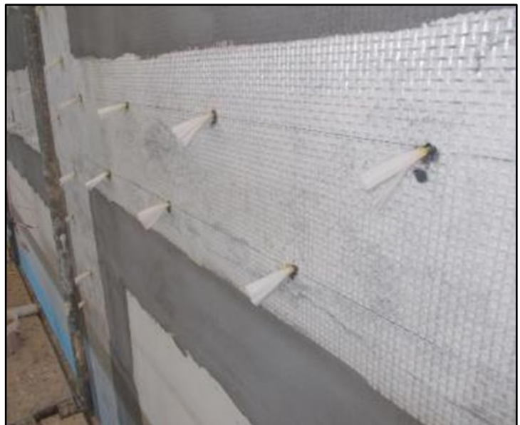
Figura 2.20 – Rinforzo antiribaltamento di pareti con un sistema FRCM, costituito da rete di fibra di vetro, malta, promotore di adesione e fiocchi di fibra di vetro.
