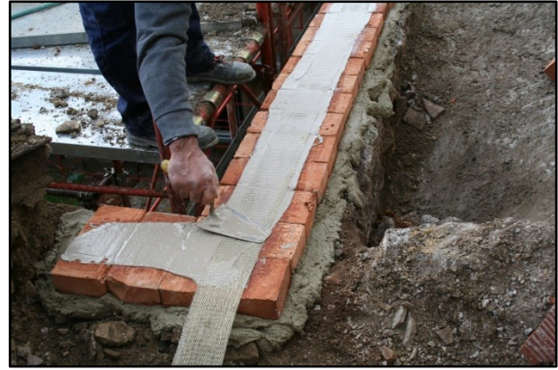
Figura 2.7 – Cordolo sommitale realizzato con tessuti a base di reti di acciaio.
