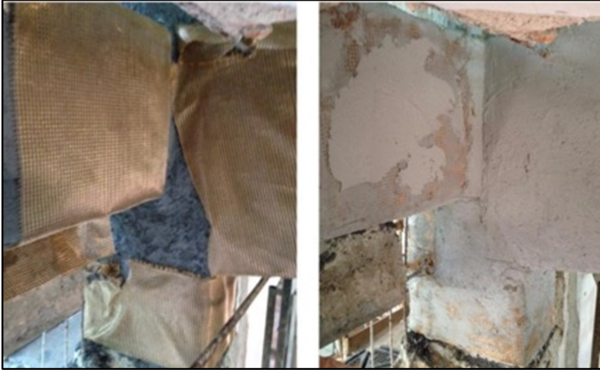
Figura 2.15 – Rinforzo di nodi travi-pilastro.
