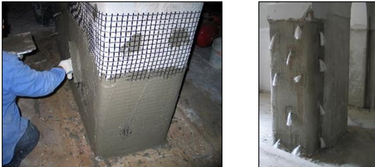
Figura 2.9 – Confinamento di pilastro di muratura con rete di vetro A.R.
