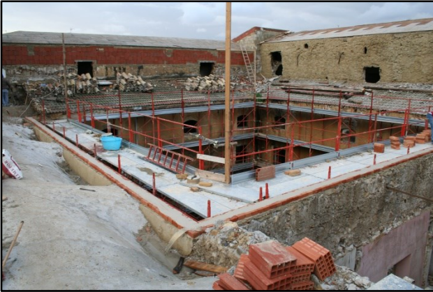
Figura 2.7 – Cordolo sommitale realizzato con tessuti a base di reti di acciaio.
