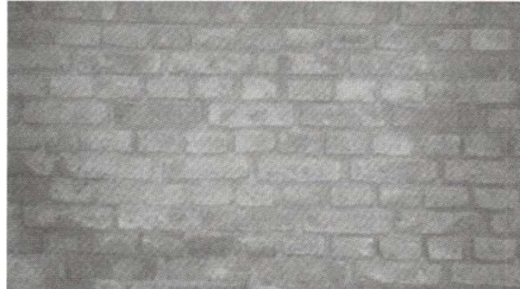
Mattoni pieni e malta di calce
