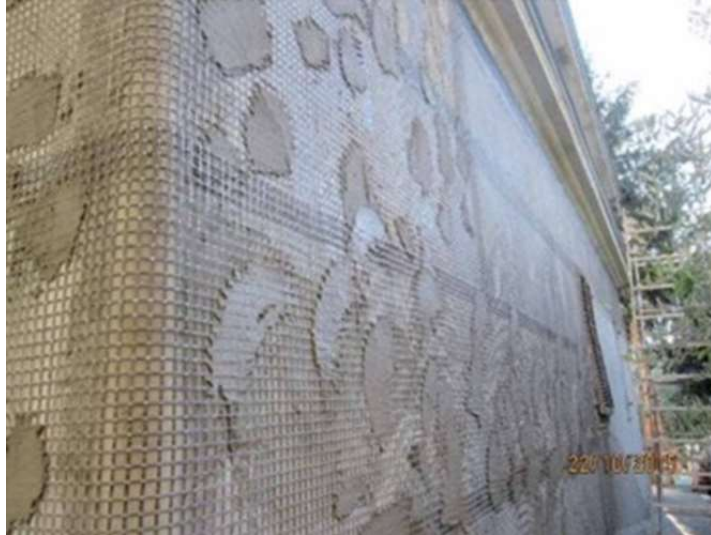
Rinforzo muratura con rete in basalto
