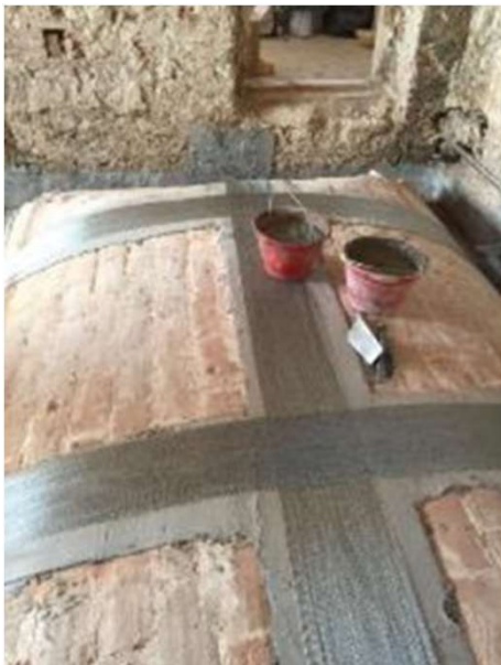
Rinforzo muratura con rete in basalto
