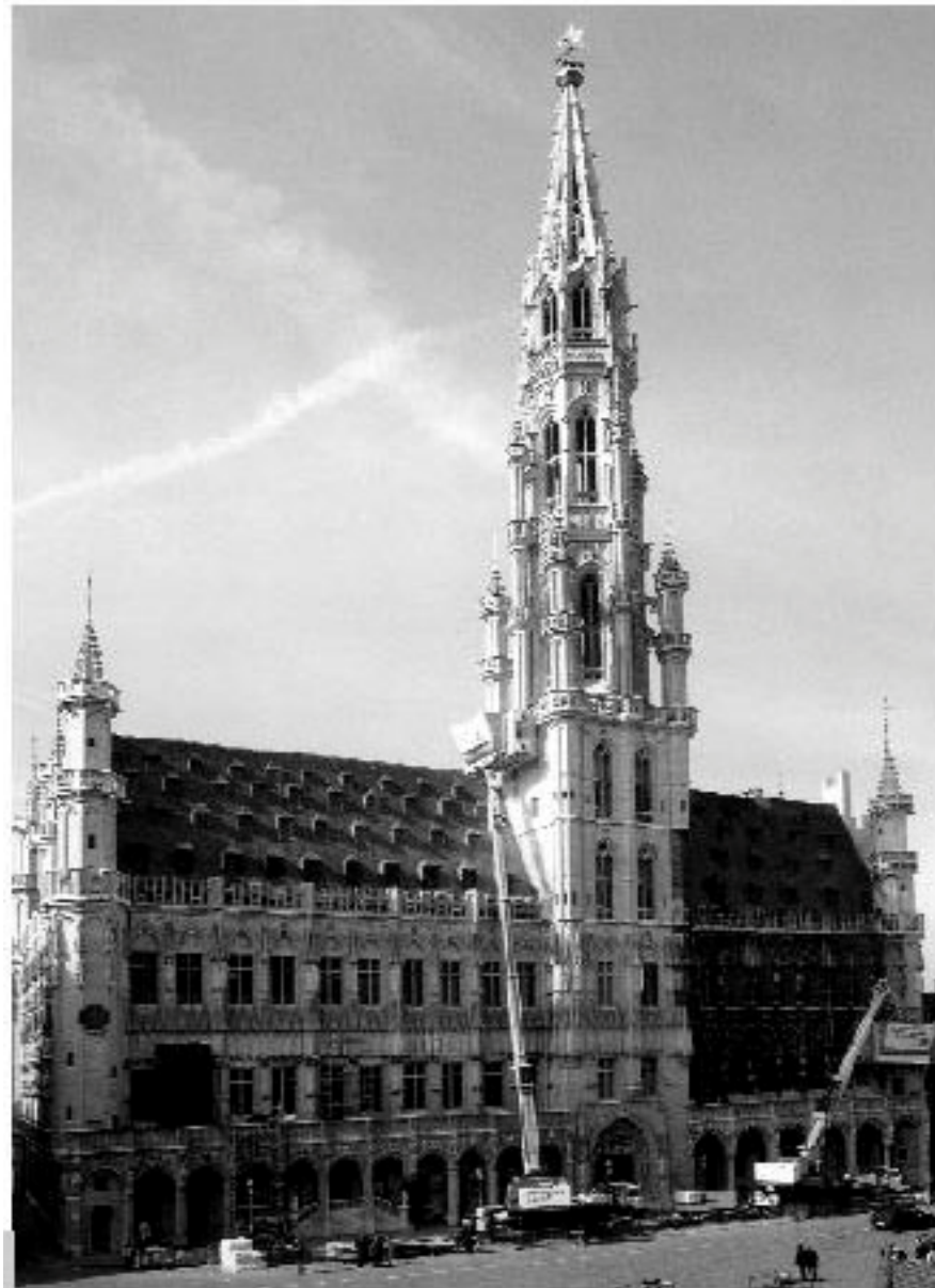
Figura 5 • La tecnica del gommage applicata alla pulitura di un edificio alto e con accentuati rilievi e aggetti. (VAC)
