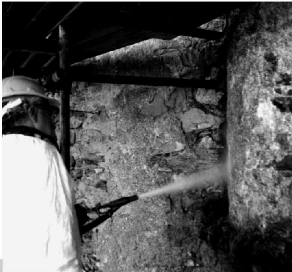
Figura 2 • Addetto alle operazioni di idropulitura. Prima di dare avvio all'intervento si deve provvedere alla stuccatura di tutte le connessioni e le fessure presenti in superficie, onde impedire la penetrazione dell'acqua in profondità ed un dannoso aumento dell'umidità della struttura muraria.
