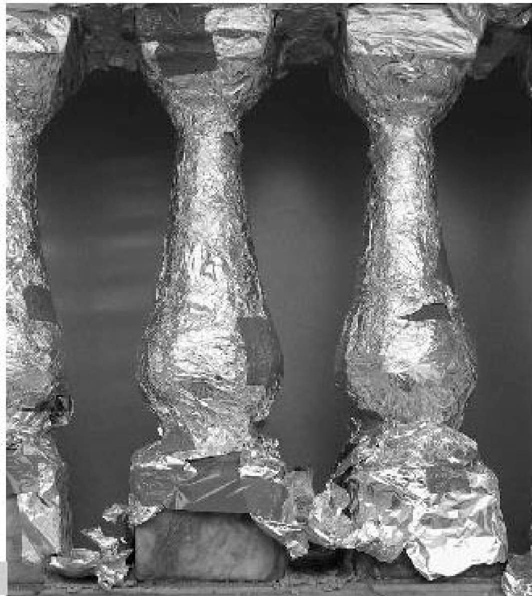
Figura 1 • Pulitura di elemento lapideo da incrostazioni mediante impacco di argille adsorbenti. Si noti l'uso di fogli di alluminio per rallentare l'evaporazione del solvente.
