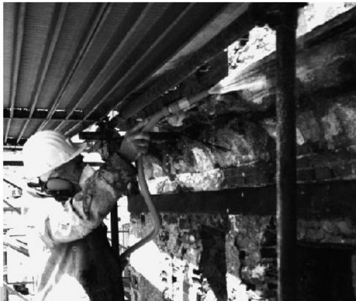
Figura 3 • L'intervento di idrosabbatura deve sempre concludersi con un lavaggio finale, mirato ad agevolare la solubilizzazione dei residui di sporco ormai ammorbiditi ancora presenti, nonché a favorire l'allontanamento dell'abrasivo depositato in superficie o penetrato negli interstizi e nei macro-pori del materiale. Eventuali trattamenti protettivi devono essere eseguiti al termine del processo d'evaporazione dell'acqua in esubero.
