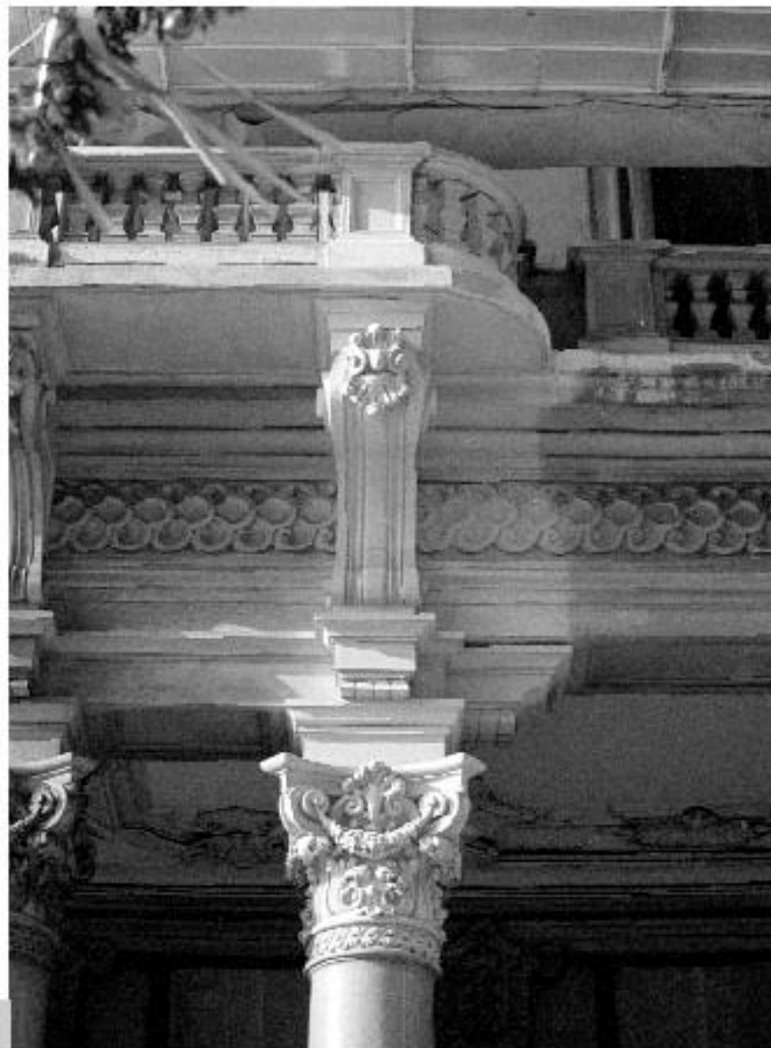
Figura 3 • Effetto pulente su un insieme di modanature con forti variazioni altimetriche e presenza di sottosquadri.(VAC)
