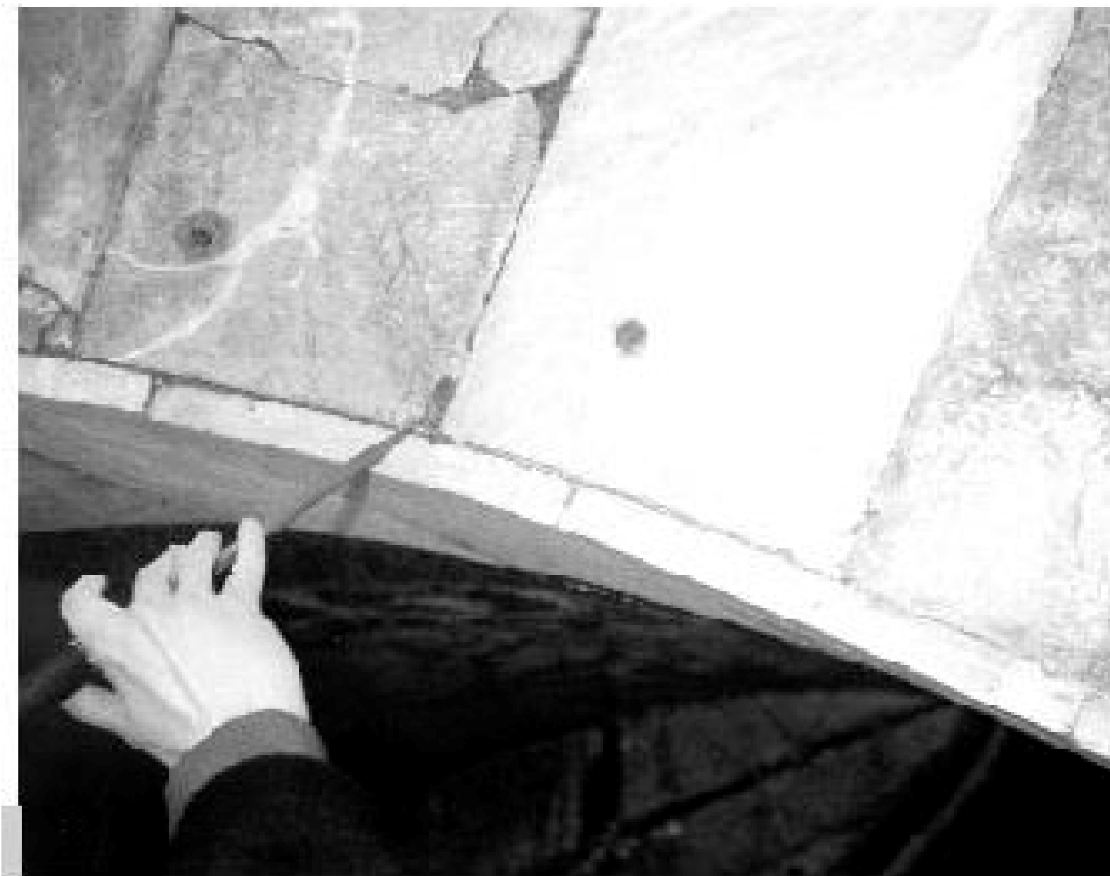
Figura 4 • Eliminazione in opera di vecchio stucco. (OPD)
