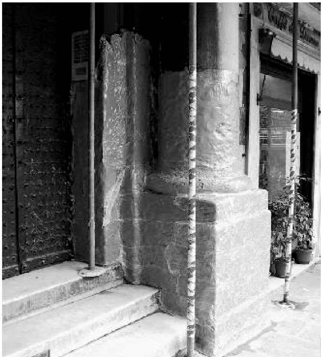
Figura 2 • Pulitura con impacchi di argille adsorbenti. In questo caso il rallentamento dell'evaporazione è assicurato da fogli di polietilene.
