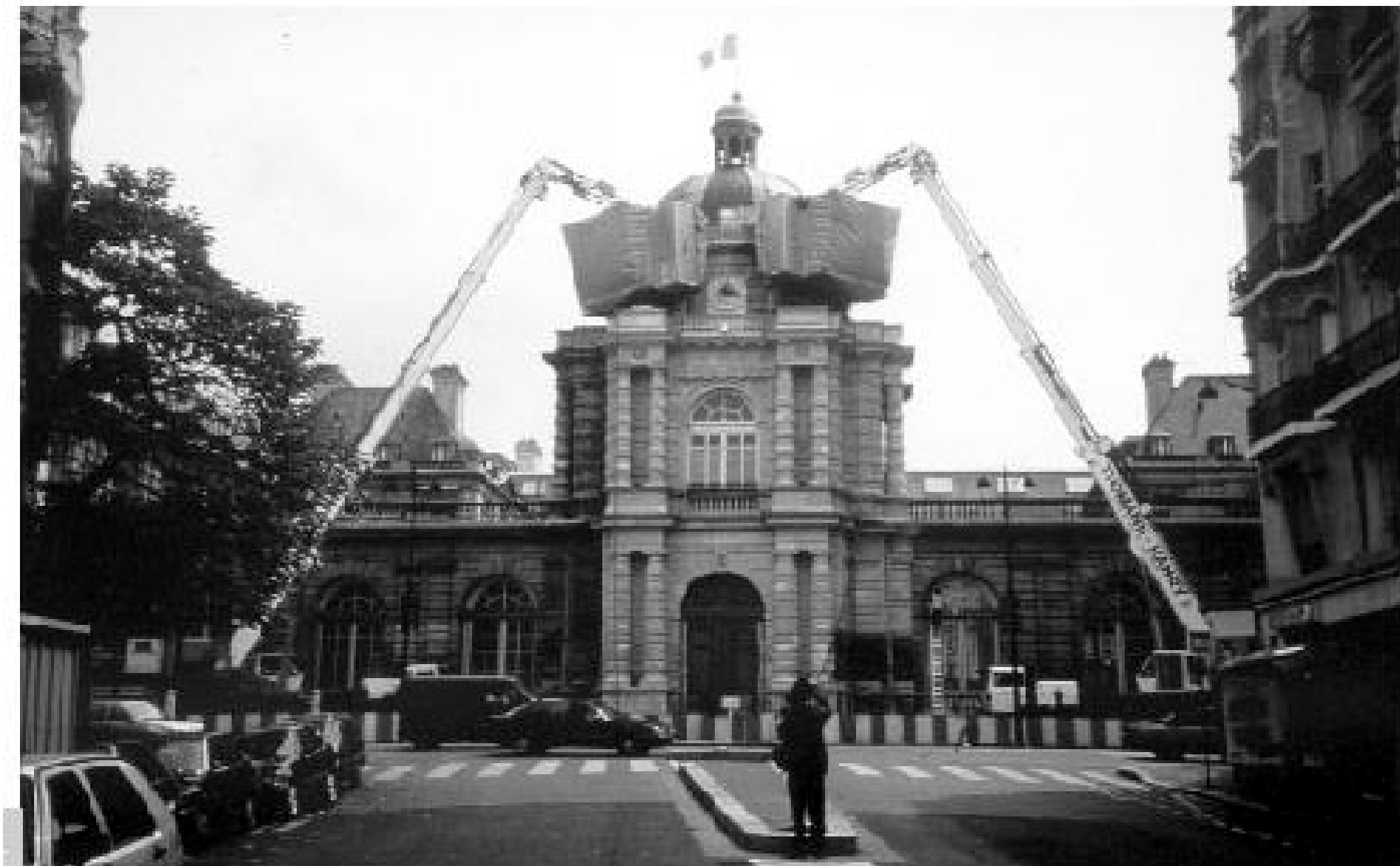
Figura 6 • Azione congiunta di due impianti durante la pulitura di una cupola. (VAC)
