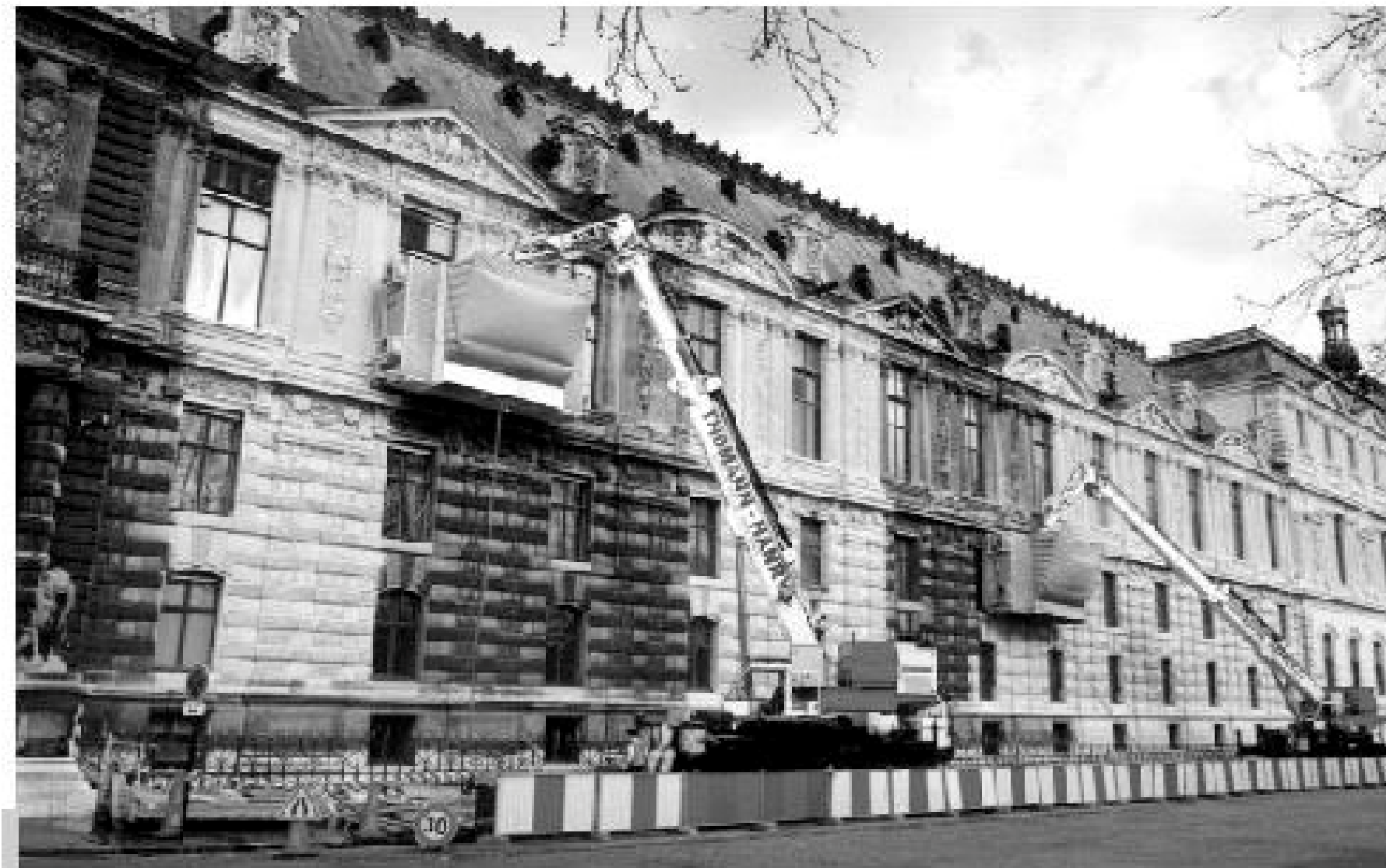
Figura 4 • Due cabine di pulitura lavorano contemporaneamente alla pulitura di una cortina edilizia. Si notano le barriere protettive dell'area di manovra degli automezzi e sono visibili le aree ancora da pulire e quelle già trattate. (VAC)
