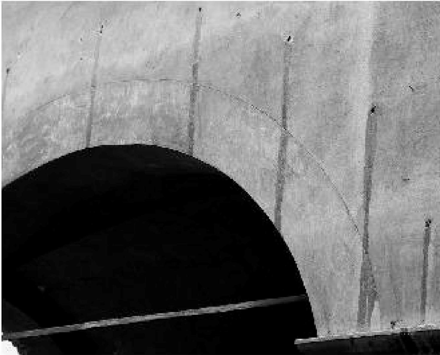
Figura 9 • Applicazione errata della tecnica, con fuoriuscita del prodotto consolidante dai fori di iniezione e conseguente formazione di colature difficilmente eliminabili.
