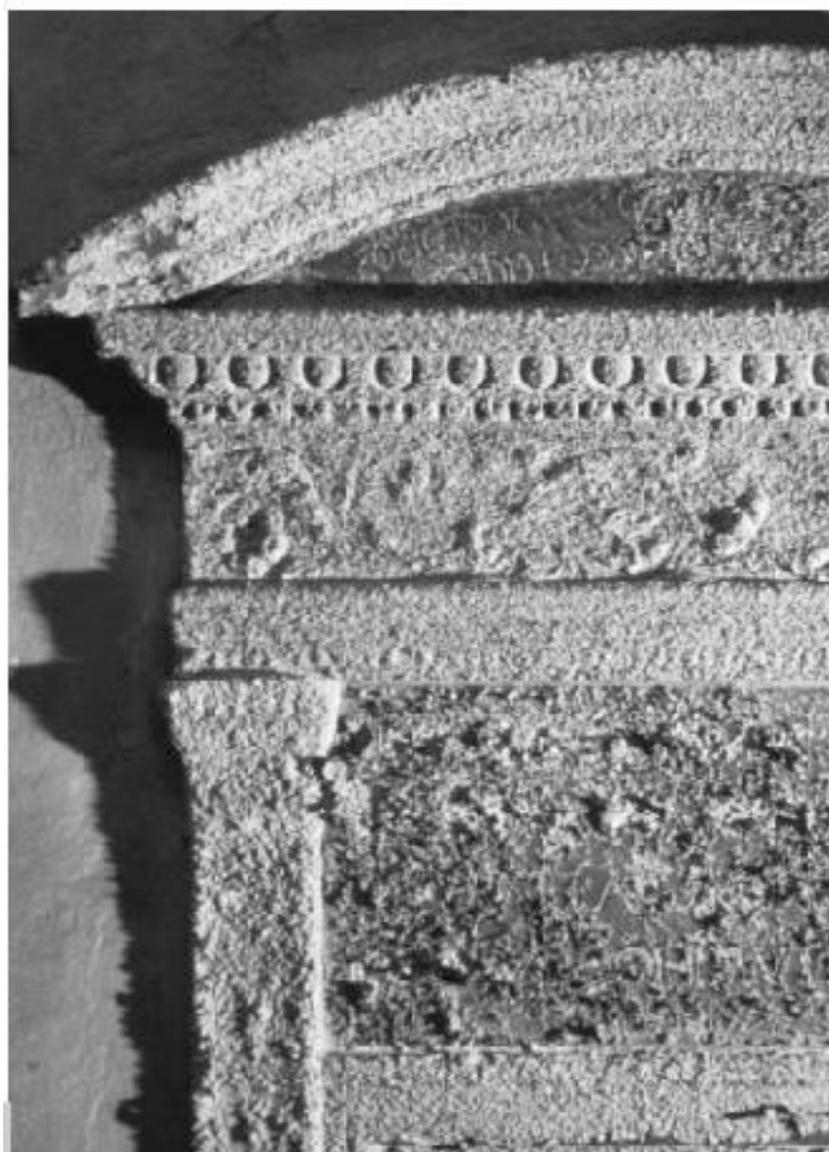
Figura 1 • Superficie lapidea fortemente decoesa sulla quale sono necessari interventi di pulitura che potrebbero essere incompatibili con la fragilità della superficie stessa e determinare perdite o distacchi irreversibili di materiale. (NFM)
