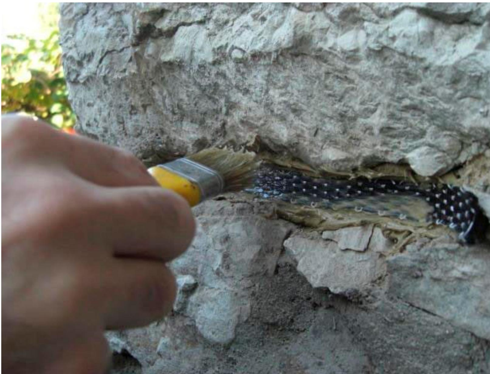
Figura 16d • Fasciatura inserita nei giunti di malta. Saturazione dei nastri in fibra in carbonio con resina epossidica fluida. (IAR)
