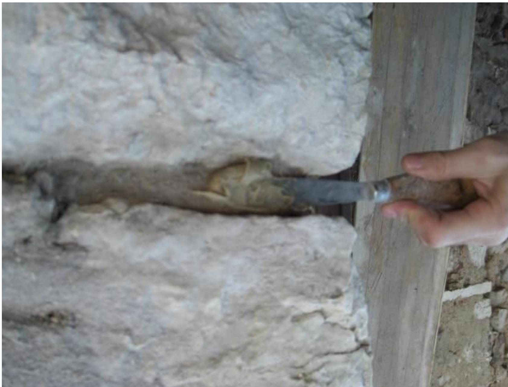
Figura 16b • Fasciatura inserita nei giunti di malta. Stesura dell'adesivo epossidico a consistenza di stucco. (IAR)
