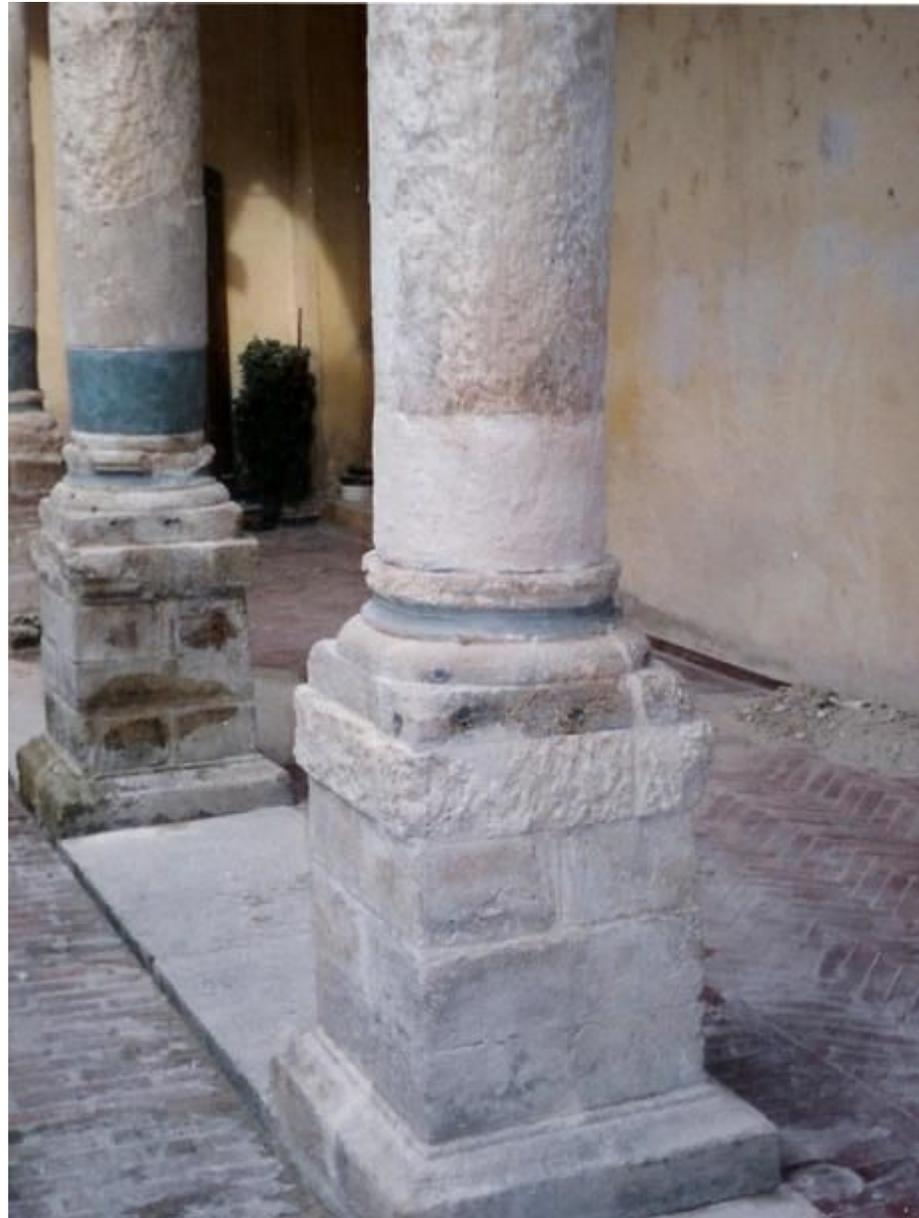
Figura 15 • Fasciature applicate alla base delle colonne. Nella colonna in primo piano è visibile la finitura con malta (calce naturale e inerti ricavati dalla frantumazione del medesimo litotipo della colonna). (KIMIA)
