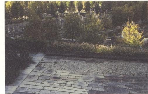
1 et 2 : Appareillages de la calade et des dalles calcaires.
