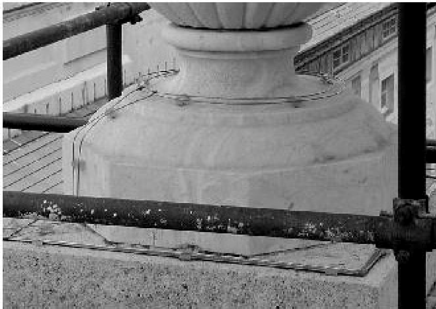
Figura 13 • Protezione di un elemento cuspidale in marmo con sistema elettrostatico.
