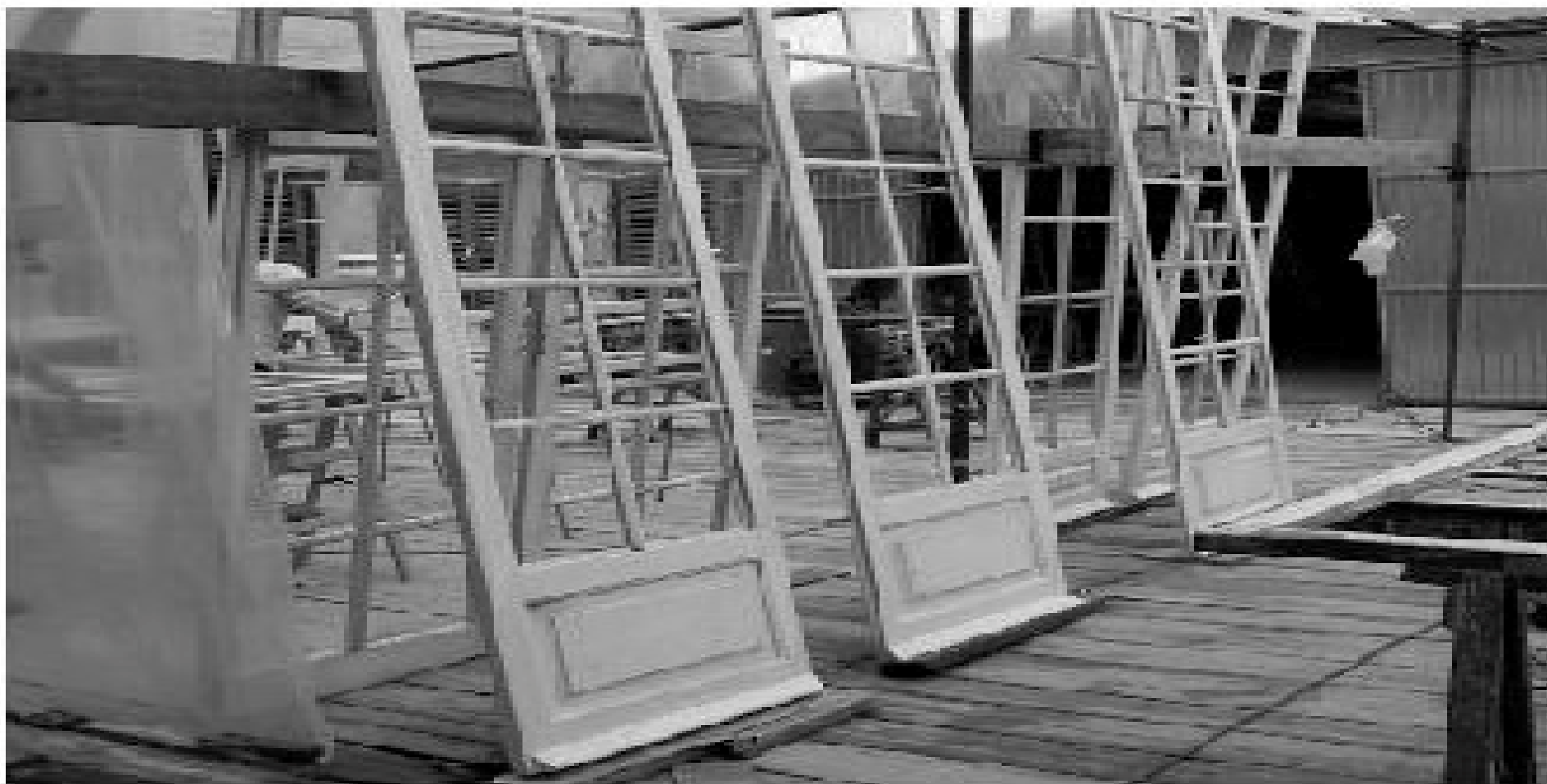
Figura 6 • Asciugatura dopo l'applicazione degli strati di coloritura.
