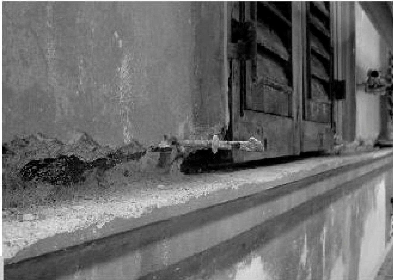
Figura 5 • Rimozione delle copertine in ardesia irrecuperabili e preparazione dello scasso, per accogliere le nuove.
