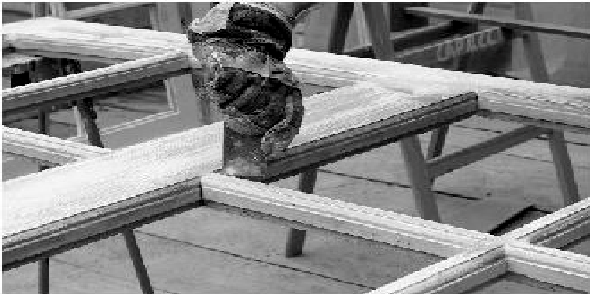
Figura 4 • Pulitura con raschietto.
