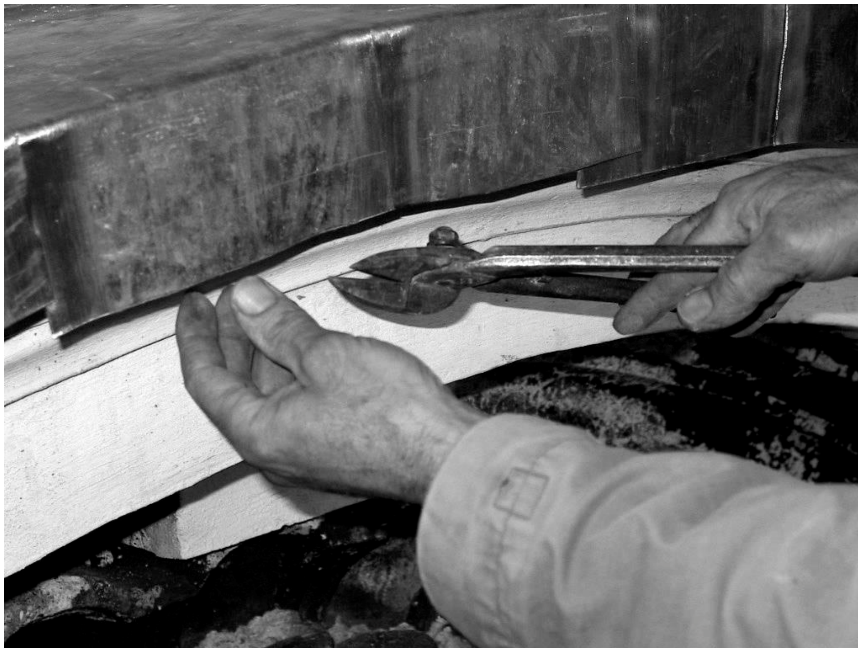
Figura 12 • Taglio con cesoie del materiale in eccesso.
