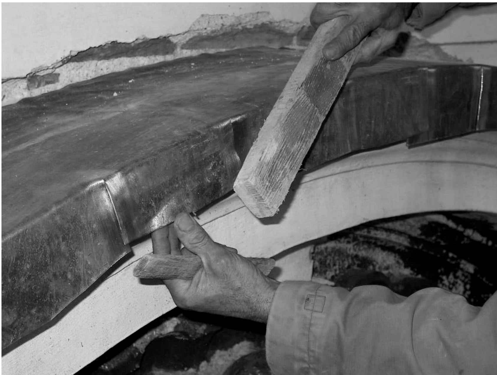
Figura 10 • Dettaglio dell'operazione di ribattitura del foglio di piombo.
