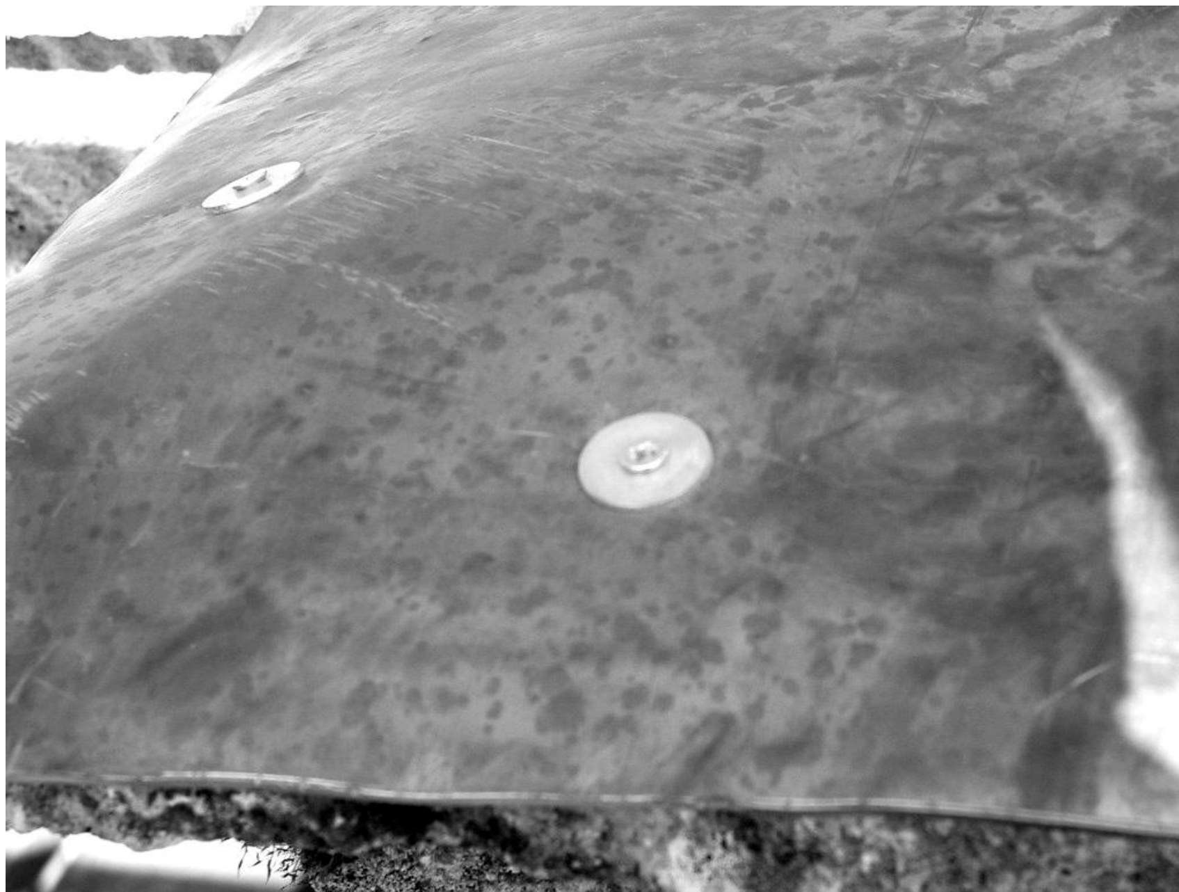
Figura 18 • Fissaggio di un foglio di piombo di grandi dimensioni con viti a espansione.
