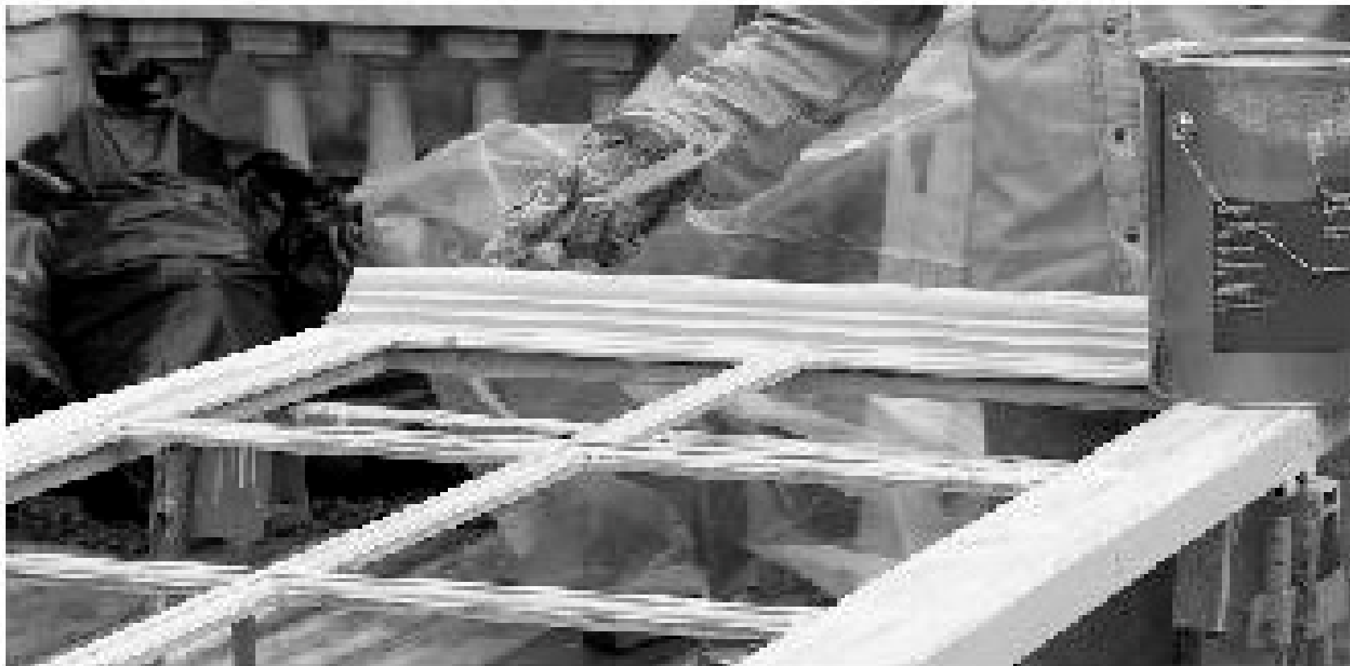
Figura 2 • Stesura a pennello del fondo.
