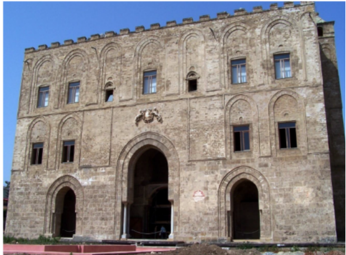
La Zisa, Facciata principale.
