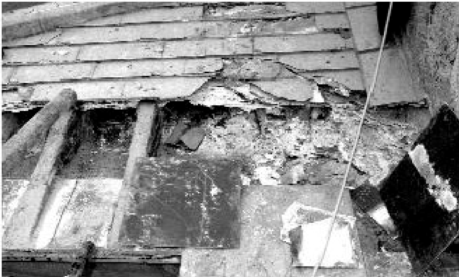
Figura 3 • Sostituzione graduale delle lastre d'angolo.
