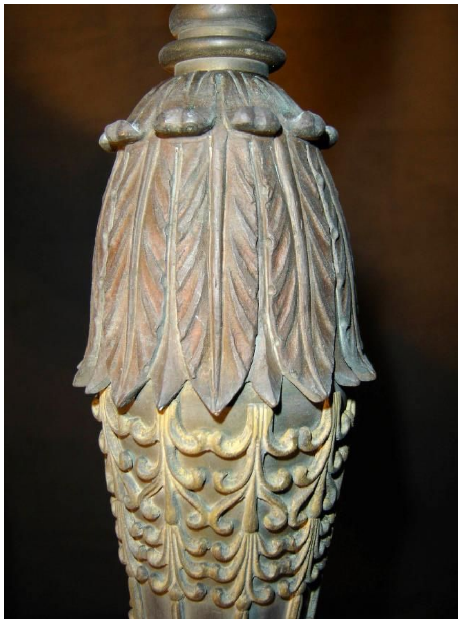
Figura 2 • Particolare del balaustrino dopo la pulitura effettuata tramite spazzolini con setole sintetiche a microtrapano e a mano, avendo cura di preservare la patina originale. (DEMMELEBAUER)
