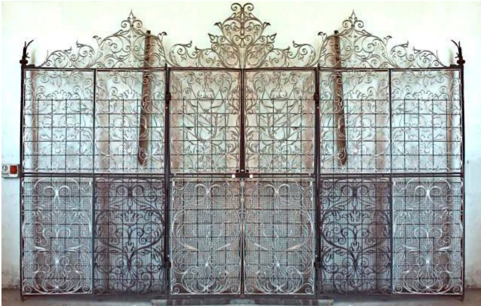
Figura 8 • Villa Barbaro a Maser. Cancellò seicentesco pulito impropriamente con sabbatura a secco e bagno acido e successivamente sottoposto a zincatura a caldo. Tali trattamenti hanno alterato in modo irreversibile le caratteristiche fisiche e chimiche della superficie metallica. Il cancellò, inoltre, è stato rimosso dalla collocazione originaria mediante tagli che hanno lasciato monconi residui delle volute decorative alle estremità superiori destra e sinistra. (TORSELLO)
