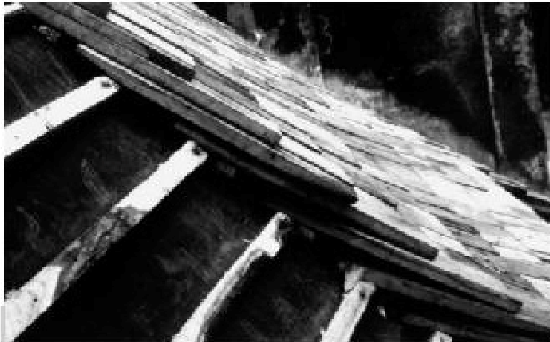
Figura 13 • Posa in opera di scandole in legno.
