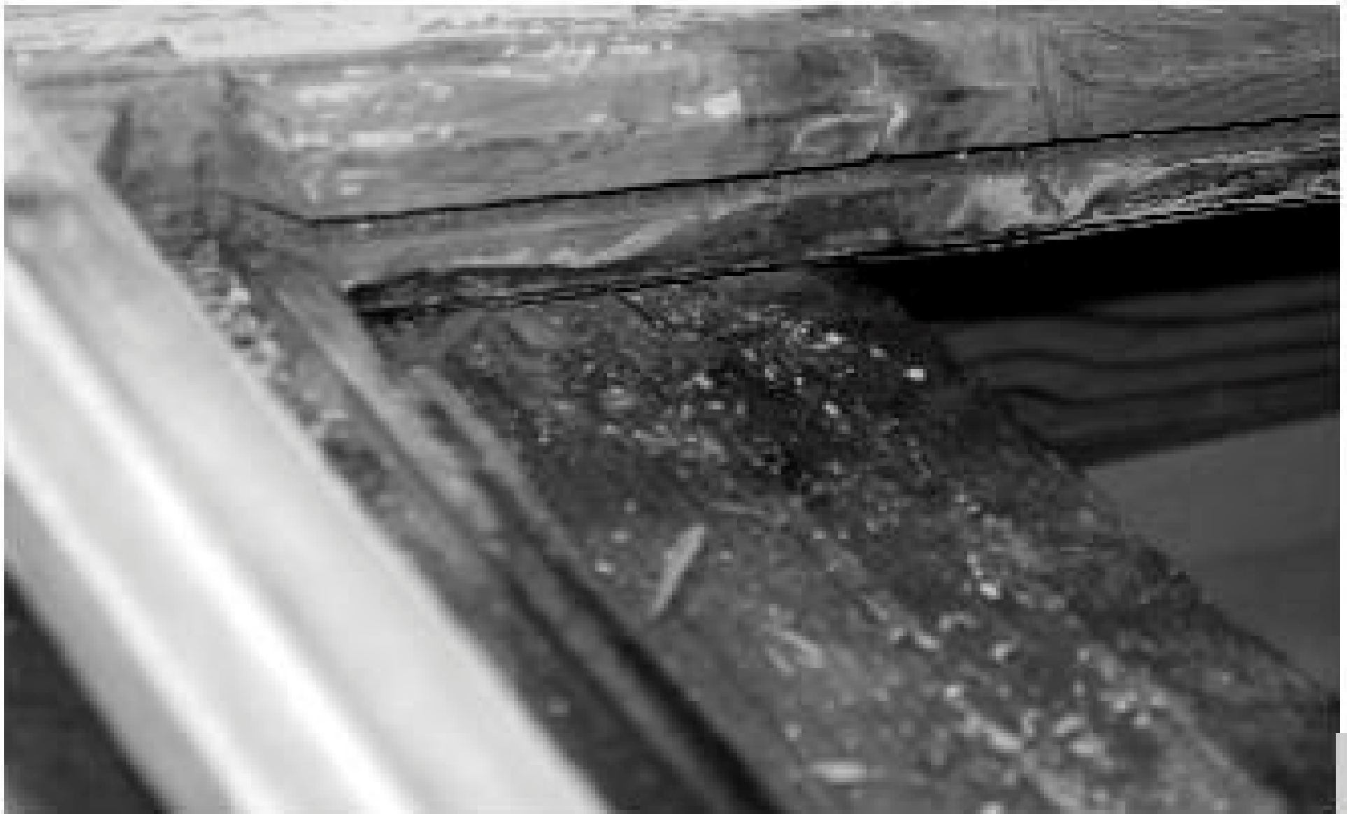
Figura 3 • Sede del vetro a infilare, dopo la rimozione della lastra e l'inizio della pulitura.
