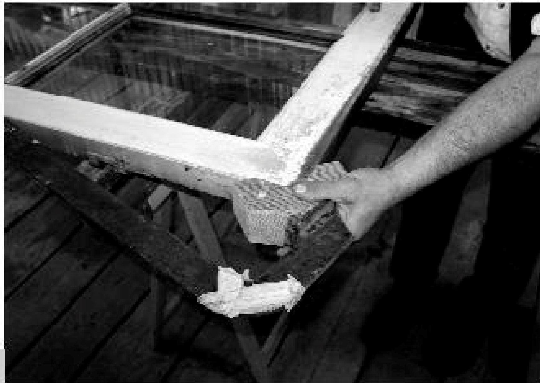
Figura 7 • Operazione di serraggio dell'incastro.
