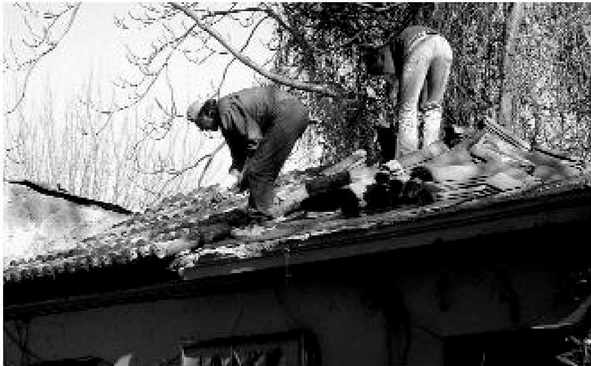
Figura 14 • Sostituzione di coppi in condizioni di precaria sicurezza per gli operatori.
