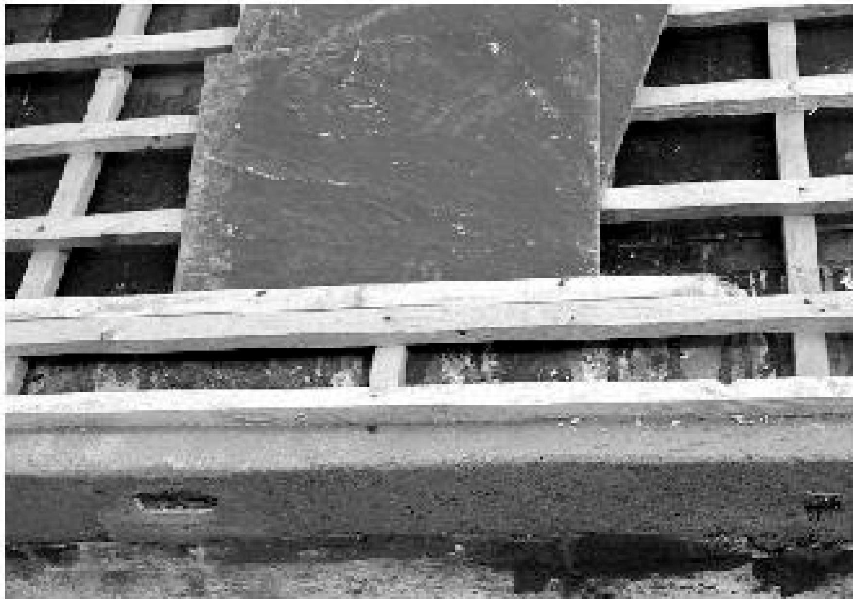
Figura 10 • Un abbadino posato sulla nuova struttura lignea e pronto per essere fissato.
