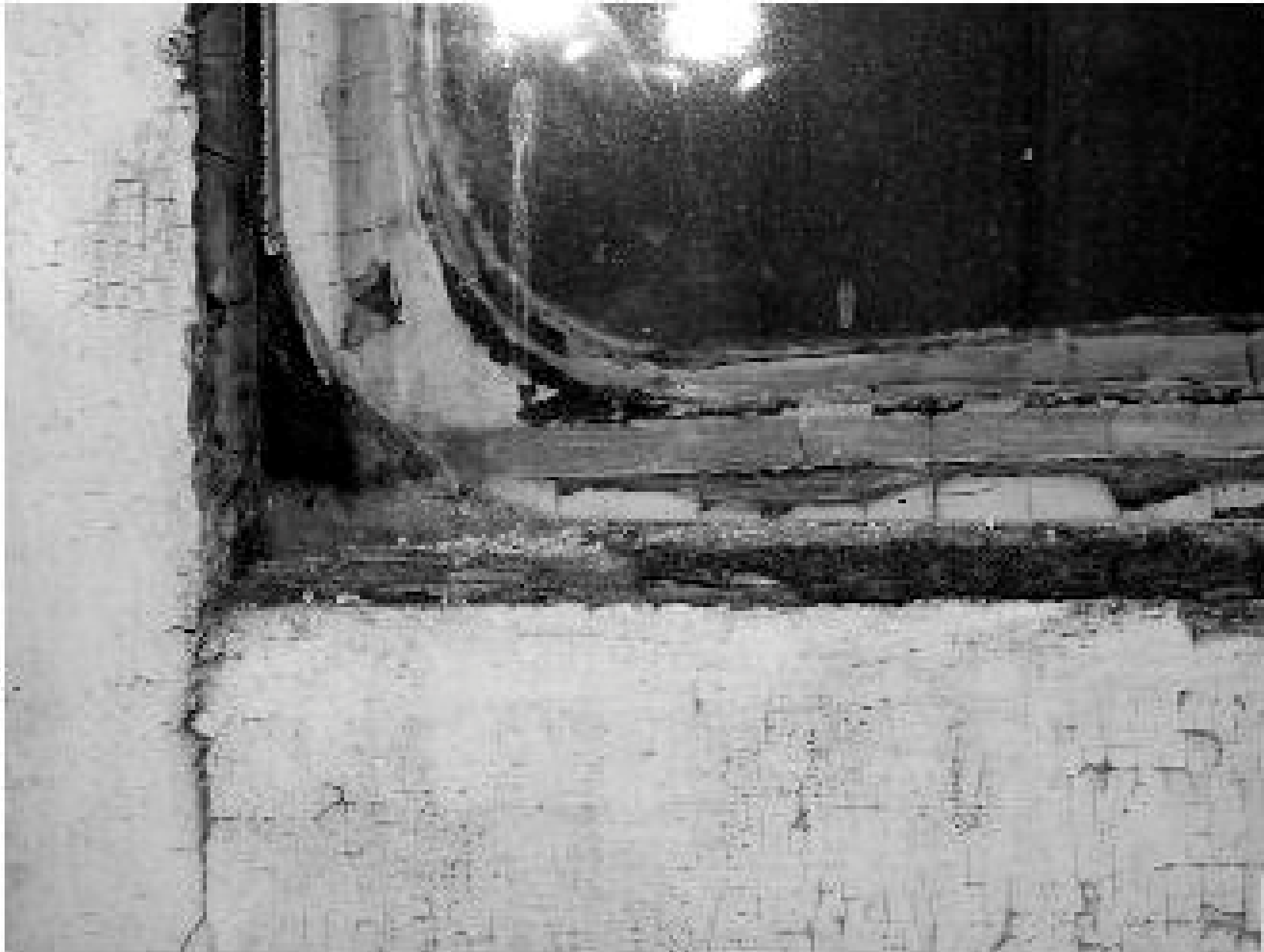
Figura 5 • Vecchio stucco fermavetri su un angolo a smusso tondo.
