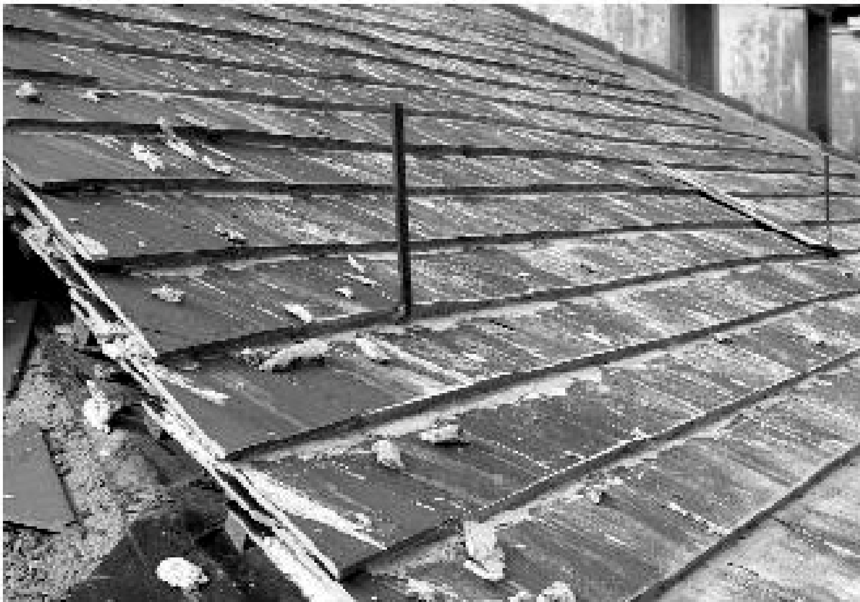
Figura 12 • Elementi metallici di ancoraggio di un muretto d'attico al manto di abbadini.
