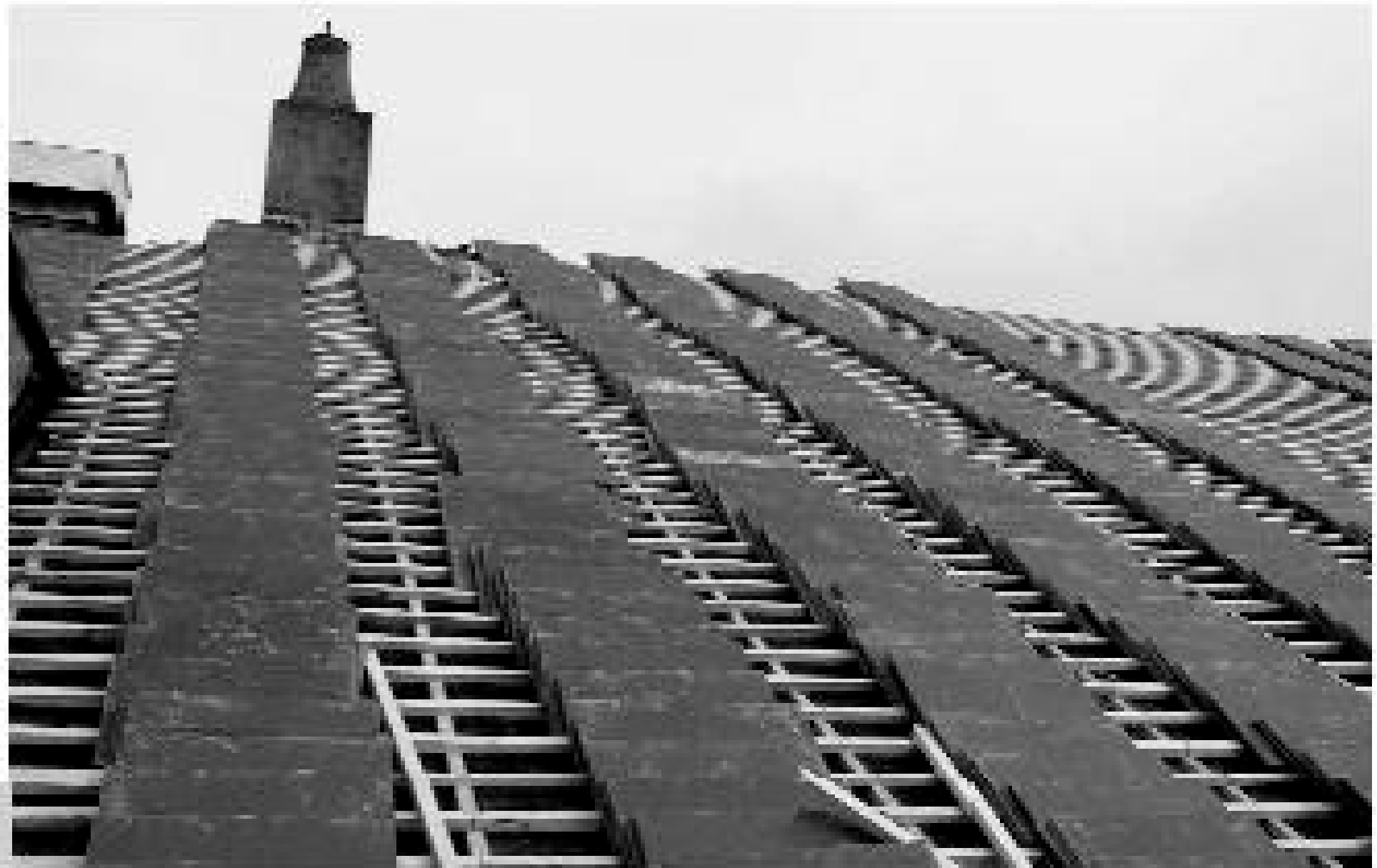
Figura 8 • Abbadini di ardesia disposti sul telaio di travicelli per essere montati con ganci.
