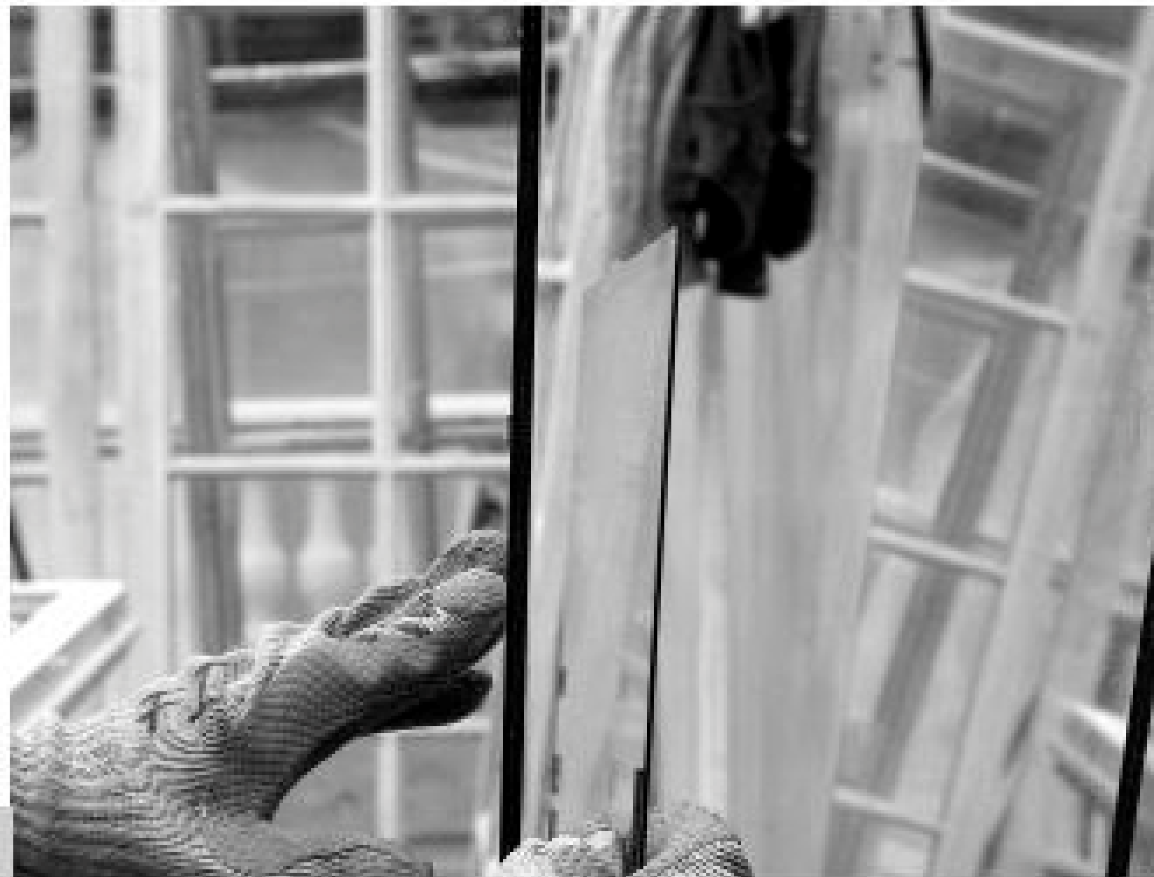
Figura 6 • Ricollocazione di una lastra di cristallo.
