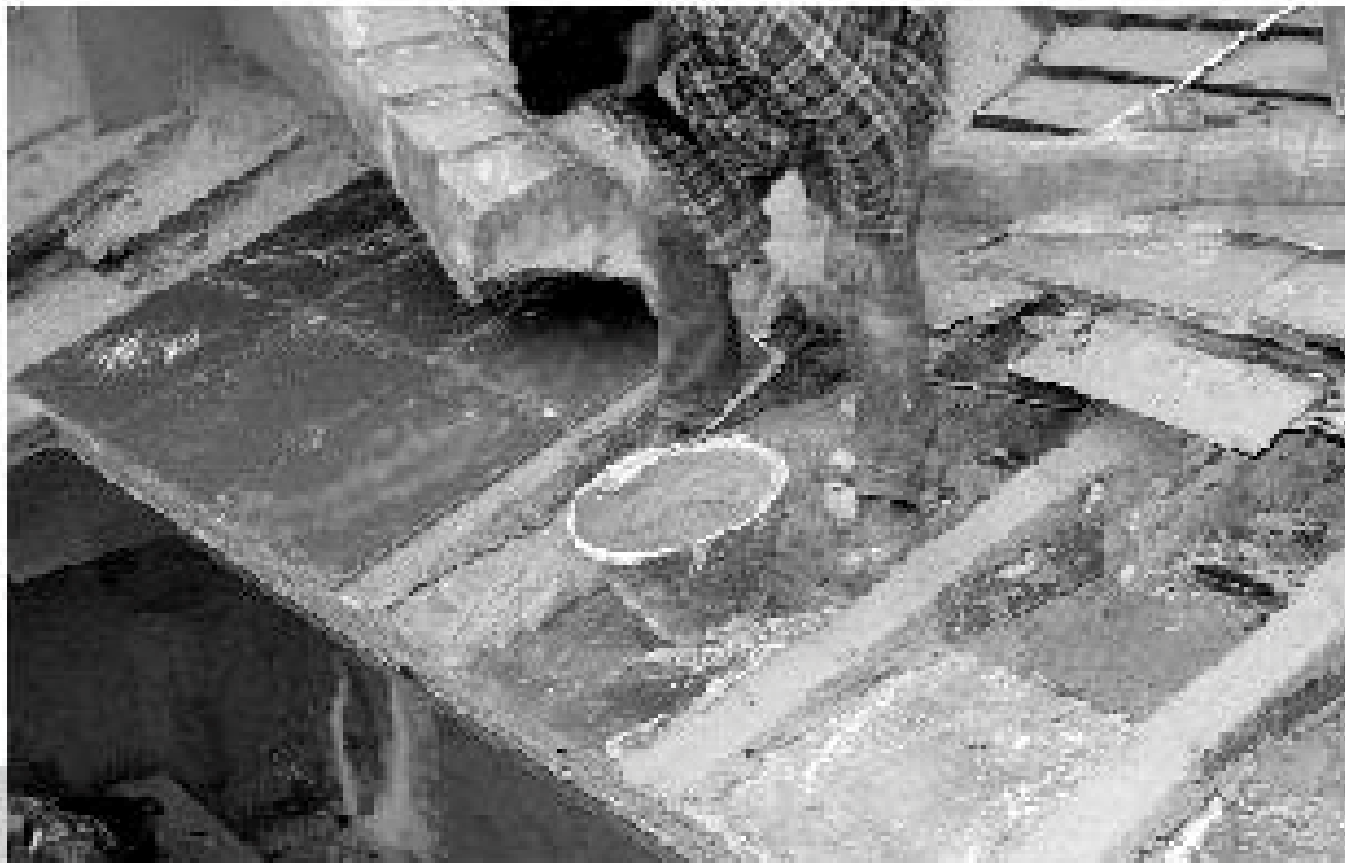
Figura 2 • Messa in opera delle lastre di gronda.
