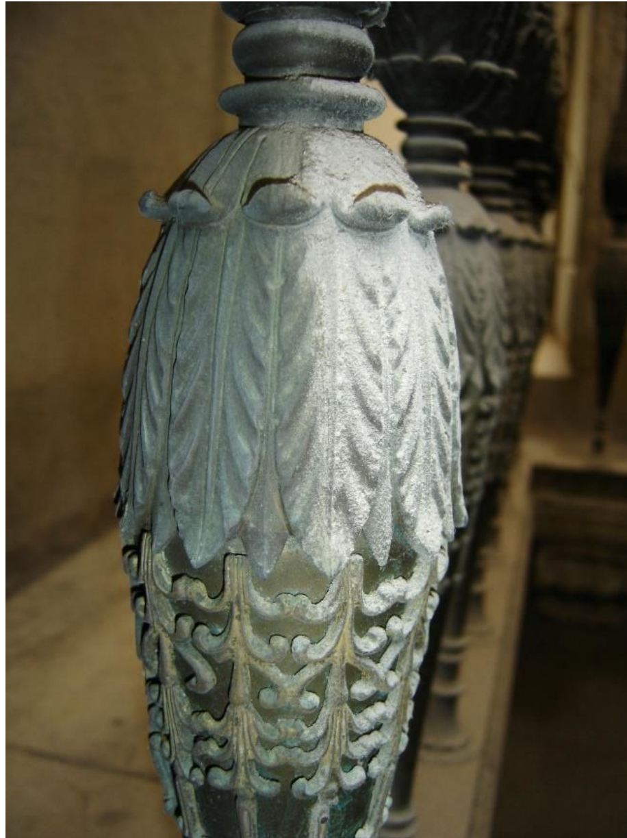
Figura 1 • Palazzo Nobile di Villa Torlonia (Roma). Particolare di un balastrino con evidente accumulo di particellato. (DEMMELEBAUER)
