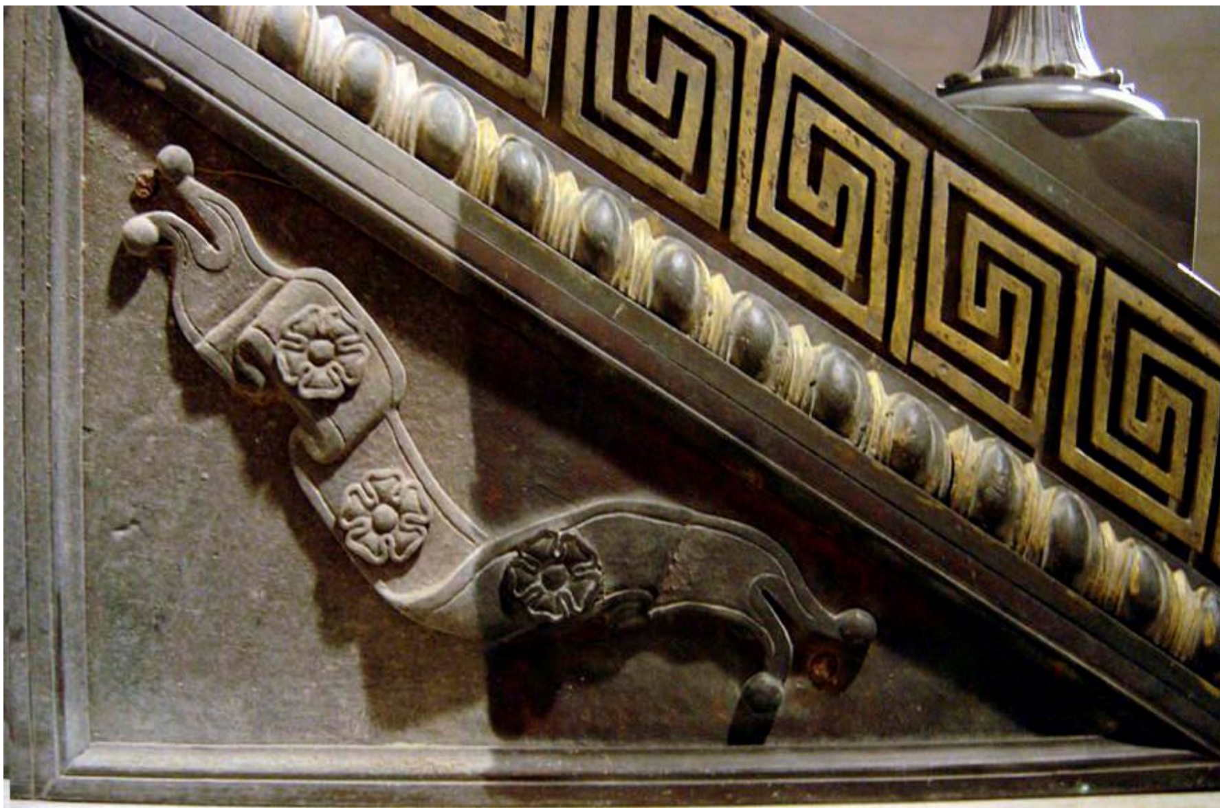
Figura 3 • Palazzo Nobile di Villa Torlonia (Roma). Particolare di una formella della ringhiera durante la stesura del protettivo a base di resina acrilica e benzotriazolo. Il protettivo oltre a proteggere il metallo dalla corrosione, esalta le decorazioni. (DEMMELEBAUER)
