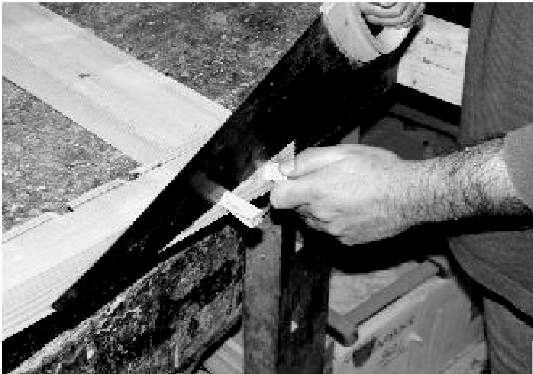
Figura 12 • Taglio delle zeppe di forzatura degli incastri.
