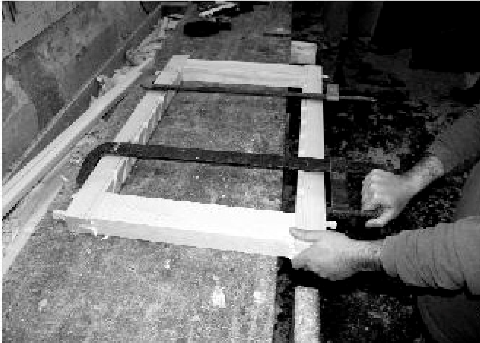
Figura 10 • Rifacimento di parte dello sportello di una persiana. Fase di assemblaggio e incollaggio del telaio.
