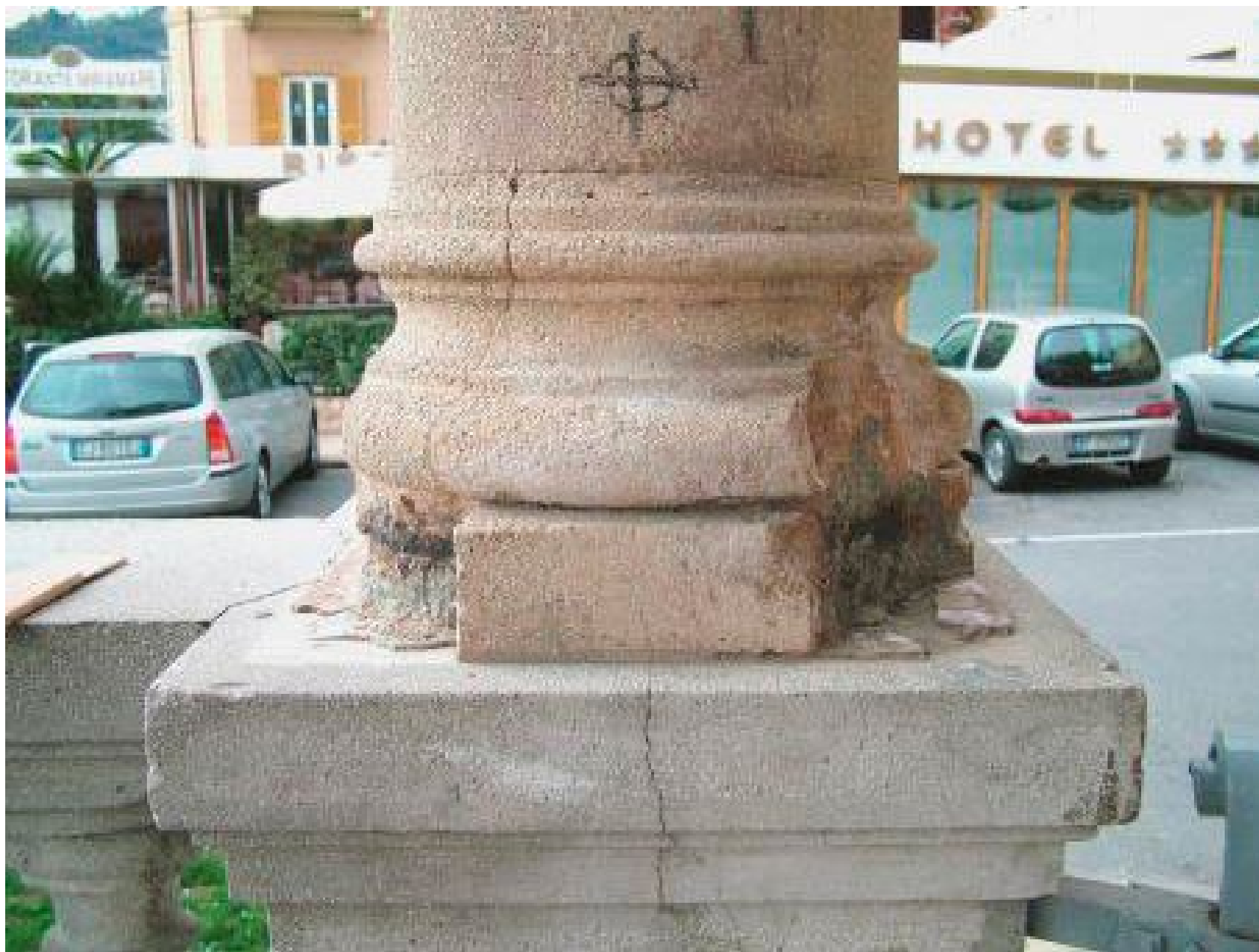
Figura 15 • Mancanze in un basamento in pietra artificiale.
