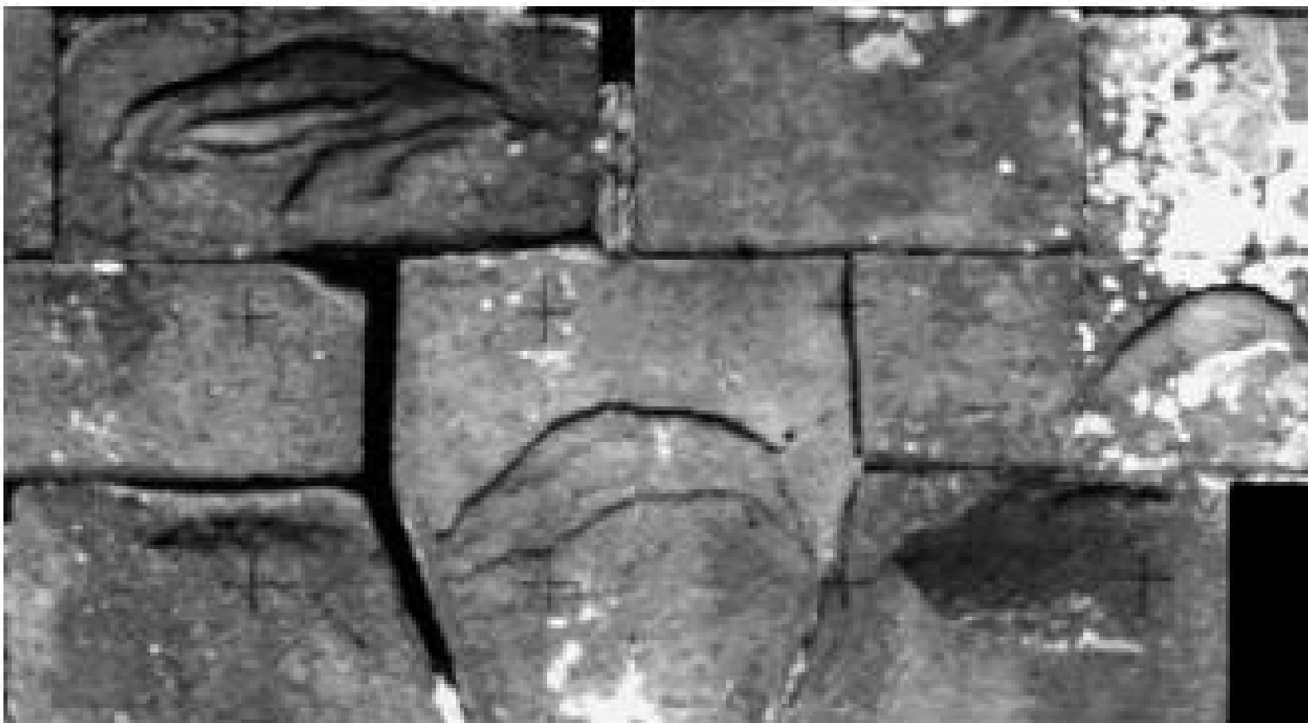
Figura 8 • Pieve di S. Lorenzo, Minucciano (Lucca). Applicazione di texture fotografica al DTM. Il risultato è un'immagine fotografica metrica e tridimensionale.
