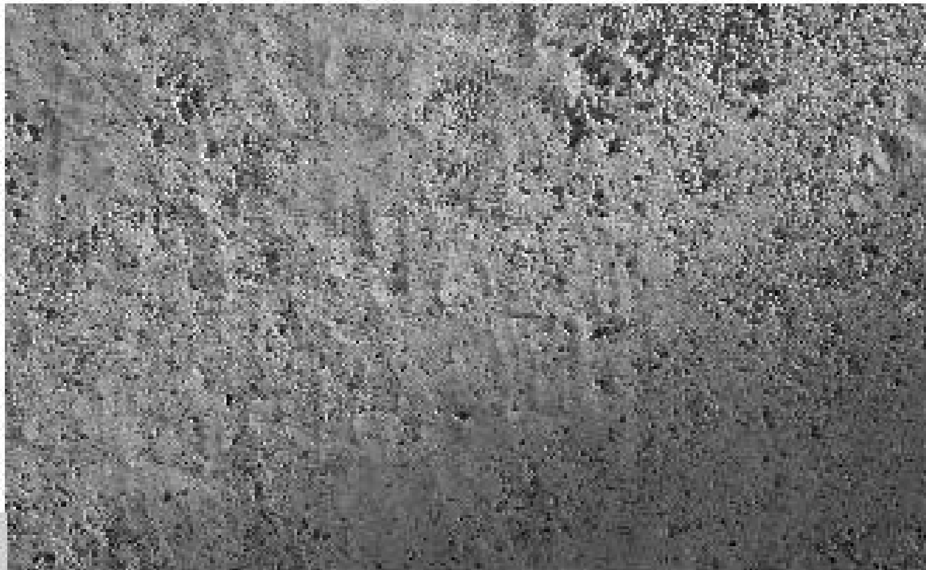
Figura 4 • Presa analoga a quella della fig. 2, ma su una superficie intonacata. Le ombre create dalla luce radente (solare) evidenziano le leggere ondulazioni della superficie apparentemente liscia. (SAT)
