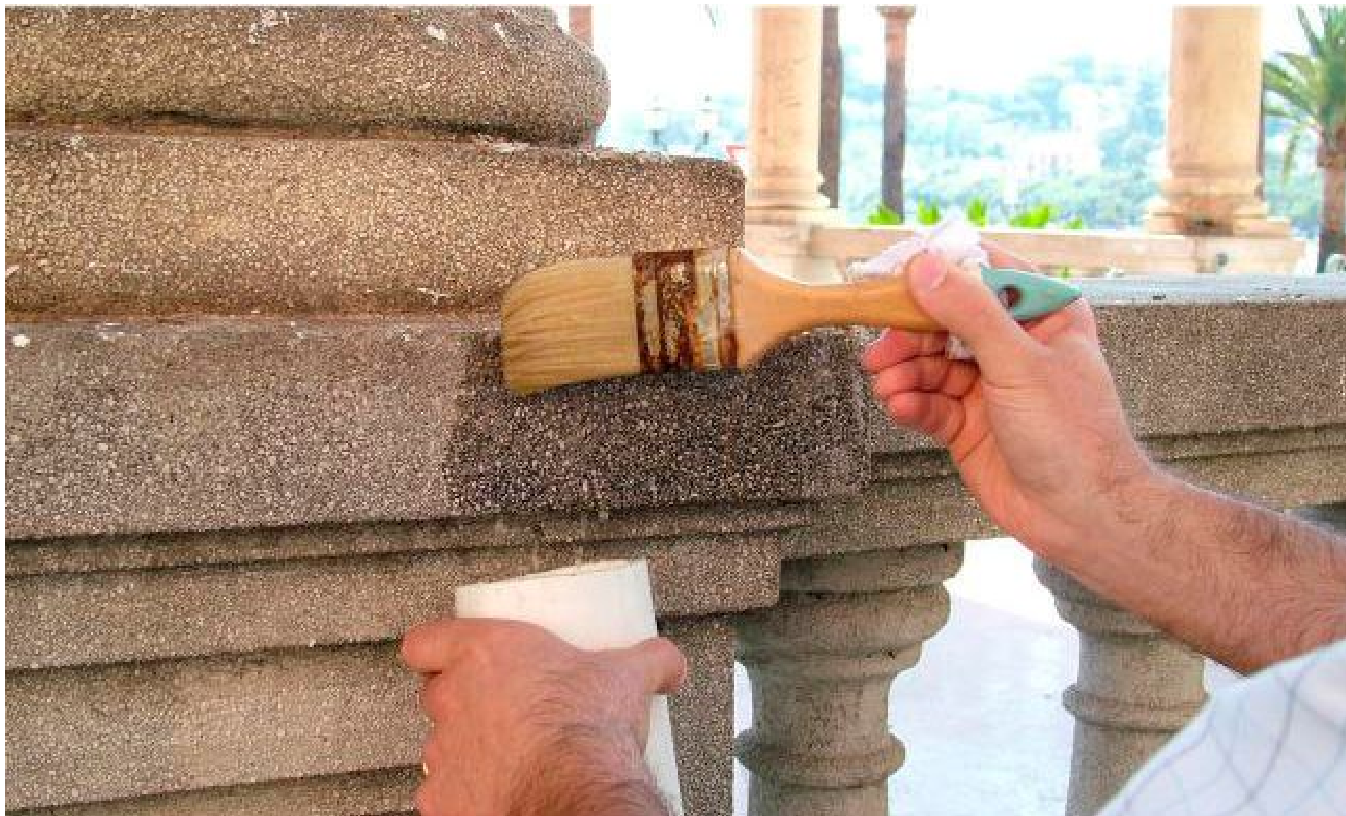
Figura 6 • Fase di esecuzione della pulitura di un basamento in pietra artificiale. (DEP)
