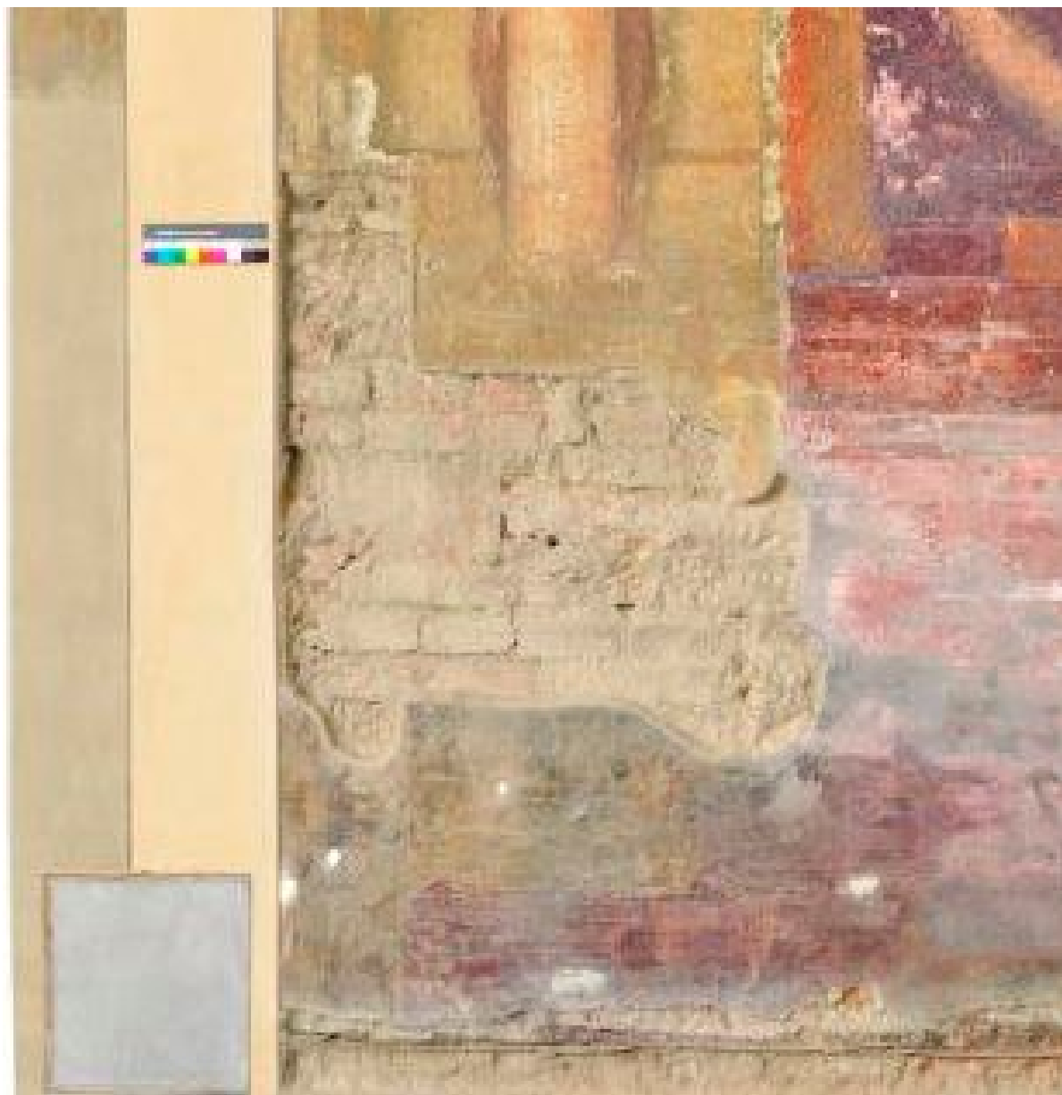
Figura 1a • Lacuna in un dipinto murale. Accanto alla lacuna è visibile il campione di intonaco con il quale si intende elaborare la simulazione. (MOGGIA)
