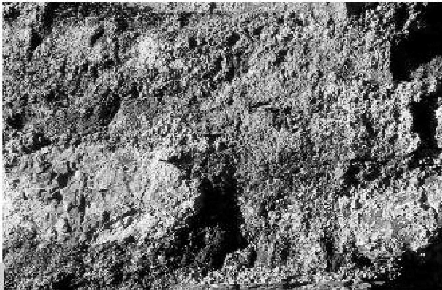
Figura 2 • Presa eseguita in luce radente (solare) del particolare di una muratura. Si osservino gli effetti di esaltazione delle rugosità di superficie e la gamma dei colori. (SAT)
