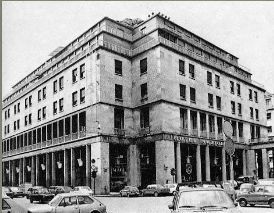
Uno degli edifici di testata di via Roma a Torino secondo le indicazioni di Piacentini, si tratta del palazzo delle Assicurazioni Generali
