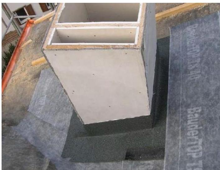
Fig. 4.44 – posa della guaina impermeabile (esempio)
