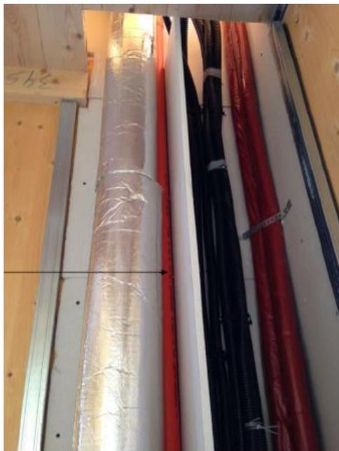
Fig. 4.34 – passaggio tubi (vedi freccia nera) nel passaggio camino; non permesso (fonte: archivio RASOM Wood Technology s.r.l)
