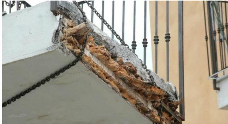
**Fig. 3.13** – New town L'Aquila: collasso della struttura per non corretta impermeabilizzazione del nodo balcone
