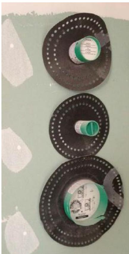
Fig. 4.49 – Impermeabilizzazione miscelatori doccia (fonte: archivio RASOM Wood Technology s.r.l)
