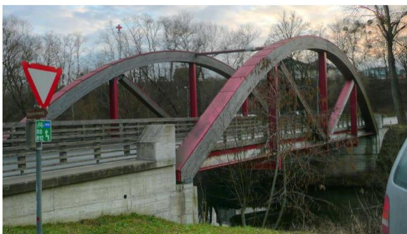
Fig. 3.8 – scossaline metalliche per l'allontanamento dell'acqua piovana in estradosso (fonte: archivio storico Università di Trento)
