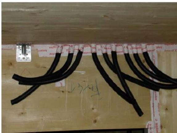
Fig. 4.12 – predisposizione impianto elettrico (fonte: archivio RASOM Wood Technology s.r.l.)
