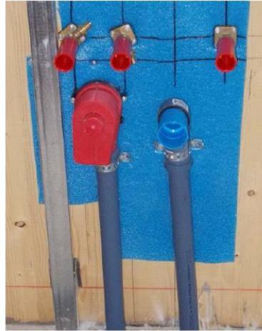
Fig 4.21 –protezione dalle condense tramite interposizione della guaina (fonte: archivio RASOM Wood Technology s.r.l)
