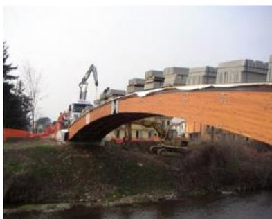
Fig. 6.29– EN 380 – Prova di carico su passerella in legno lamellare
