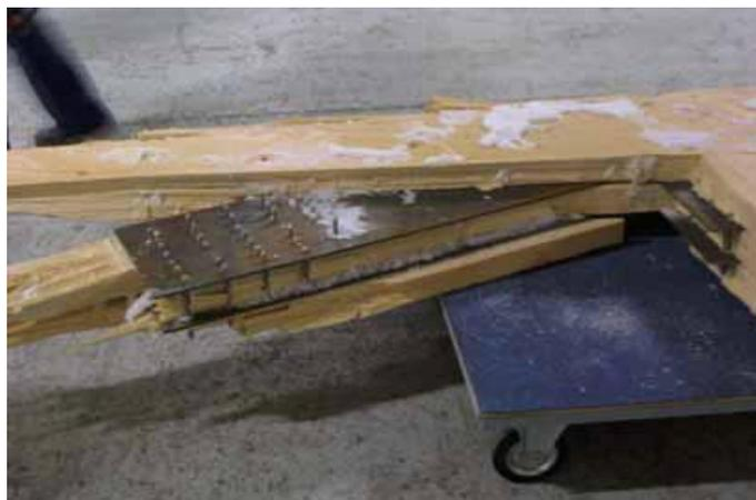
Fig. 5.15 – Nodo della struttura della Sala Espositiva – Pad. Jyväskylä. - Nodi realizzati in difformità al progetto strutturale
