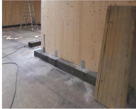
Fig. 4.55 – Attacco a terra eseguito correttamente, la guaina bituminosa protegge il CLT dalla risalita dell'umidità per capillarità.
