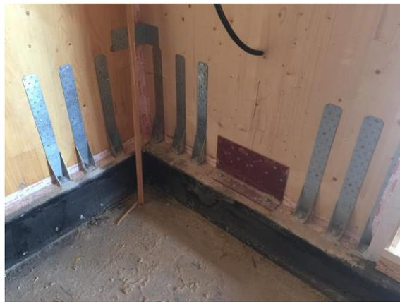
Fig. 4.56 – Esempio di attacco a terra eseguito correttamente, in questo caso tra la platea e la parete in CLT è stato realizzato un cordolo in c.a. di rialzo. (fonte: www.woodlab.info)
