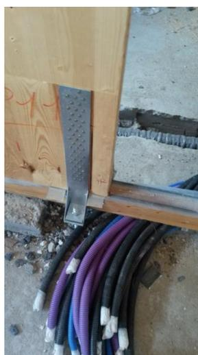
Fig. 4.6 – Comportamento errato e mancato schema impiantistico - Passaggio impianti con scasso del cordolo e assenza di appoggio per hold-down
