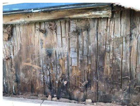
Fig. 5.17 - Parete in CLT in corrispondenza della finestra - (fonte: CNR-IVALSA)
