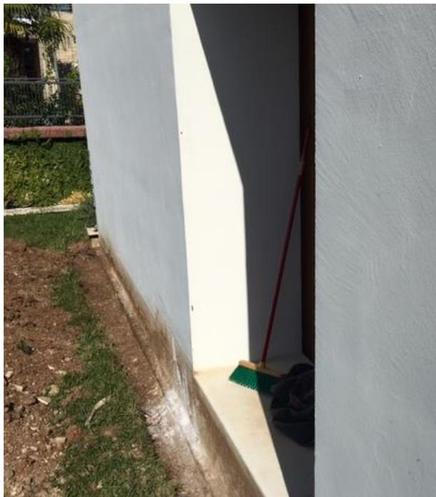
Figura. 3.12 – Nella foto l'attacco a terra è posto al di sotto del piano di calpestio. Guaine impermeabilizzanti poste ad "U" in corrispondenza dell'attacco a terra sulla parete possono portare allo stesso modo a fenomeni di marcescenza.
