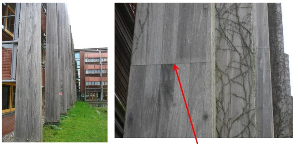
Fig. 3.18 (a÷b) –Lamellare di Iroko (Olanda )con giunti a tutta sezione; Nessuna delaminazione (classe di servizio 3) - Struttura esposta (15 anni)
