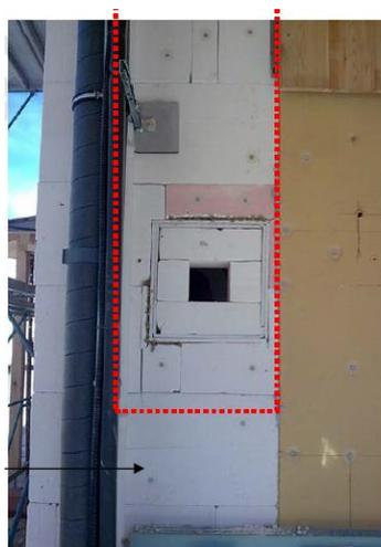
Fig. 4.31 – posa di materiale isolante incombustibile in prossimità del passaggio del camino (vedi freccia nera) in sostituzione alla fibra di legno (fonte: archivio RASOM Wood Technology s.r.l)
