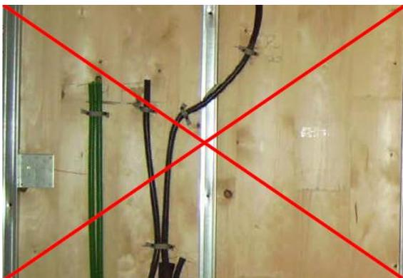
Fig. 4.8 – passaggio non corretto (fonte: archivio RASOM Wood Technology s.r.l.)
