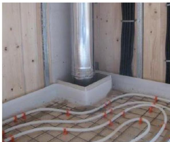
Fig. 4.30 – passaggio camino in struttura a pannelli portanti (fonte: archivio RASOM Wood Technology s.r.l)
