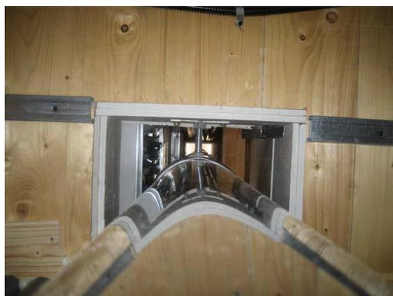
Fig. 4.29 – Passaggio camino in struttura a pannelli portanti (fonte: archivio RASOM Wood Technology s.r.l)
