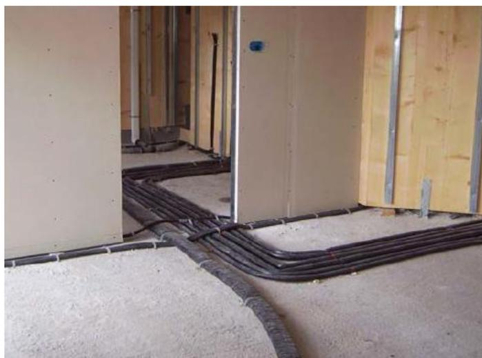
Fig. 4.5 – Passaggio sotto porta impianti (fonte: archivio RASOM Wood Technology s.r.l.)
