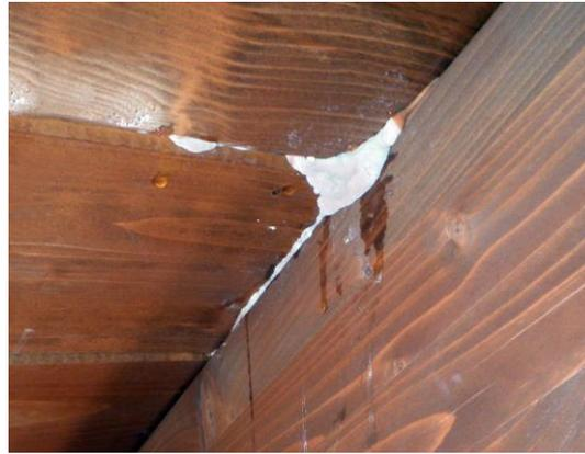
Fig. 4.73 - Crescita di funghi all'interno dell'ambiente dell'edificio dovuta a condensa interstiziale
