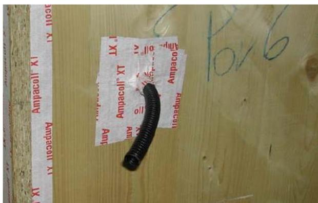
Fig. 4.14 – Corretta nastratura dei corrugati (fonte: archivio RASOM Wood Technology s.r.l.)
