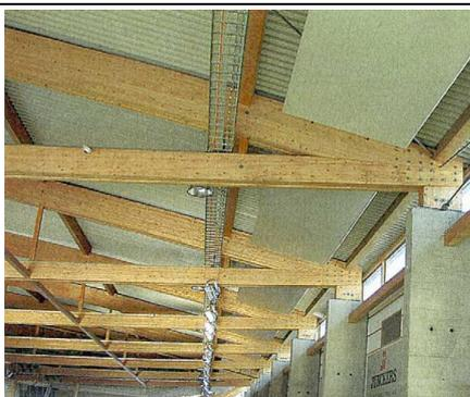
Fig. 5.9 – Tralicci (particolare – appoggio su colonne in cemento armato) - Siemens Super Arena
