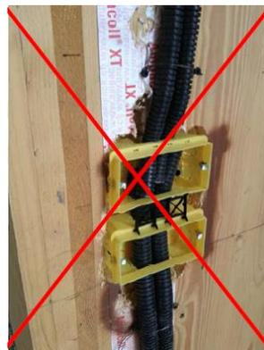
Fig. 4.17 – scatole per strutture in muratura (fonte: archivio RASOM Wood Technology)
