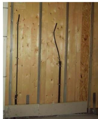
Fig. 4.9 – passaggio corretto (fonte: archivio RASOM Wood Technology s.r.l.)
