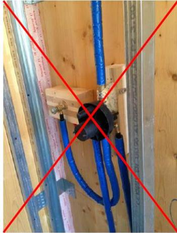
Fig 4.20 – assenza di protezione per la struttura in legno
