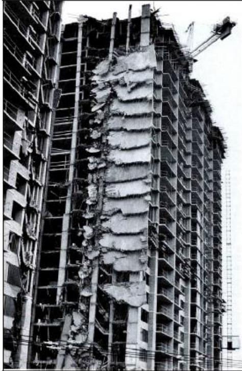
Fig. 5.1 – Collasso progressivo di un edificio multipiano in calcestruzzo armato dovuto alla rimozione prematura degli elementi di puntellamento – Virginia, 1973
