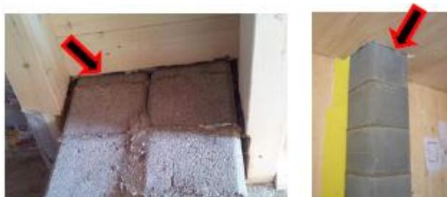
Fig. 4.24 - Esempi di camini previsti per combustibili solidi non eseguiti correttamente: ignorata completamente la distanza di sicurezza dai materiali combustibili
