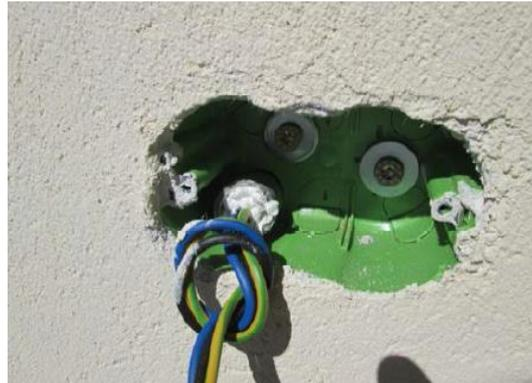
Fig. 4.15 – Cavo elettrico esterno e sigillatura (fonte: archivio RASOM Wood Technology s.r.l)
