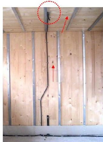
Fig. 4.11 – Passaggio corretto punto luce (fonte: archivio RASOM Wood Technology s.r.l.)
