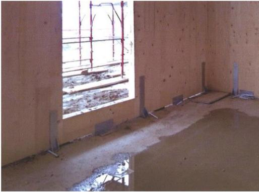
Fig. 4.54 – Attacco a terra non corretto; la parete in CLT è stata posata direttamente sulla platea senza una guaina di separazione.
