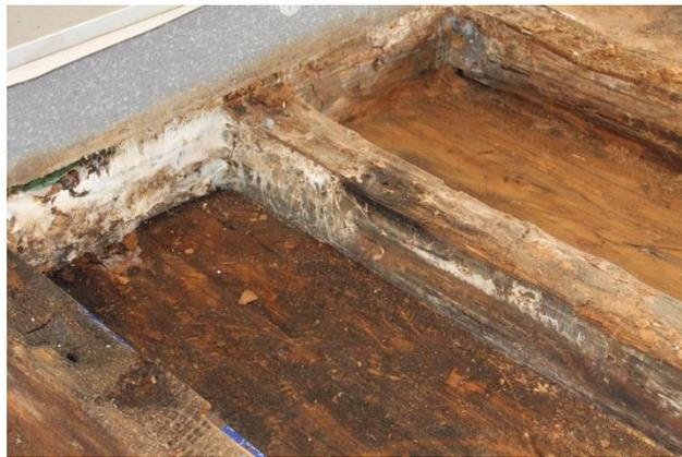
Figura. 3.17 – pacchetto telaio e materiali non traspiranti: degrado da parte di funghi.
