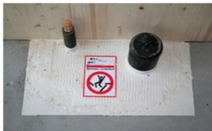
Fig. 4.2 - I concetti di resistenza, isolamento e tenuta (REI) sono vani, qualora non vengano applicate regole di dettaglio per la progettazione dei passaggi impiantistici
