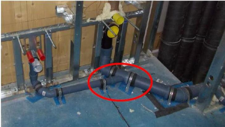
Fig 4.22 –corretto fissaggio della tubazione al solaio (fonte: archivio RASOM Wood Technology)
