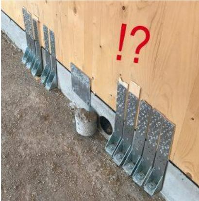
Fig. 4.58 – Esempio di fissaggio con hold-down posti ad un interasse non corretto.
