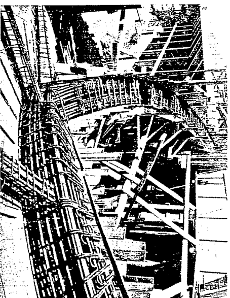
Fig. 121 - Stadio G. Berta di Firenze (P.L. Nervi, 1930-1932): una delle scale elicoidali in costruzione e relativa armatura
