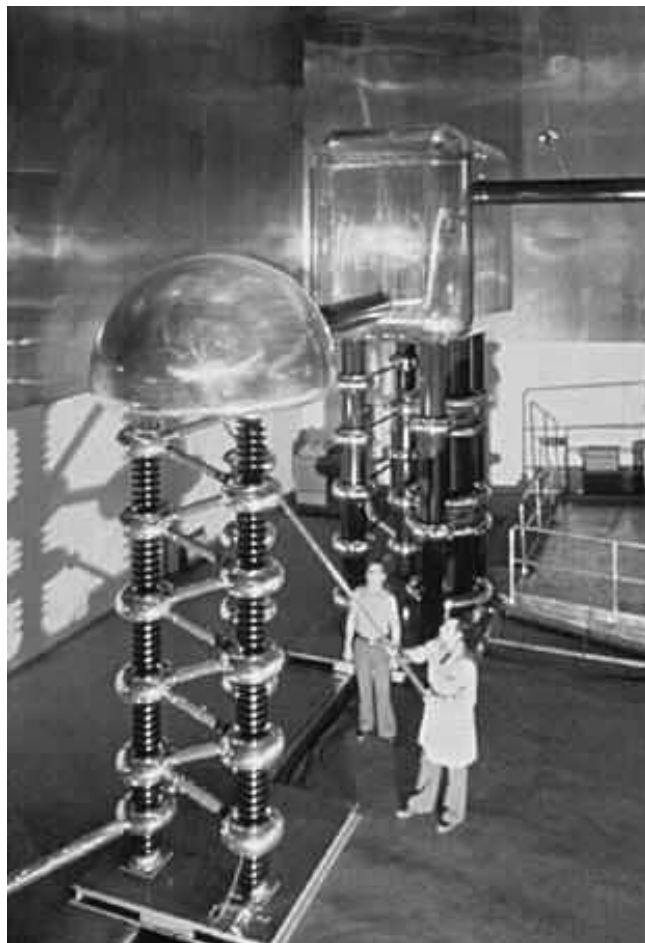
Figura I.5: L'acceleratore Cockcroft-Walton che ha funzionato al CERN portando i protoni fino all'energia di 800 keV prima di iniettarli in un successivo acceleratore LINAC.
