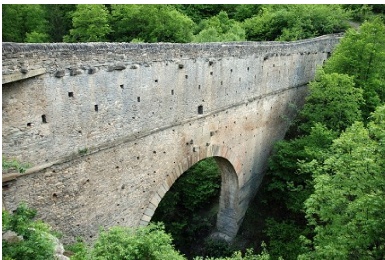
Fig. 4. Il ponte-acquedotto del Pondel, nei pressi di Aymaville (AO)
