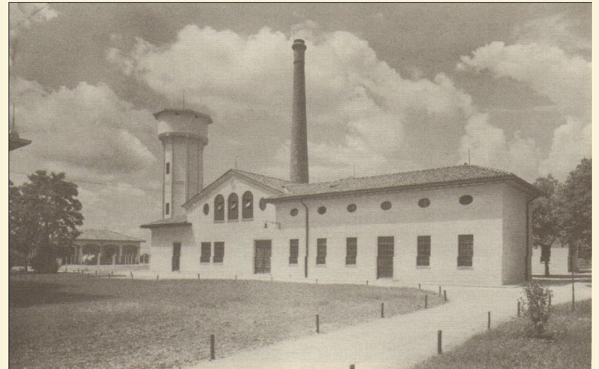
La centrale termo-elettrica e lavanderia.
