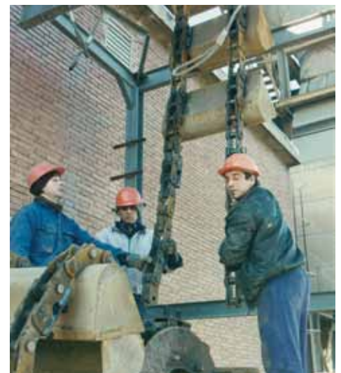
Montaggio catena per elevatore Assembly of an elevator chain Montage einer Becherwerk-kette
