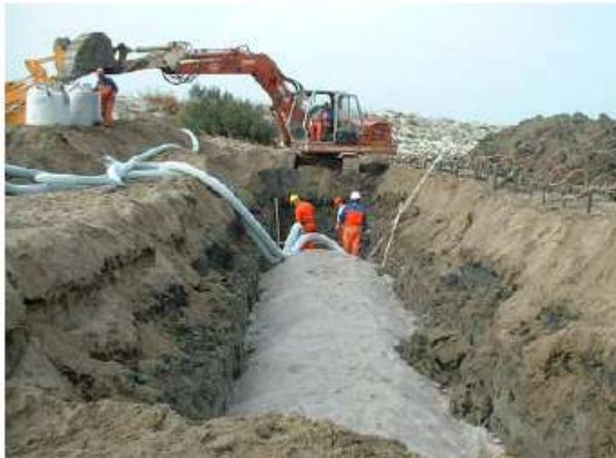
**Funziona sul principio della stabilizzazione della spiaggia mediante drenaggio forzato dell'acqua nello strato saturo dell'area intertidale. Aumenta in questo modo lo spessore dello strato asciutto che favorisce l'infiltrazione dello swash, innescando un processo di trasporto onshore (vd. spiagge controllate dalla marea)**
