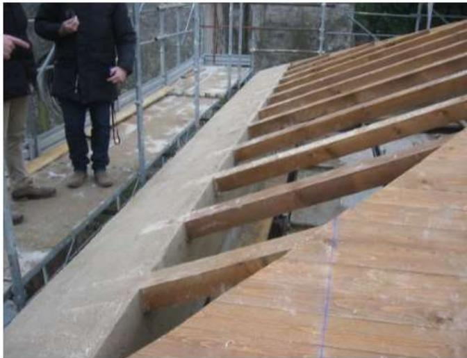
**Al posto del cordolo in c.a., esecuzione di muratura armata con rete in composito e chiusura con intonaco armato.**
