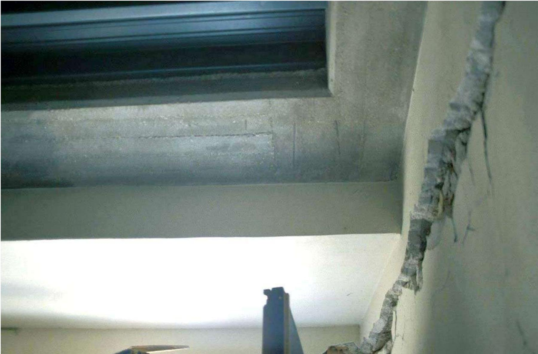
**Umbria 1997: rottura orizzontale muratura dovuta al nuovo solaio in calcestruzzo**
