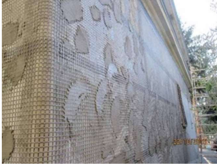
Rinforzo muratura con rete in basalto
