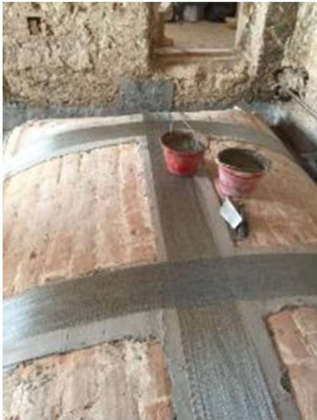
Rinforzo muratura con rete in basalto
