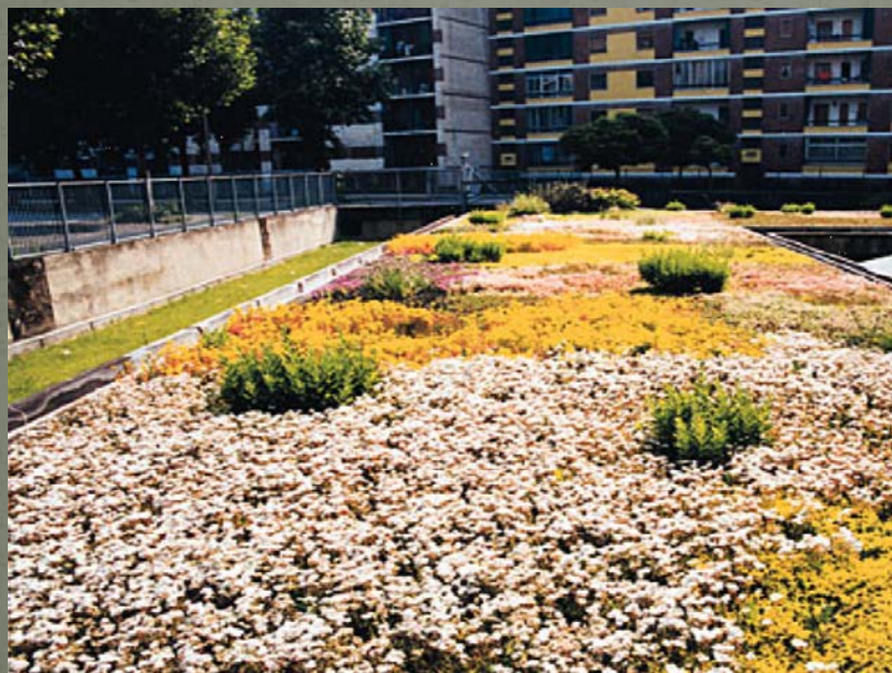
Copertura garage seminterrato
