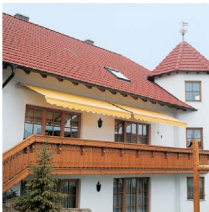
Figura 9.1: "Tenda da sole fissata in sicurezza"
