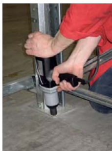
Fig. 6.25: Montaggio di un'ancorante a vite con un'avvitatore ad impulsi [51]
