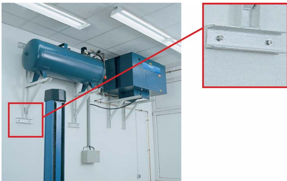
Fig. 2.11: fissaggio di mensole per apparecchiature con tassello Würth W-FAZ/S, M12
