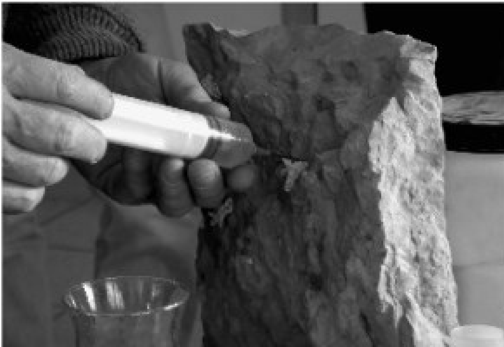
Figura 6 • L'incollaggio in profondità è eseguito utilizzando siringhe, assicurandosi che il distacco sia riempito il più possibile e procedendo a una immediata pulitura in caso di fuoriuscita del prodotto.
