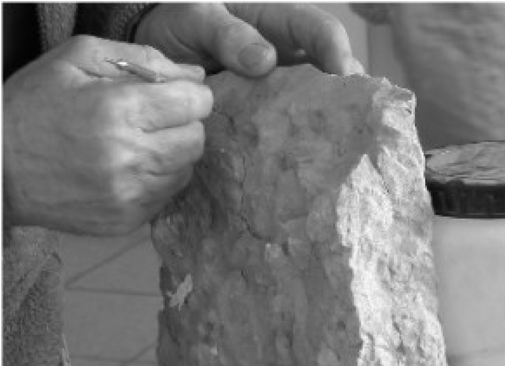
Figura 2 • Pulitura dei bordi delle scaglie per consentire la successiva stuccatura.
