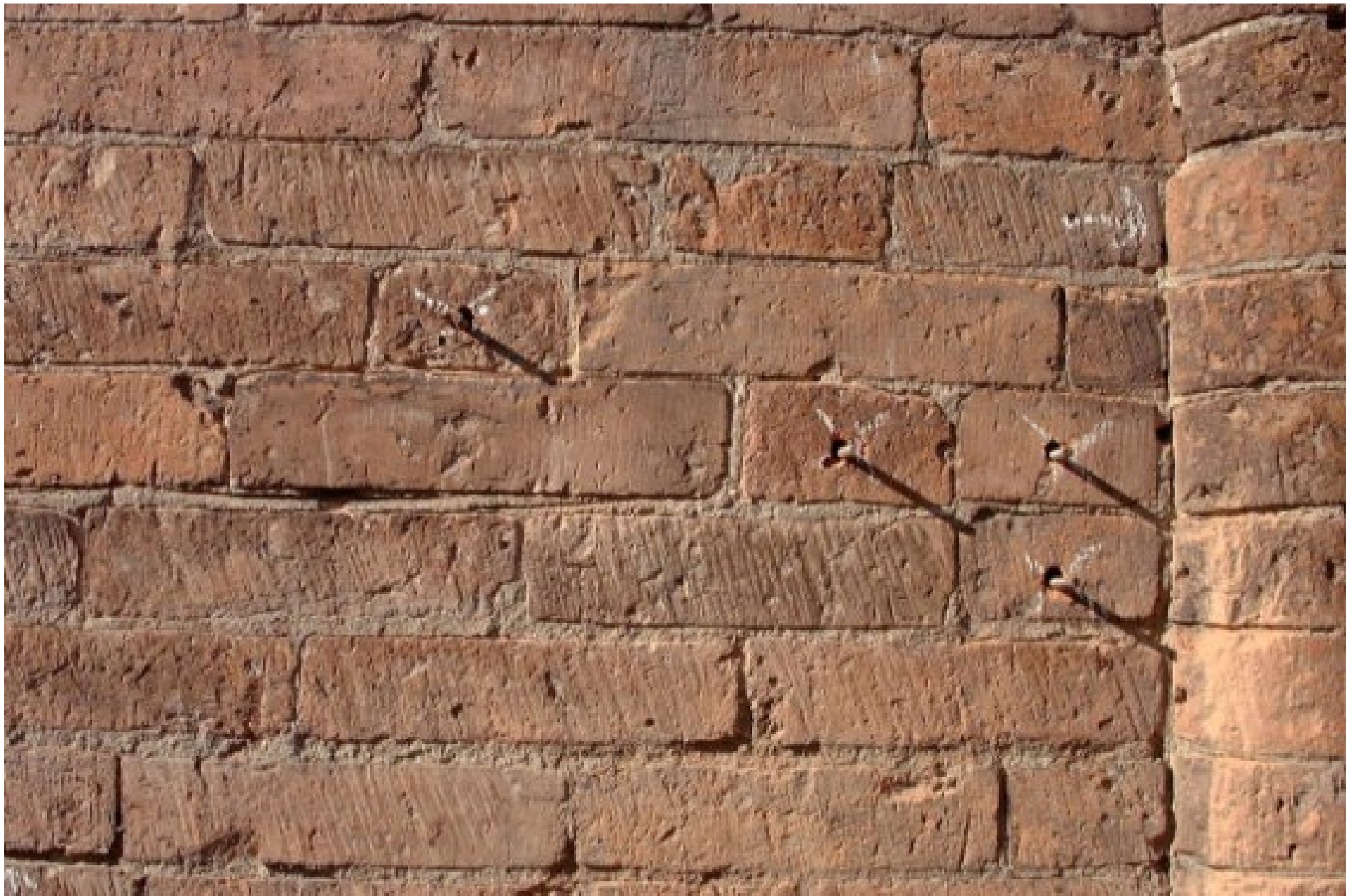
Fig. 7 • Cortina in mattoni con i perni inseriti nei fori prima dell'iniezione del formulato adesivo.
