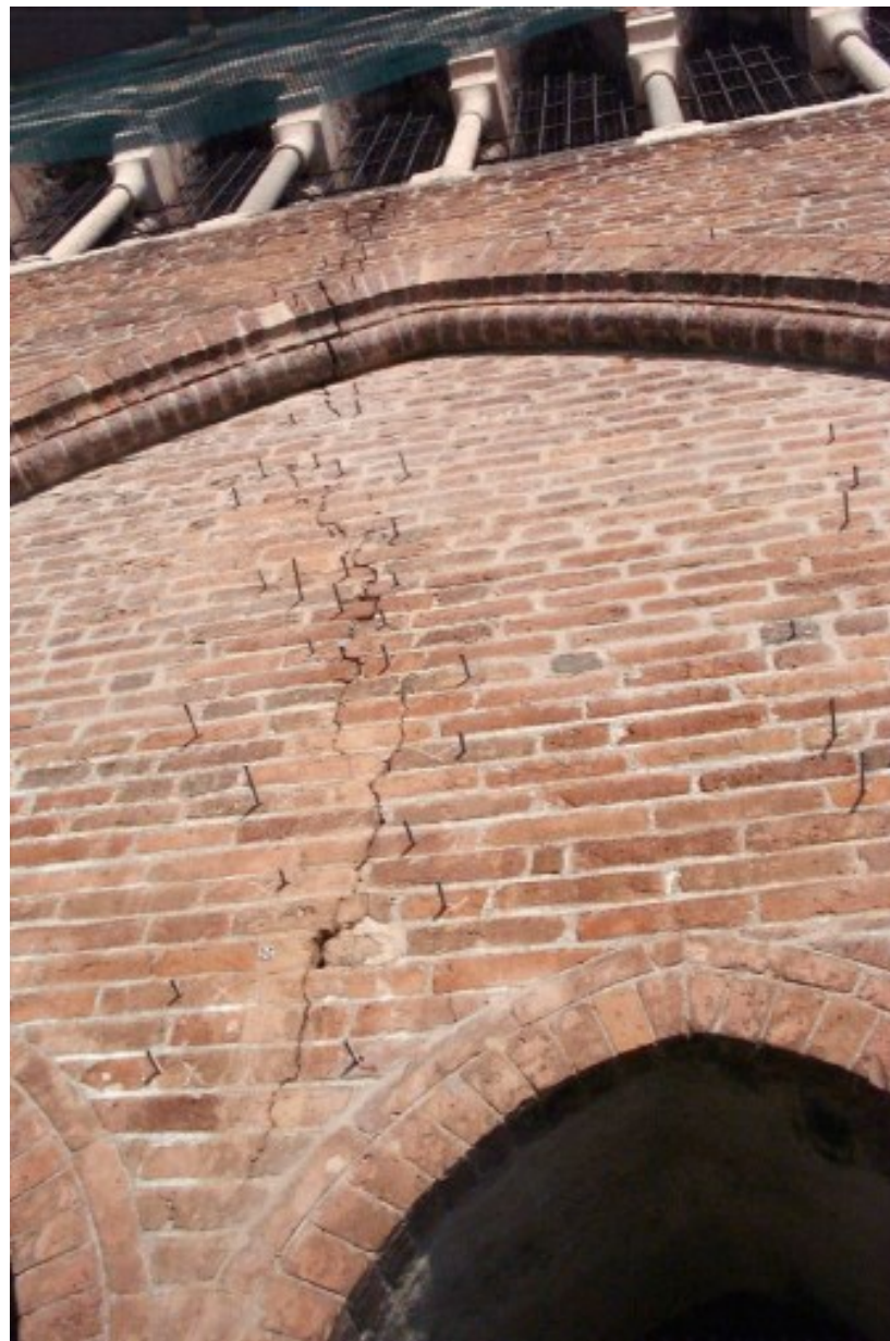
Fig. 6 • Torrazzo di Cremona. Ancoraggio dei laterizi distaccati della cortina esterna con perni in acciaio inox di piccolo diametro.
