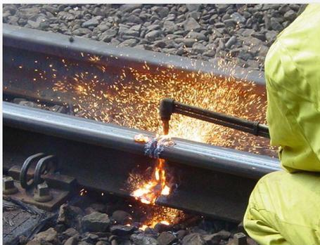
L'ossitaglio è un procedimento per il taglio delle lamiere o dei profilati metallici che utilizza la fiamma ossiacetilenica ed un getto di ossigeno puro. Si basa sul principio che i materiali ferrosi portati ad incandescenza bruciano se si trovano in un'atmosfera di ossigeno. Si effettua attraverso l'uso di uno speciale cannello dal quale escono due flussi di gas concentrici:
