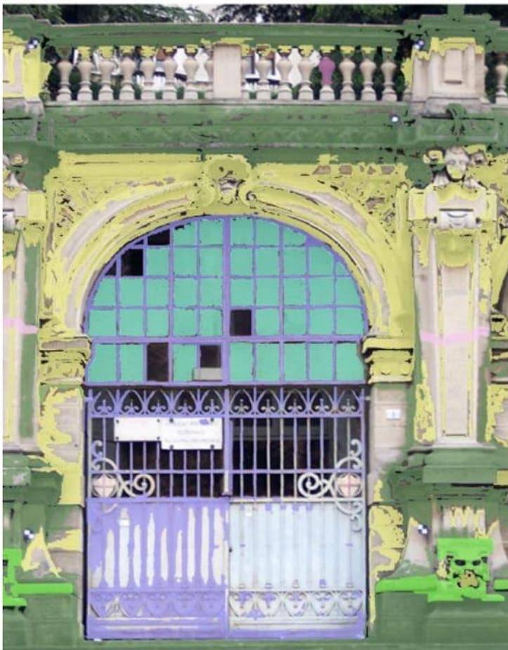
Per una più approfondita analisi e comprensione delle forme di degrado presenti sul manufatto, si è deciso di mappare in modo più preciso una sola arcata, in particolare quella centrale.
