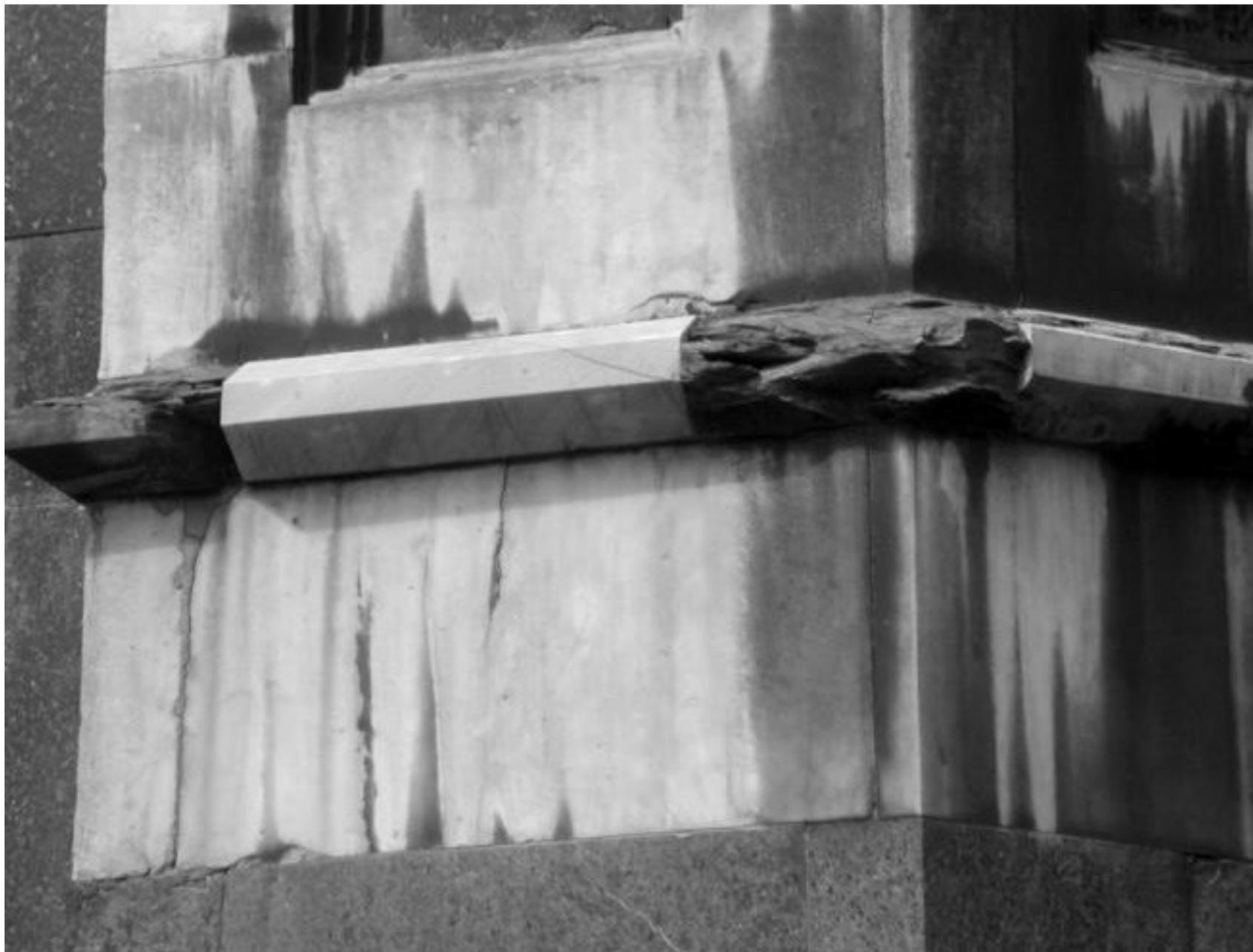
Figura 6 • Tassello dalla forma analoga alla cornice da sostituire, ma di materiale diverso.
