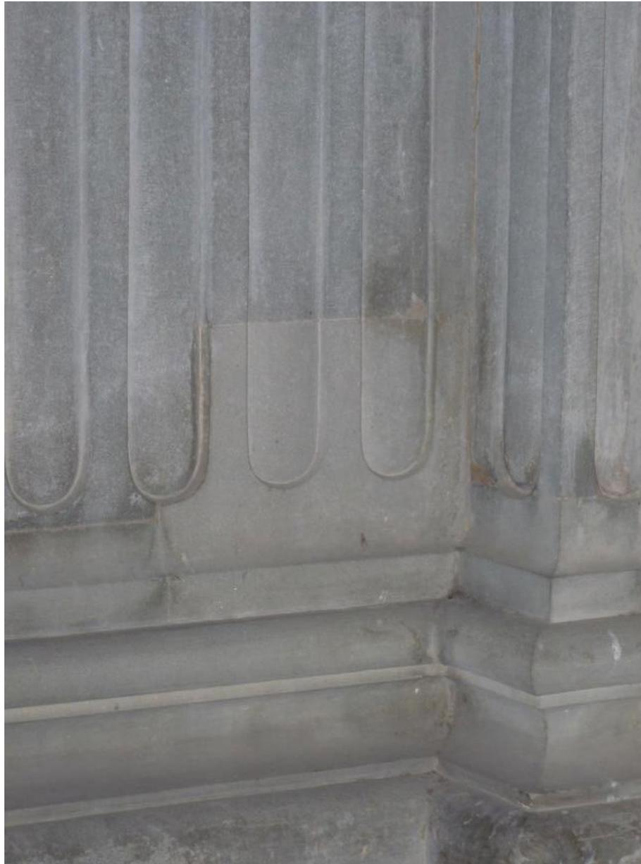
Figura 8 • Tasselli realizzati con stesse forme e materiale delle parti da sostituire.
