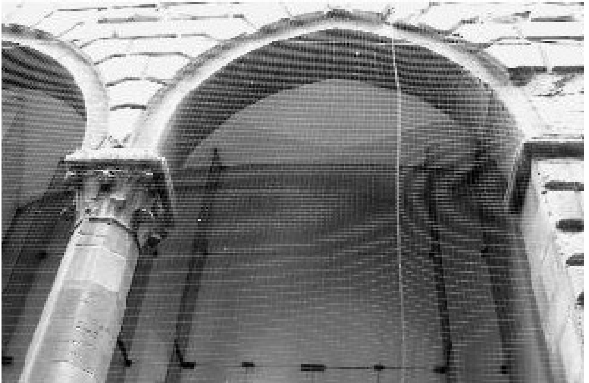
Figura 9 • Reti antivolatili alla loggia degli Abati di palazzo Ducale a Genova.
