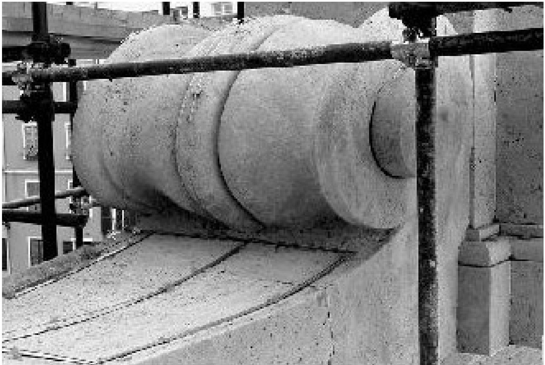
Figura 3 • Protezione, con sistema elettrostatico, dell'estradosso di una voluta.
