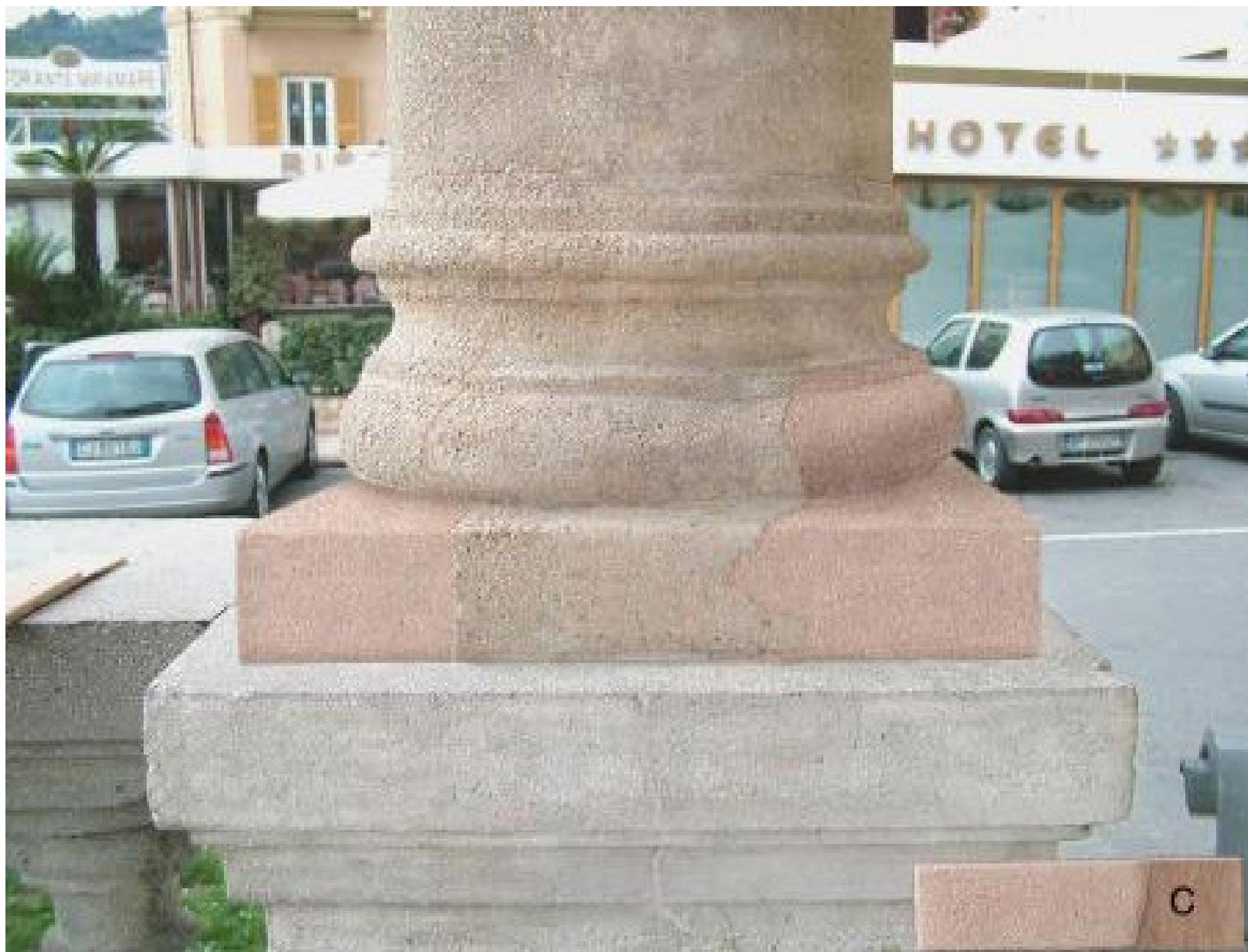
Figura 17 • Simulazione della integrazione delle mancanze elaborata con un impasto simile all'originale, ma applicata con un leggerissimo sottolivello.
