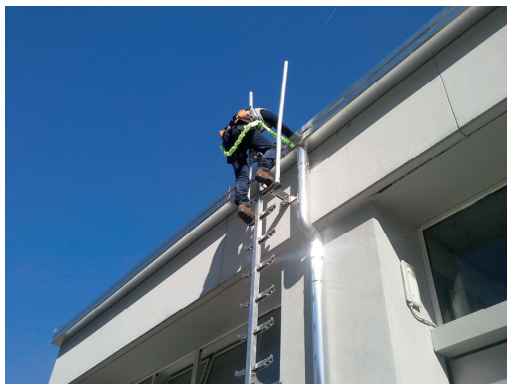
Figura 4.3-1 Esempio di scala a pioli anticaduta
