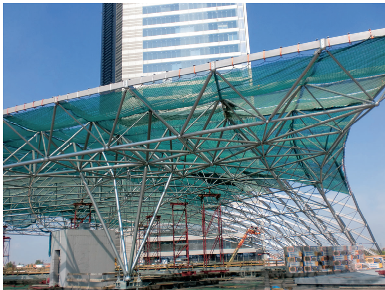
Figura 5.3.2-2 - Esempio di sistema S: copertura in acciaio
