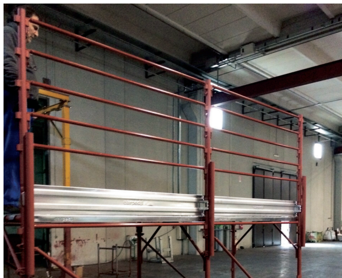
Figura 5.1.1-3 - Esempio di prototipo di parapetto di sommità a boccole
