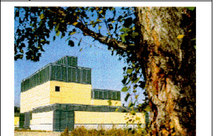
Figura 6. Impianto a celle a combustibile della AEM (Milano).
