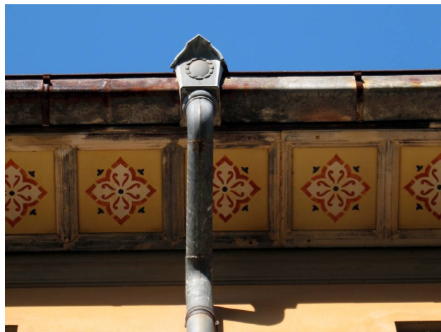
Elemento di raccordo tra canale di gronda e pluviale
