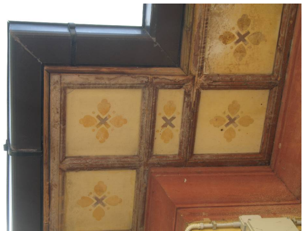
Cornicione sottolinda a cassettoni
