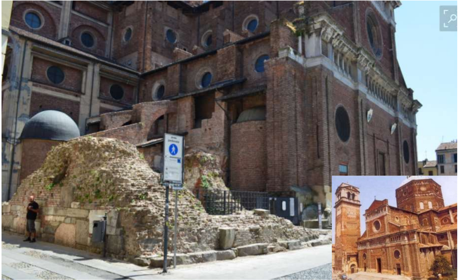
Crollo Torre Civica (marzo 1989)
