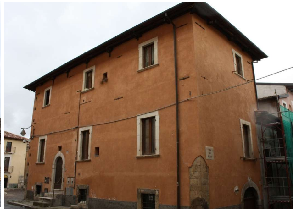
L'Aquila 2009 Edificio ben legato
