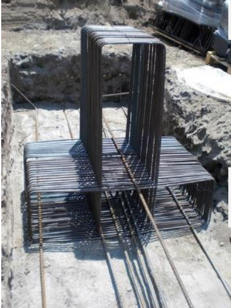
Travi rovesce monodirezionali
