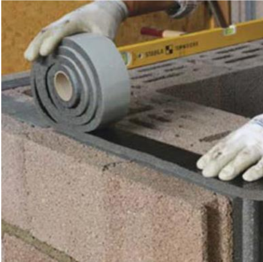
Posa in opera della striscia adesiva
