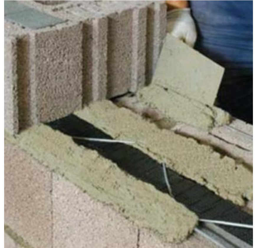
Posa in opera della malta lungo tre corsi
