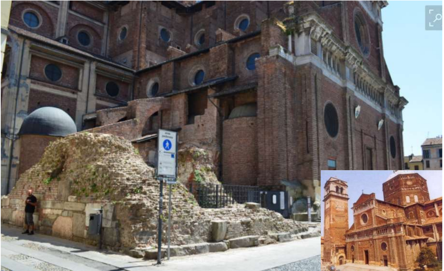
Crollo Torre Civica (marzo 1989)
