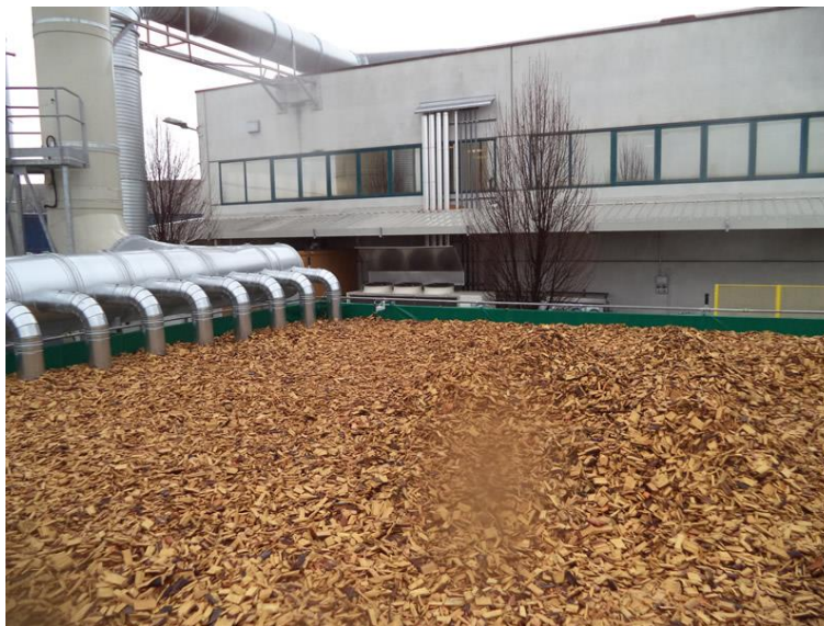
Figura 112 Biofiltro per trattamento COV da verniciatura
