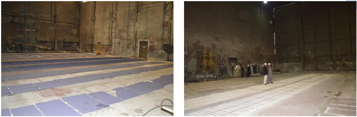
Figura 153 Pitturazione di elementi di paiolato. Manufatti predisposti per la pitturazione (sinistra) e relativi depositi di vernice (destra)
