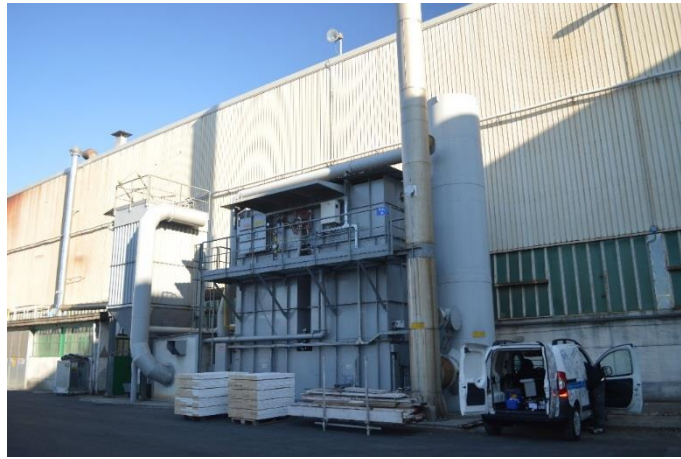
Figura 99 Combustore termocatalitico
