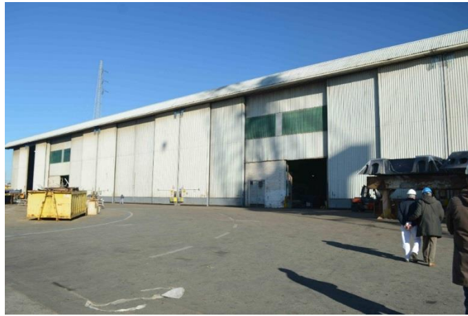
Figura 147. Capannette di Pitturazione – Fabbricato
