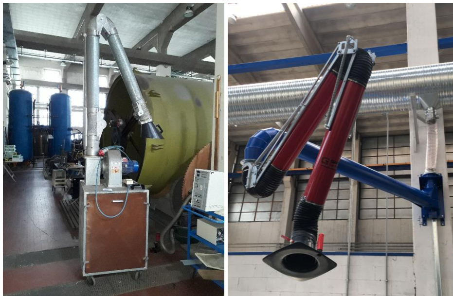
Figura 117 Cappa mobile: soluzione portatile e collegamento ad impianto centralizzato
