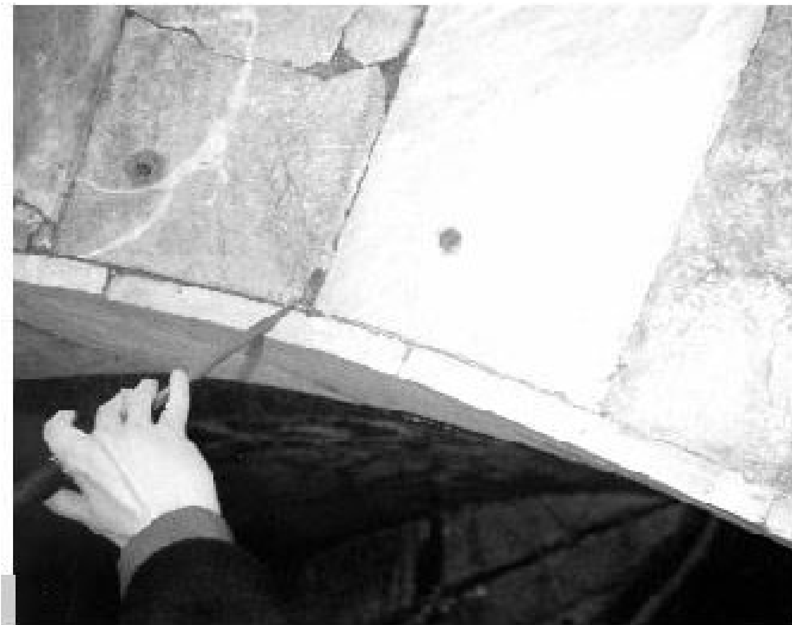
Figura 4 • Eliminazione in opera di vecchio stucco.
