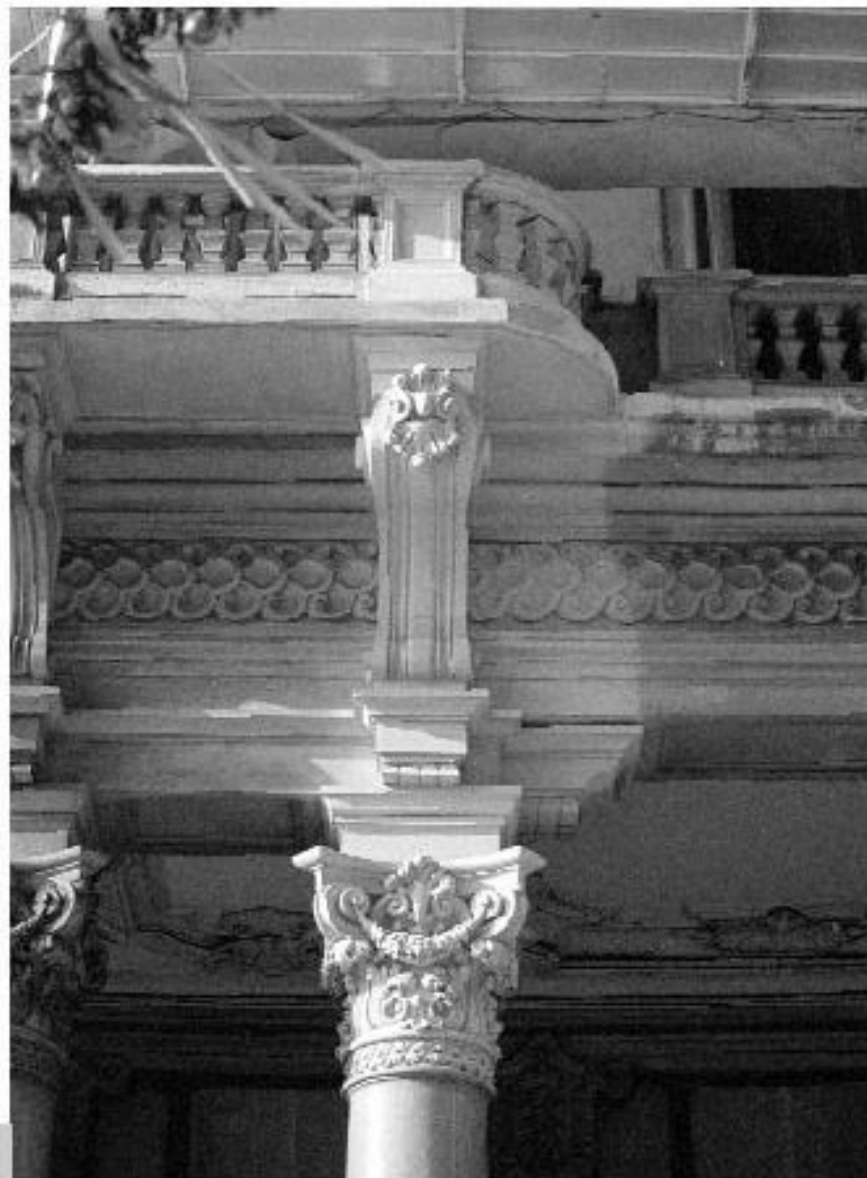
Figura 3 • Effetto pulente su un insieme di modanature con forti variazioni altimetriche e presenza di sottosquadri.
