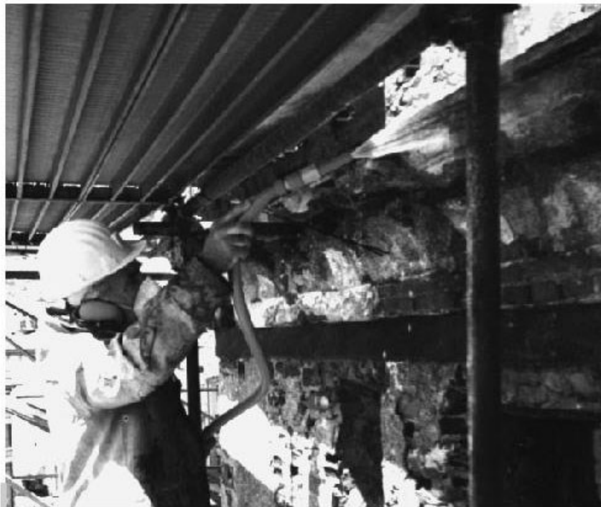
Figura 3 • L'intervento di idrosabbatura deve sempre concludersi con un lavaggio finale, mirato ad agevolare la solubilizzazione dei residui di sporco ormai ammorbiditi ma ancora presenti, nonché a favorire l'allontanamento dell'abrasivo depositato in superficie o penetrato negli interstizi e nei macro-pori del materiale. Eventuali trattamenti protettivi devono essere eseguiti al termine del processo d'evaporazione dell'acqua in esubero.
