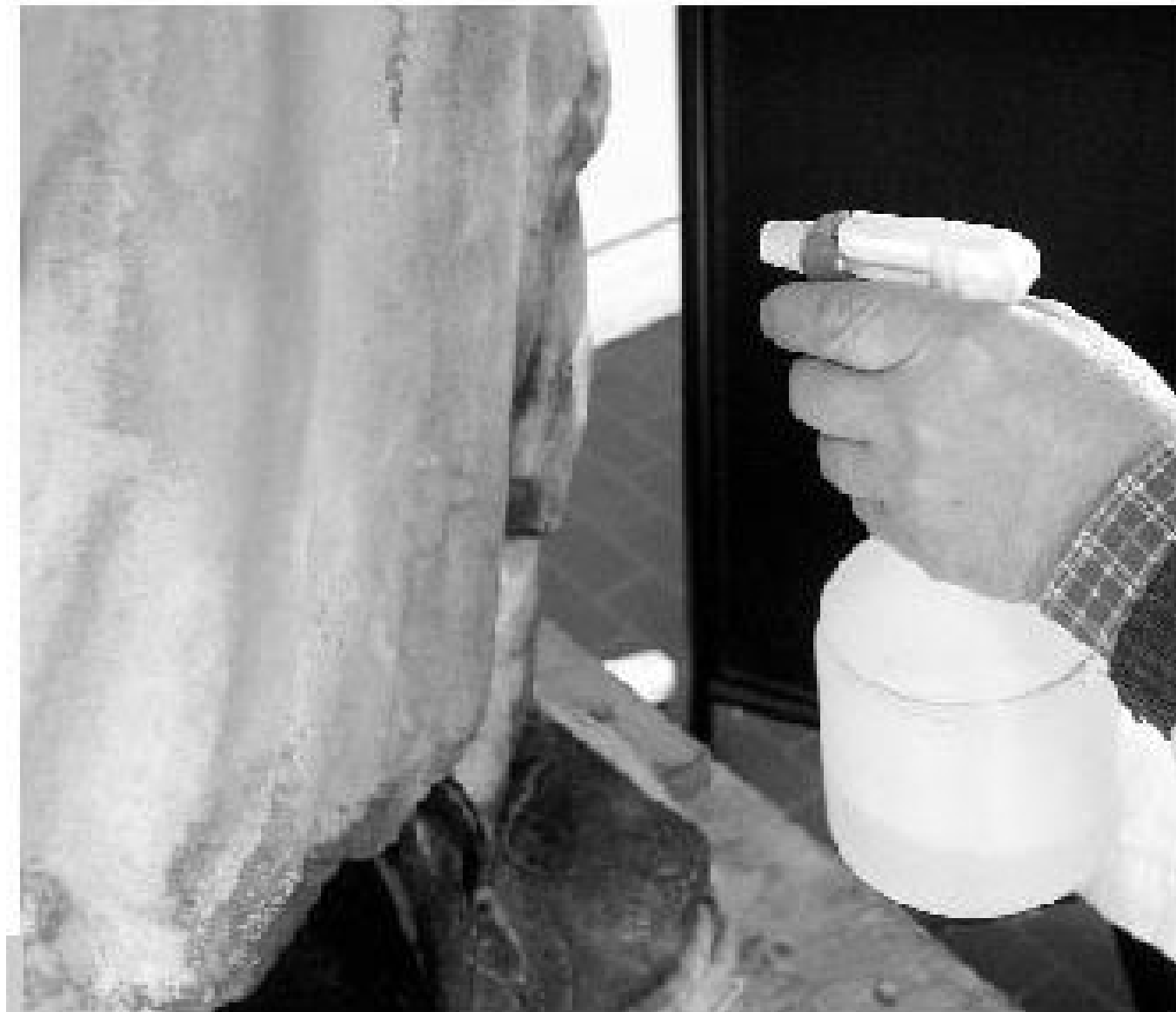
Figura 5 • La bagnatura della superficie si esegue di solito con nebulizzatori di diversa capacità a seconda della superficie trattata e della velocità del trattamento.
