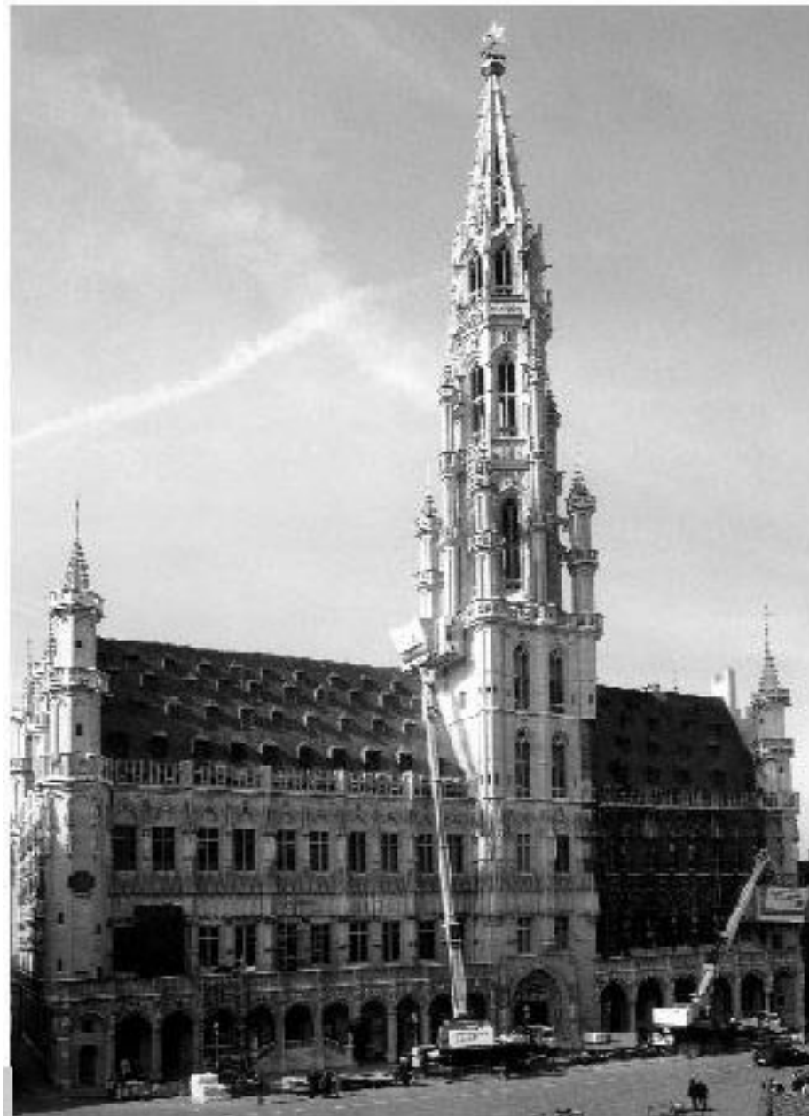
Figura 5 • La tecnica del gommage applicata alla pulitura di un edificio alto e con accentuati rilievi e aggetti.
