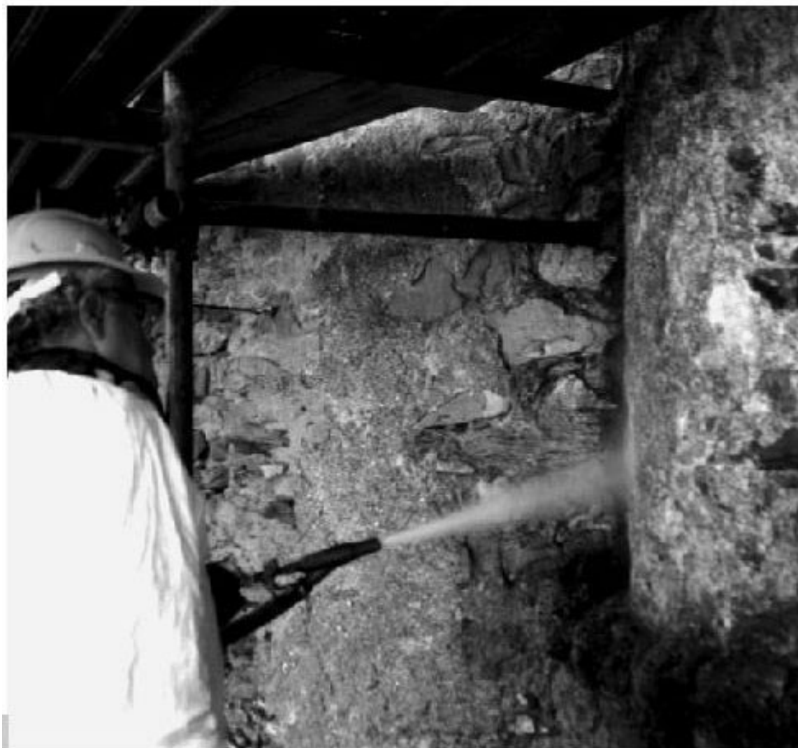
Figura 2 • Addetto alle operazioni di idropulitura. Prima di dare avvio all'intervento si deve provvedere alla stuccatura di tutte le connessure e le fessure presenti in superficie, onde impedire la penetrazione dell'acqua in profondità ed un dannoso aumento dell'umidità della struttura muraria.
