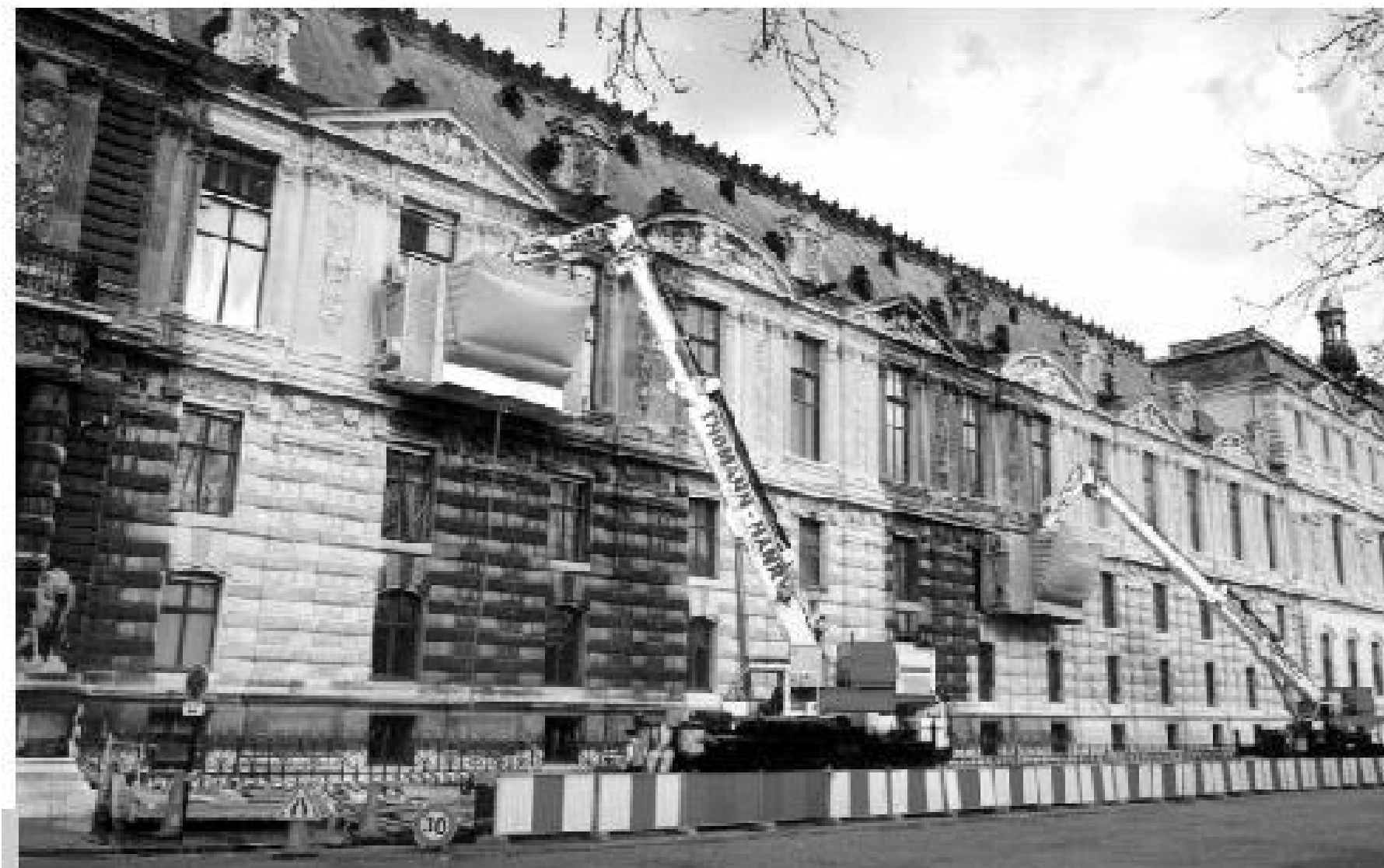
Figura 4 • Due cabine di pulitura lavorano contemporaneamente alla pulitura di una cortina edilizia. Si notano le barriere protettive dell'area di manovra degli automezzi e sono visibili le aree ancora da pulire e quelle già trattate.
