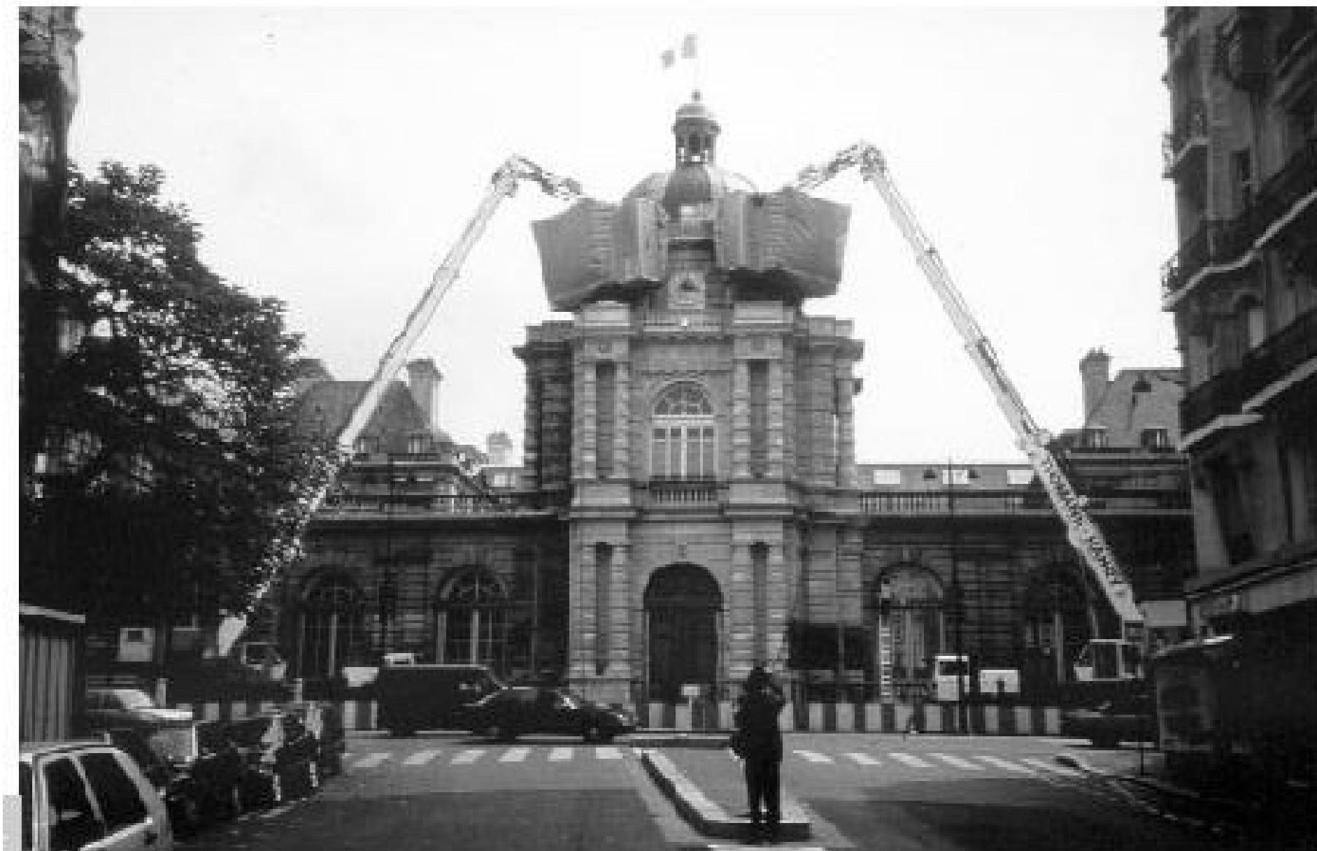
Figura 6 • Azione congiunta di due impianti durante la pulitura di una cupola.
