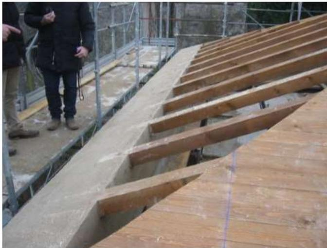
**Al posto del cordolo in c.a., esecuzione di muratura armata con rete in composito e chiusura con intonaco armato.**
