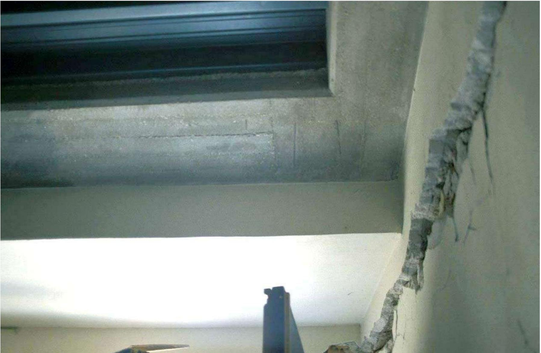
**Umbria 1997: rottura orizzontale muratura dovuta al nuovo solaio in calcestruzzo**
