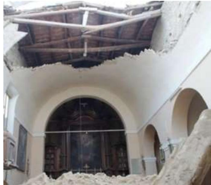
**Elementi strutturali caratterizzati da elevata vulnerabilità statica, soprattutto in caso di eccitazione sismica.**
