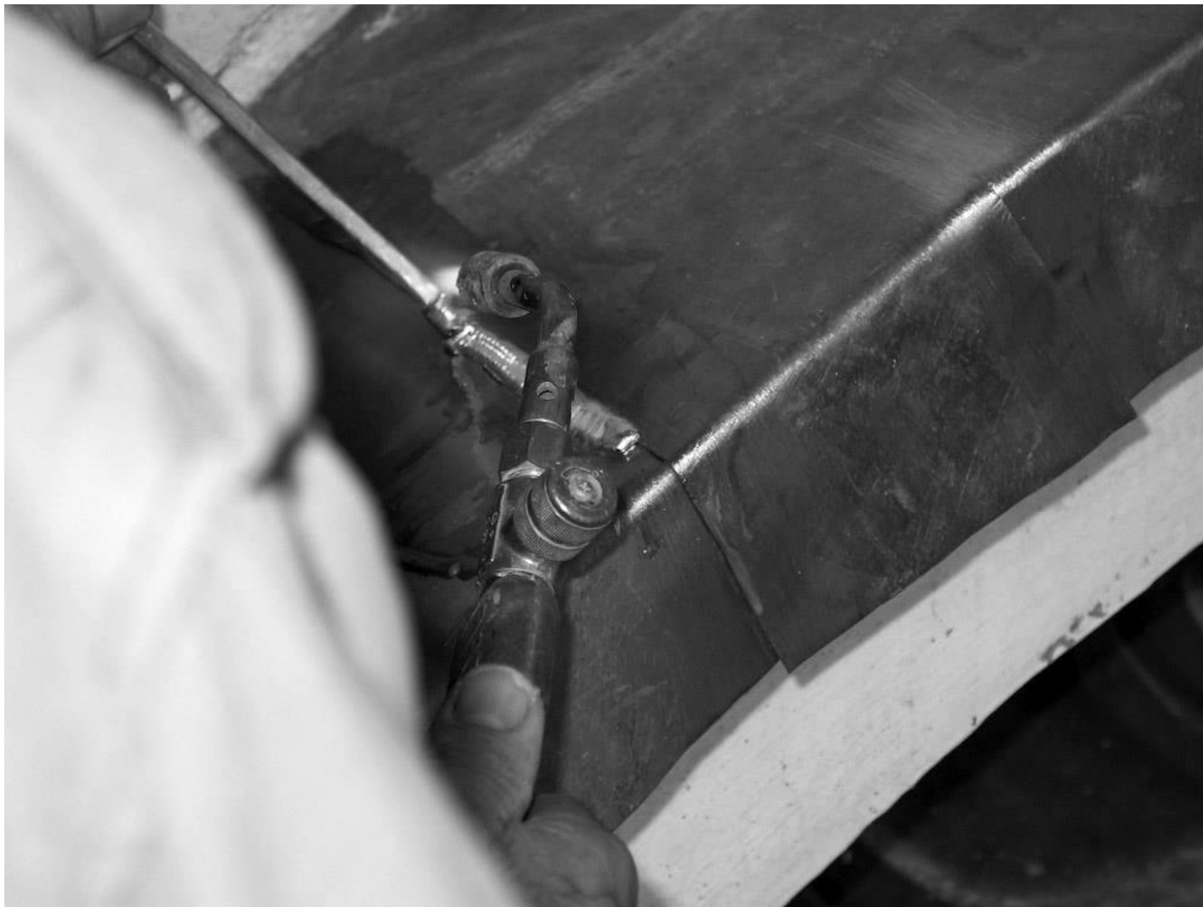
Figura 16 • Saldatura con cannello di stagno.
