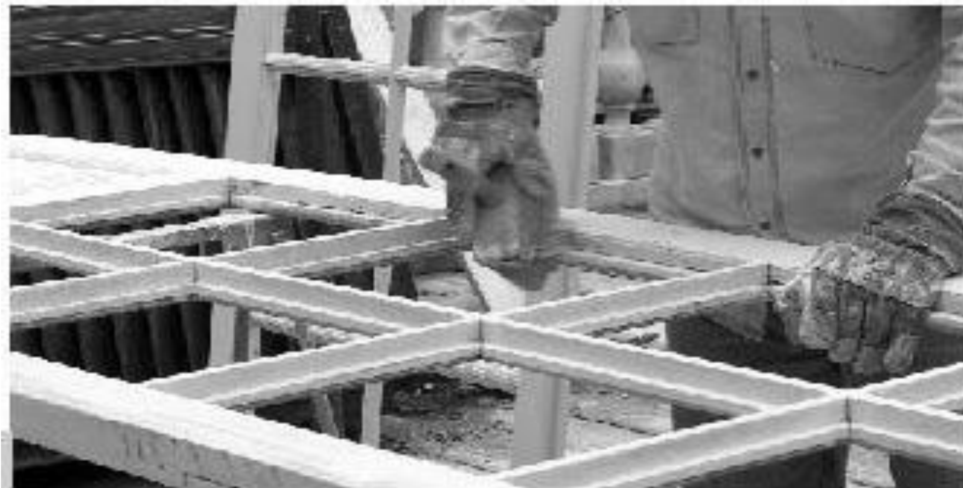
Figura 5 • Spolveratura con pennellessa dopo la seconda carteggiatura.
