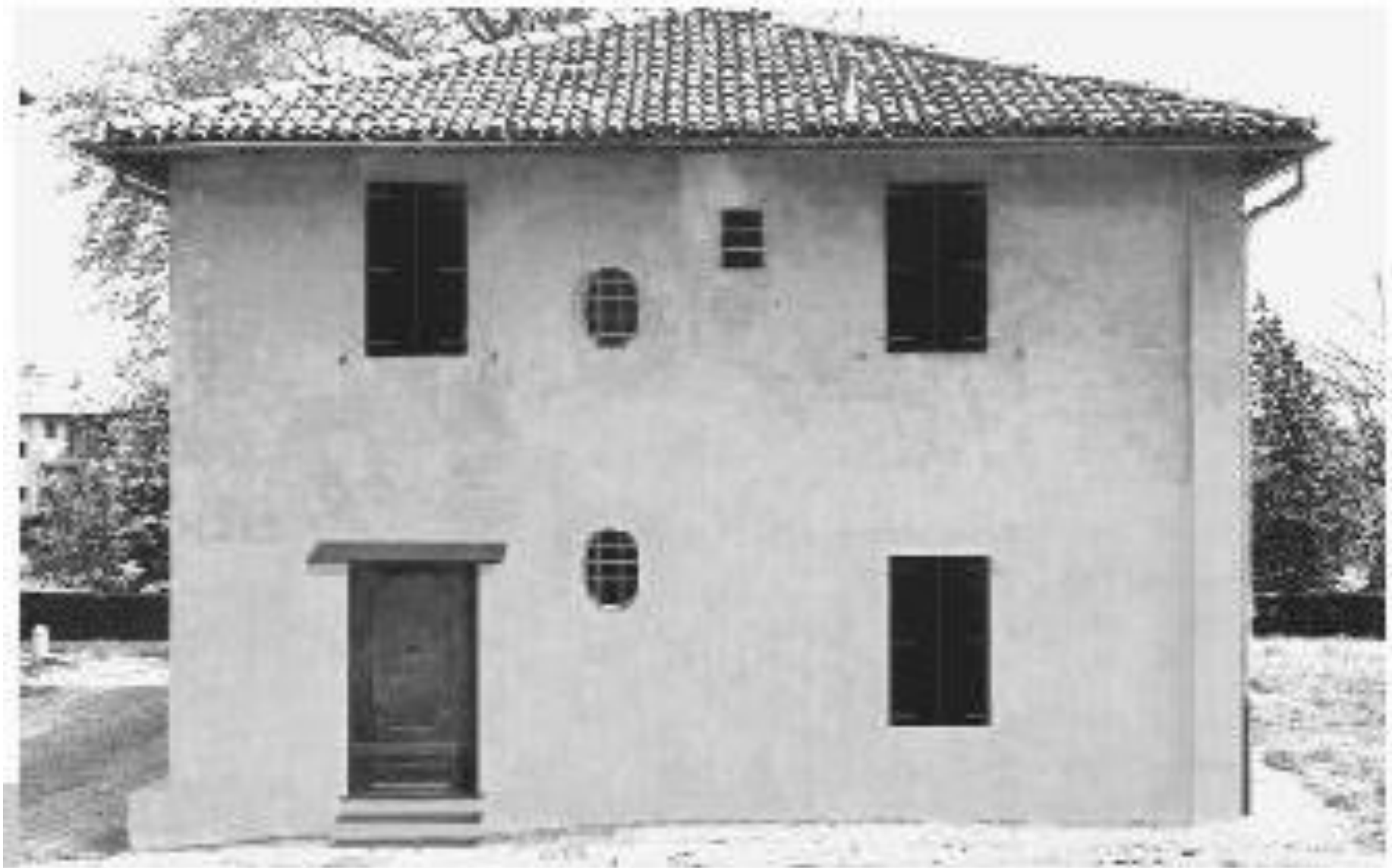
Figura 3 • Velatura del nuovo intonaco e dei vari rappezi con uno dei campioni di velatura realizzato nella fase precedente.
