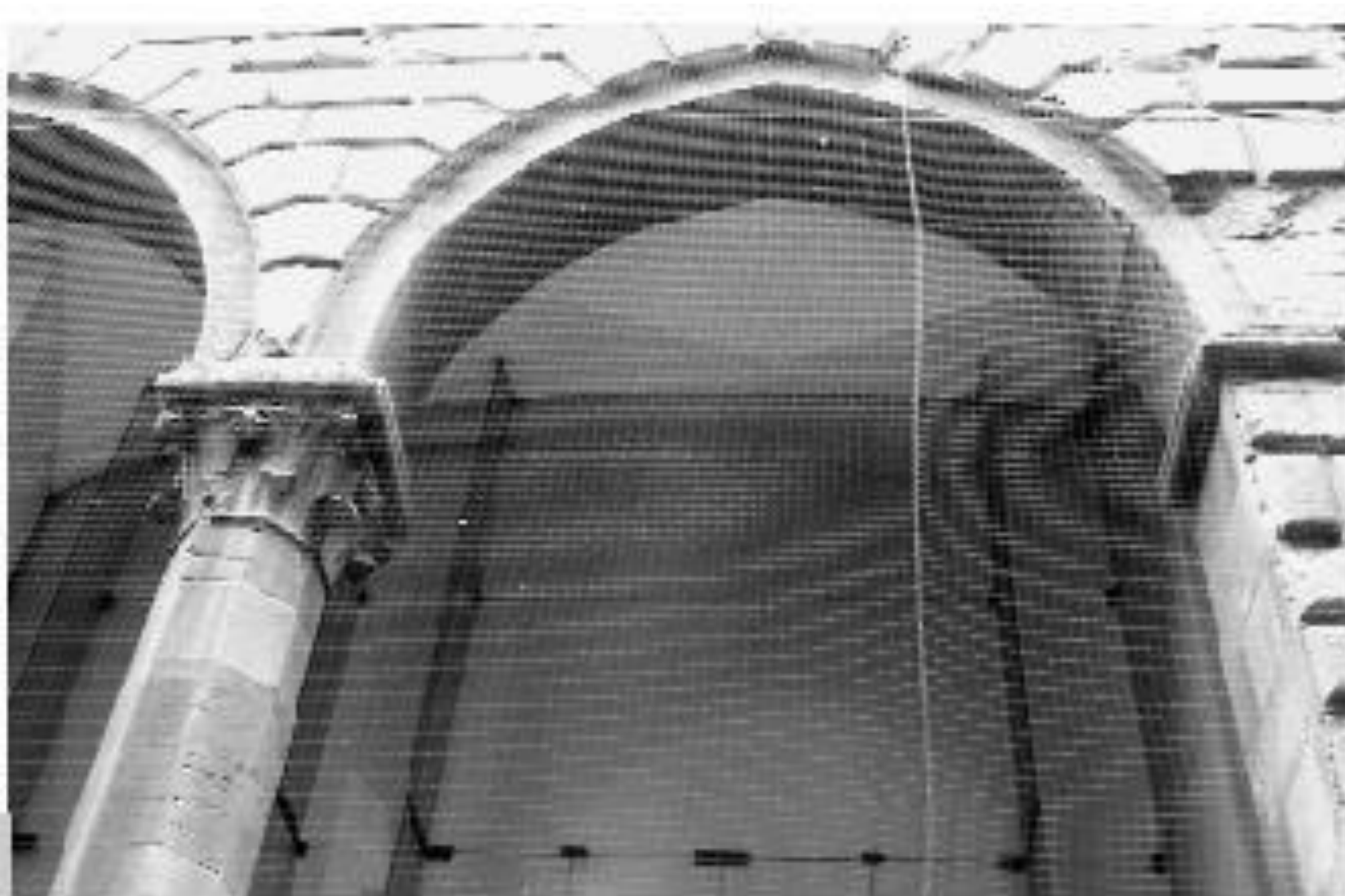
Figura 9 • Reti antivolatili alla loggia degli Abati di palazzo Ducale a Genova.
