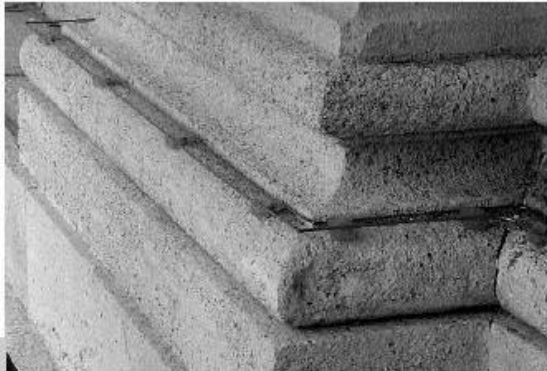
Figura 2 • Protezione della base di una parasta con sistema elettrostatico.
