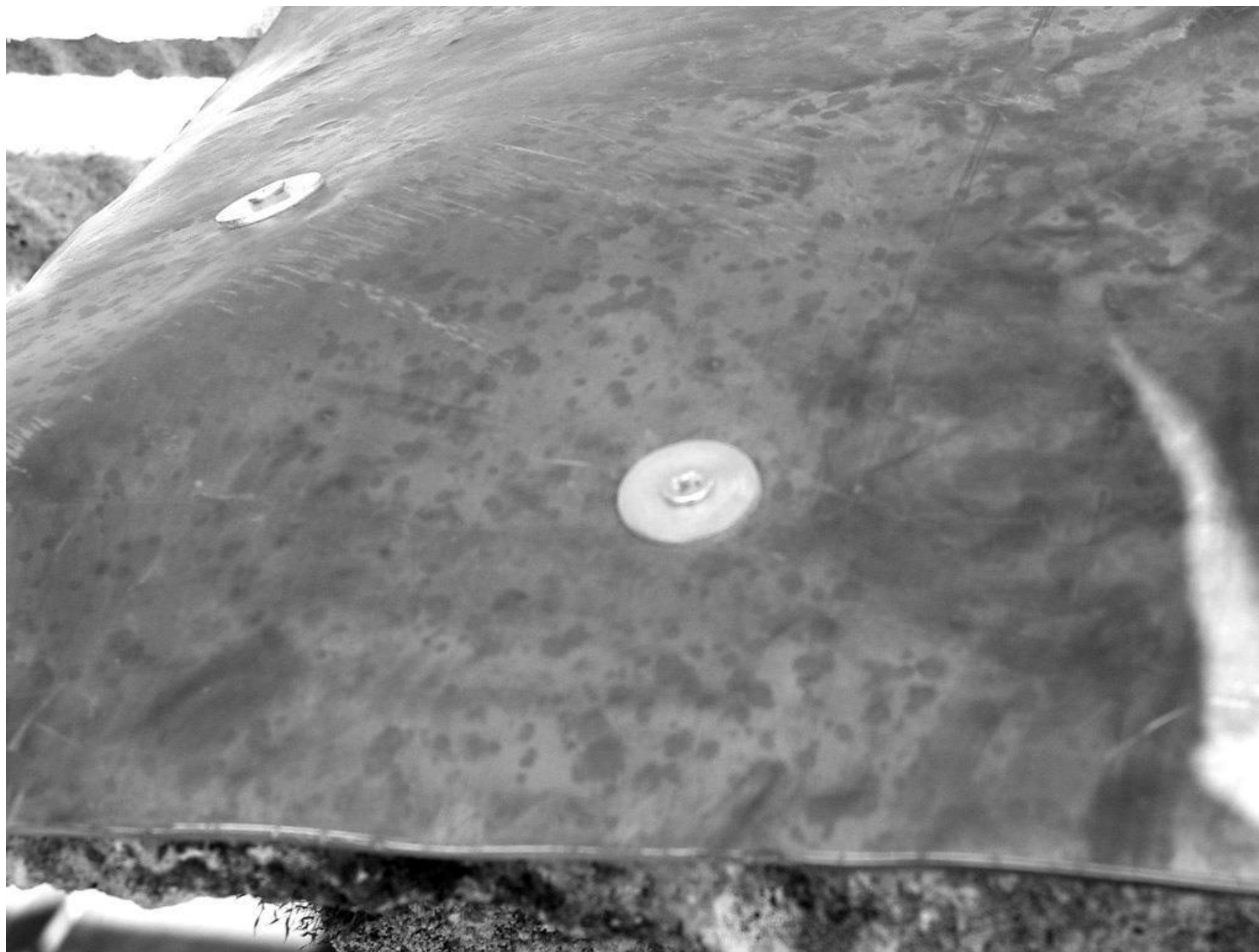
Figura 18 • Fissaggio di un foglio di piombo di grandi dimensioni con viti a espansione.
