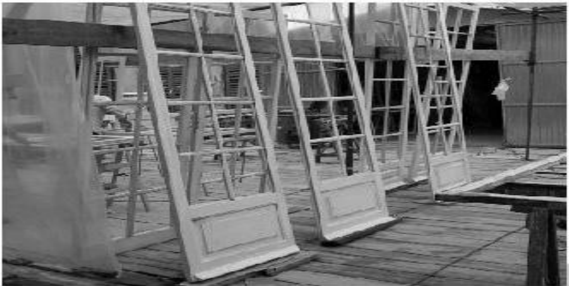
Figura 6 • Asciugatura dopo l'applicazione degli strati di coloritura.
