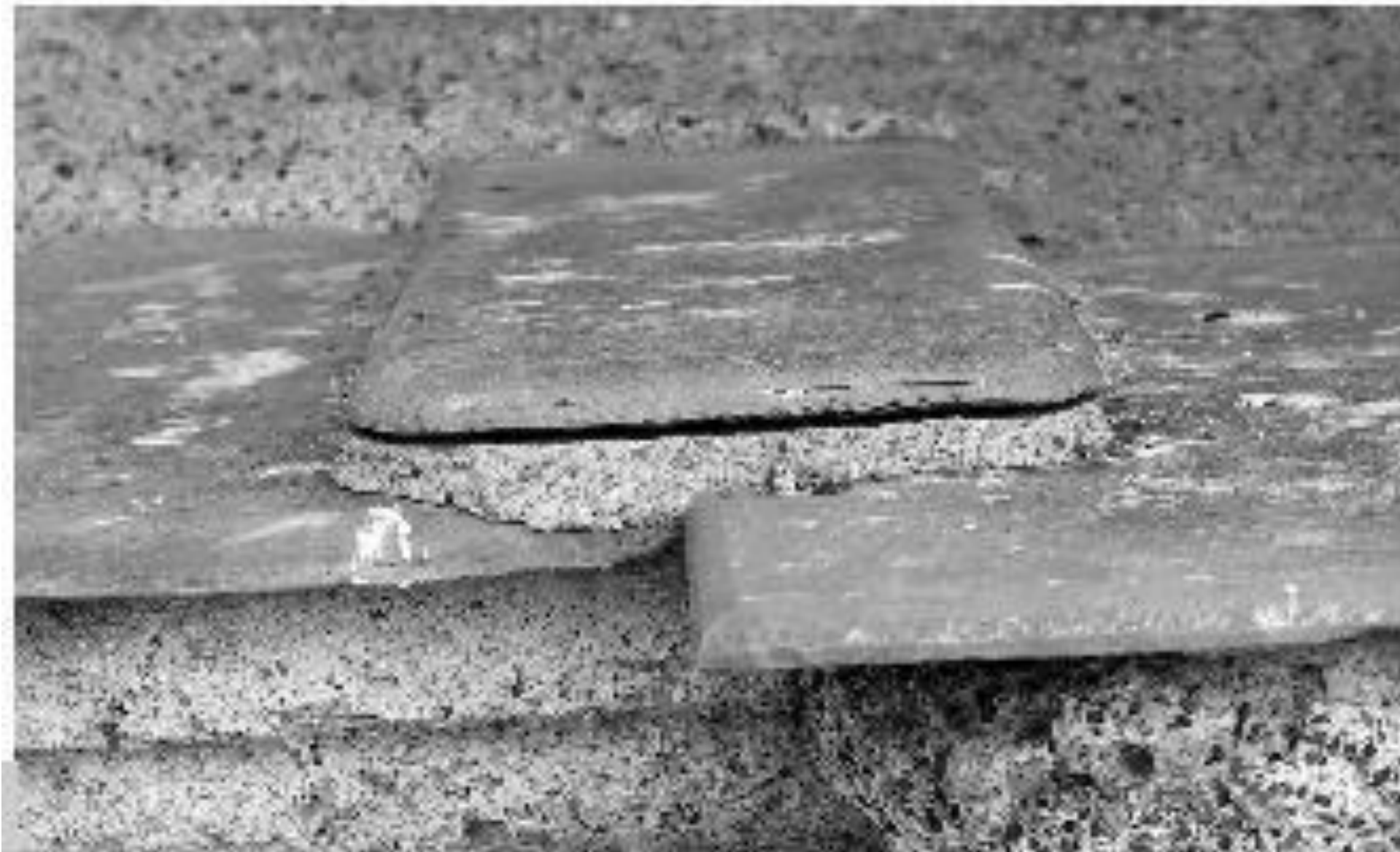
Figura 4 • Protezione dei giunti di una copertina in lastre di ardesia con altre lastre del medesimo materiale.
