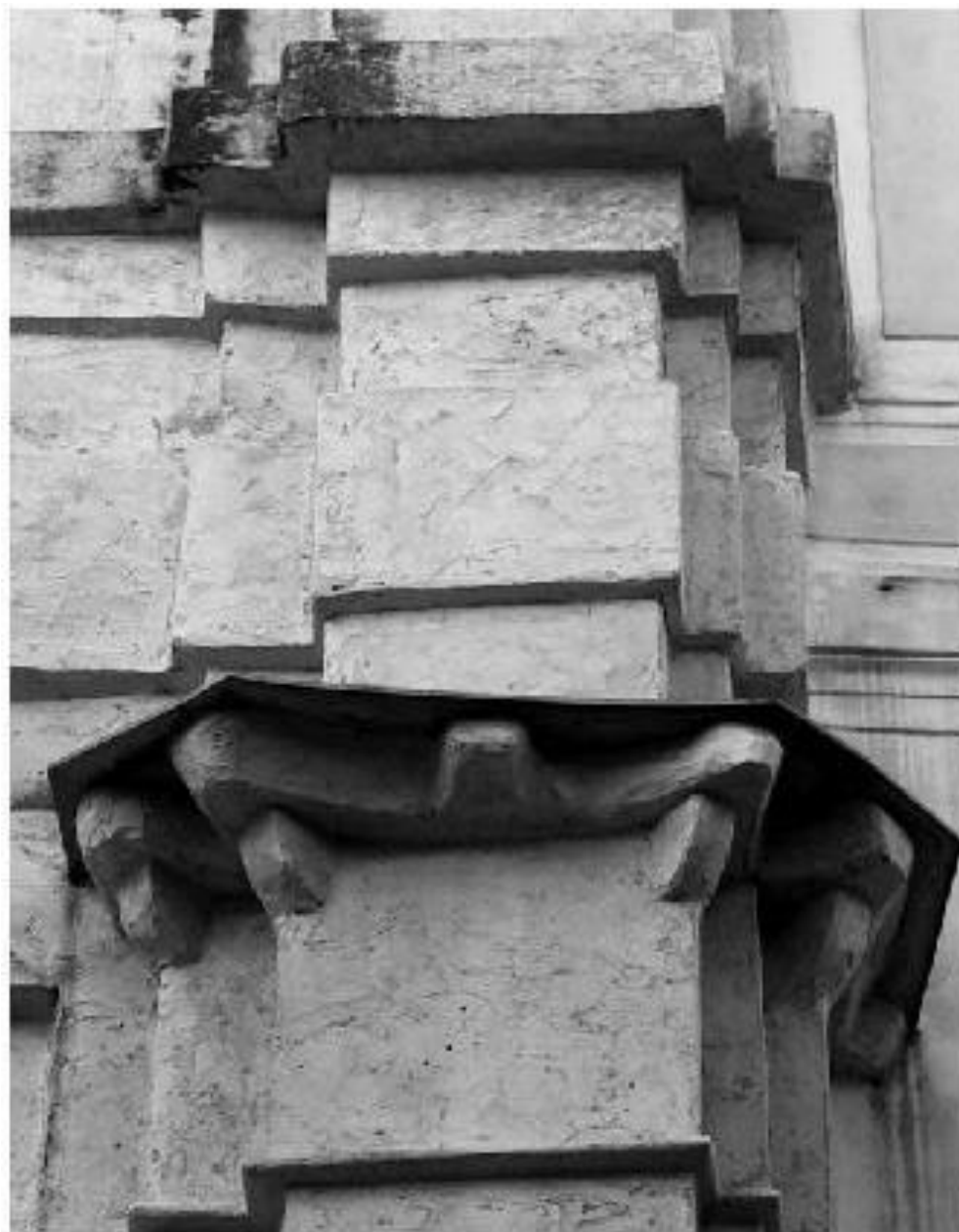
Figura 3 • Protezione di un capitello incompiuto sovrapponendo all'abaco una lastra di ardesia.
