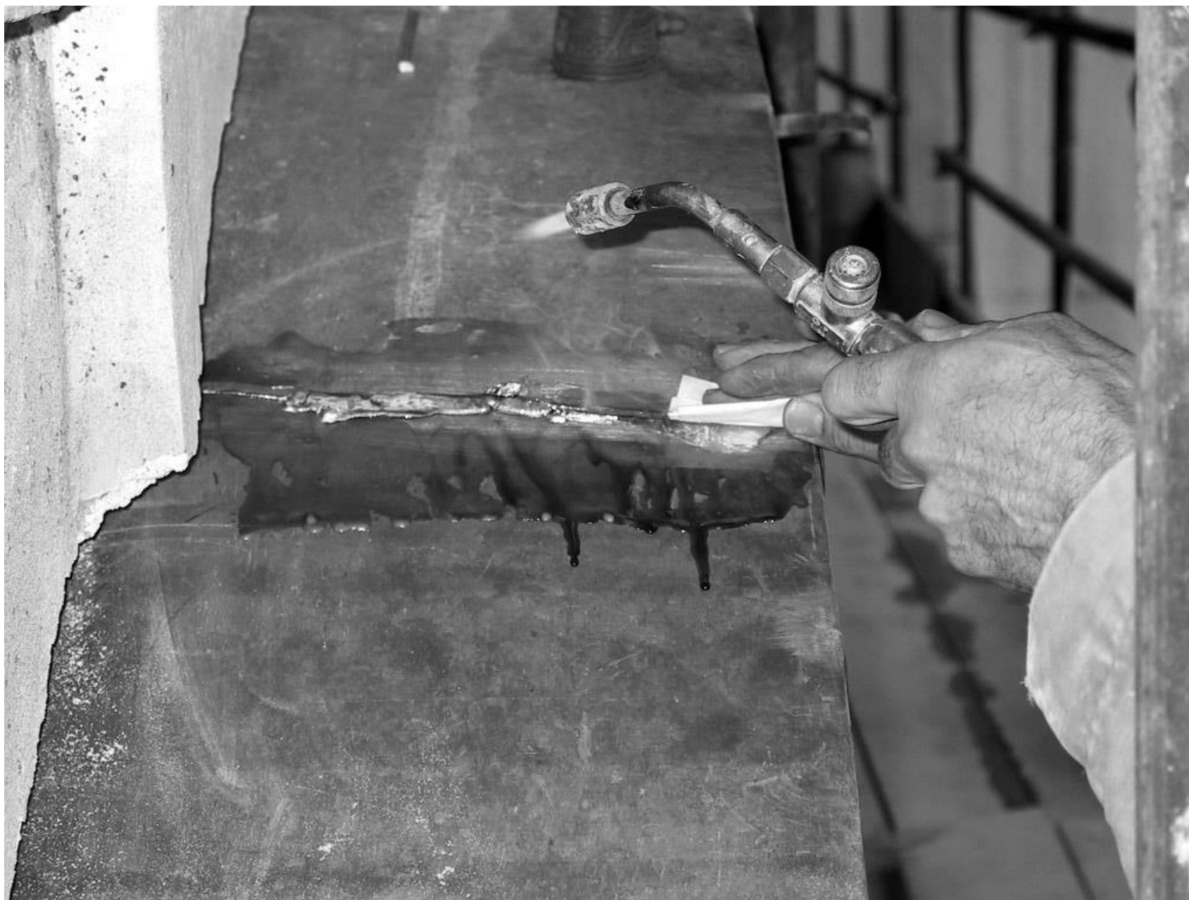
Figura 17 • Distribuzione dello stagno fuso con un foglio di carta ripiegato.
