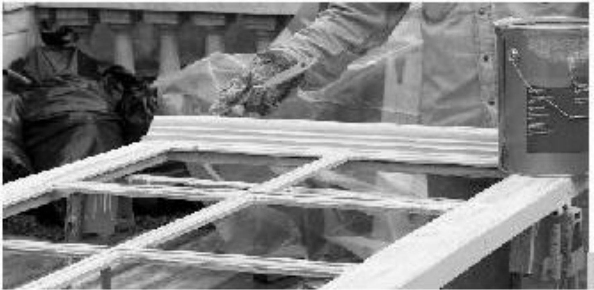
Figura 2 • Stesura a pennello del fondo.
