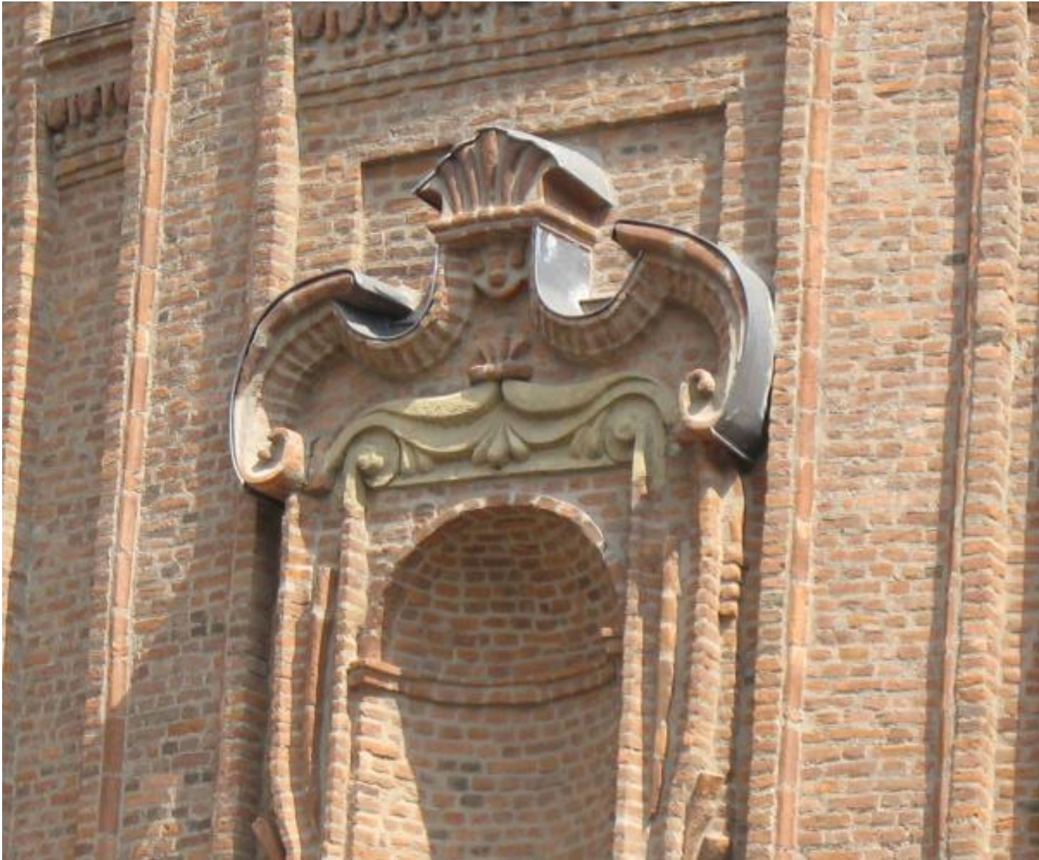
Figura 6 . Torino, Palazzo Carignano, particolare delle copertine di piombo a protezione degli elementi sporgenti della facciata.
