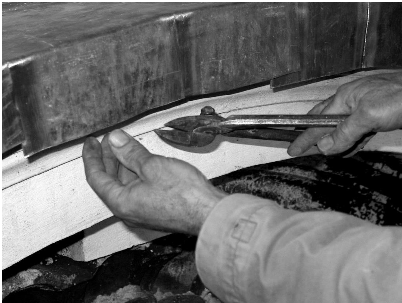
Figura 12 • Taglio con cesoie del materiale in eccesso.
