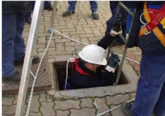
« **Protezione contro il rischio di caduta.** Il dispositivo di evacuazione e recupero è frenato e deve essere costantemente azionato da un operatore
