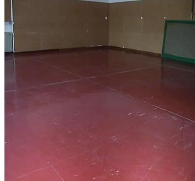
***I pavimenti in vinilamianto di per sé non costituiscono un problema urgente di salute pubblica e i lavori di rimozione condotti con procedure e tecniche di facile applicazione, sono in grado di evitare la contaminazione ambientale da parte di fibre di amianto.***
