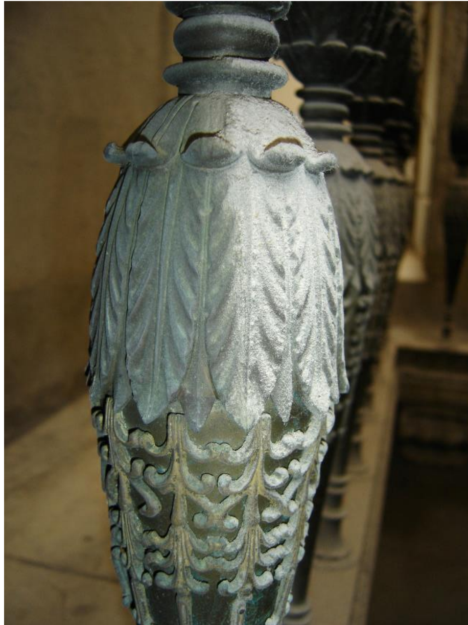
Figura 1 • Palazzo Nobile di Villa Torlonia (Roma). Particolare di un balastrino con evidente accumulo di particellato.
