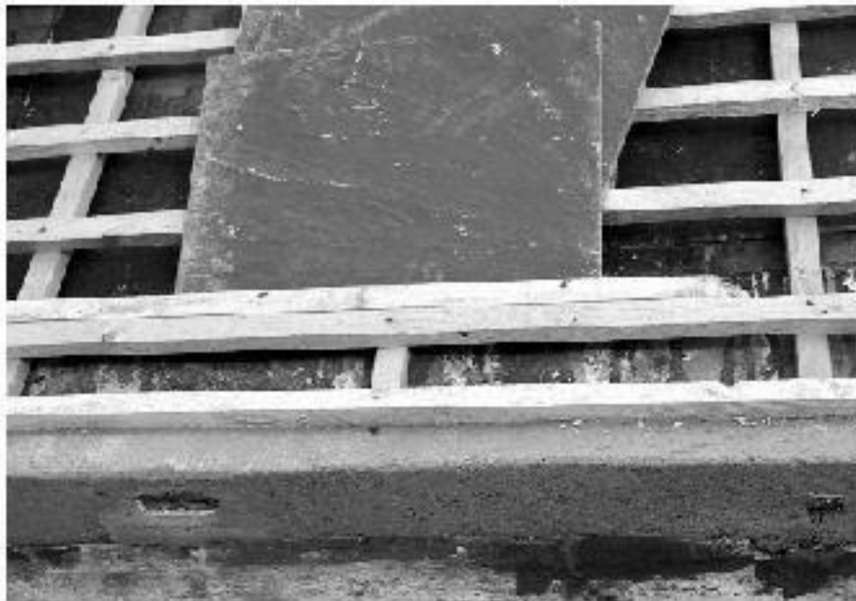
Figura 10 • Un abbadino posato sulla nuova struttura lignea e pronto per essere fissato.
