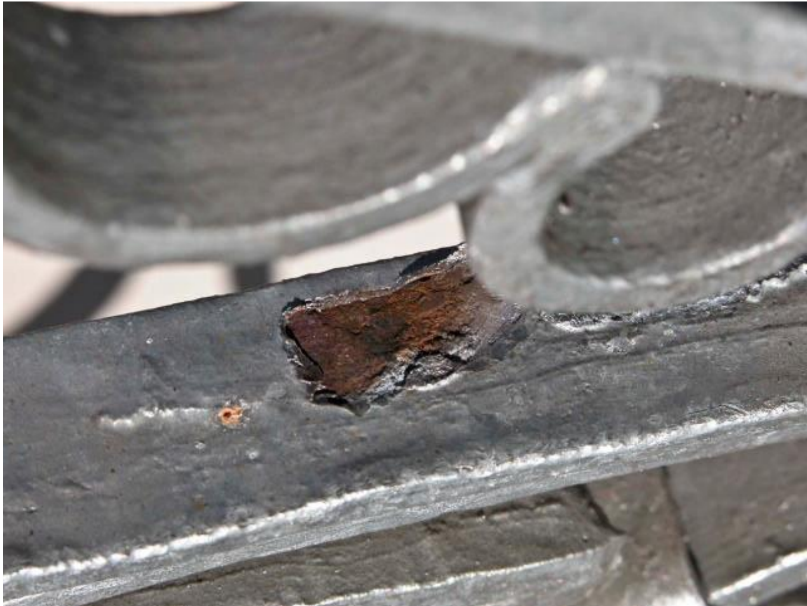
Figura 9 • Villa Barbaro a Maser. Cancelli seicentesco. Particolare della discontinuità della zincatura. Il ferro preindustriale è incompatibile con la zincatura che si stacca a scaglie lasciando scoperto il vecchio metallo.
