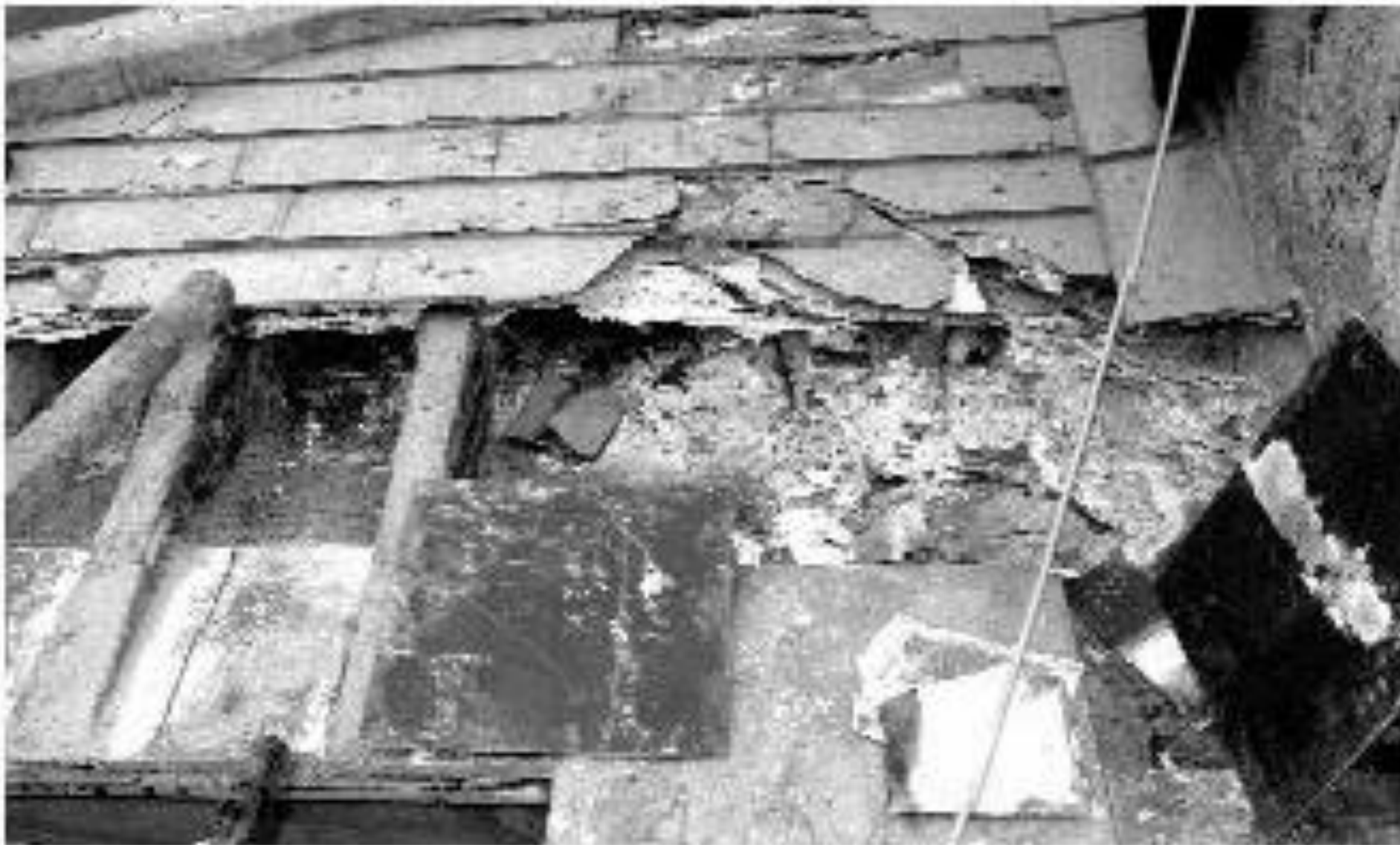
Figura 3 • Sostituzione graduale delle lastre d'angolo.
