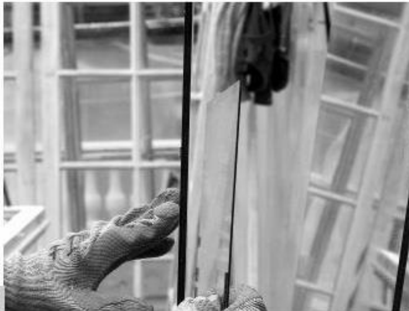
Figura 6 • Ricollocazione di una lastra di cristallo.
