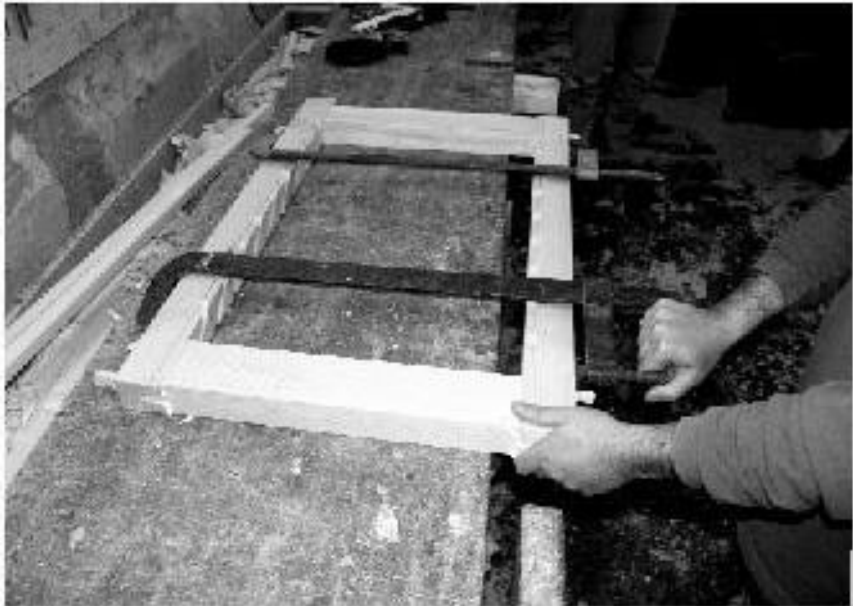
Figura 10 • Rifacimento di parte dello sportello di una persiana. Fase di assemblaggio e incollaggio del telaio.
