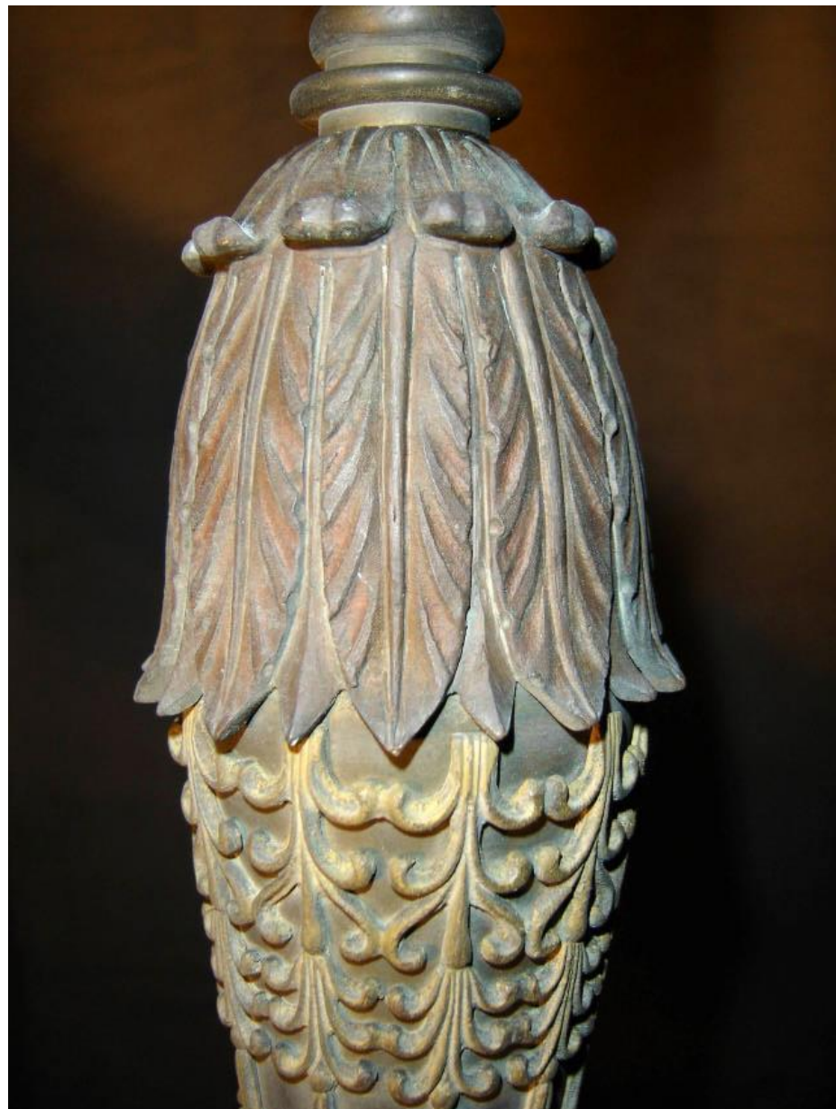
Figura 2 • Particolare del balastrino dopo la pulitura effettuata tramite spazzolini con setole sintetiche a microtrapano e a mano, avendo cura di preservare la patina originale.
