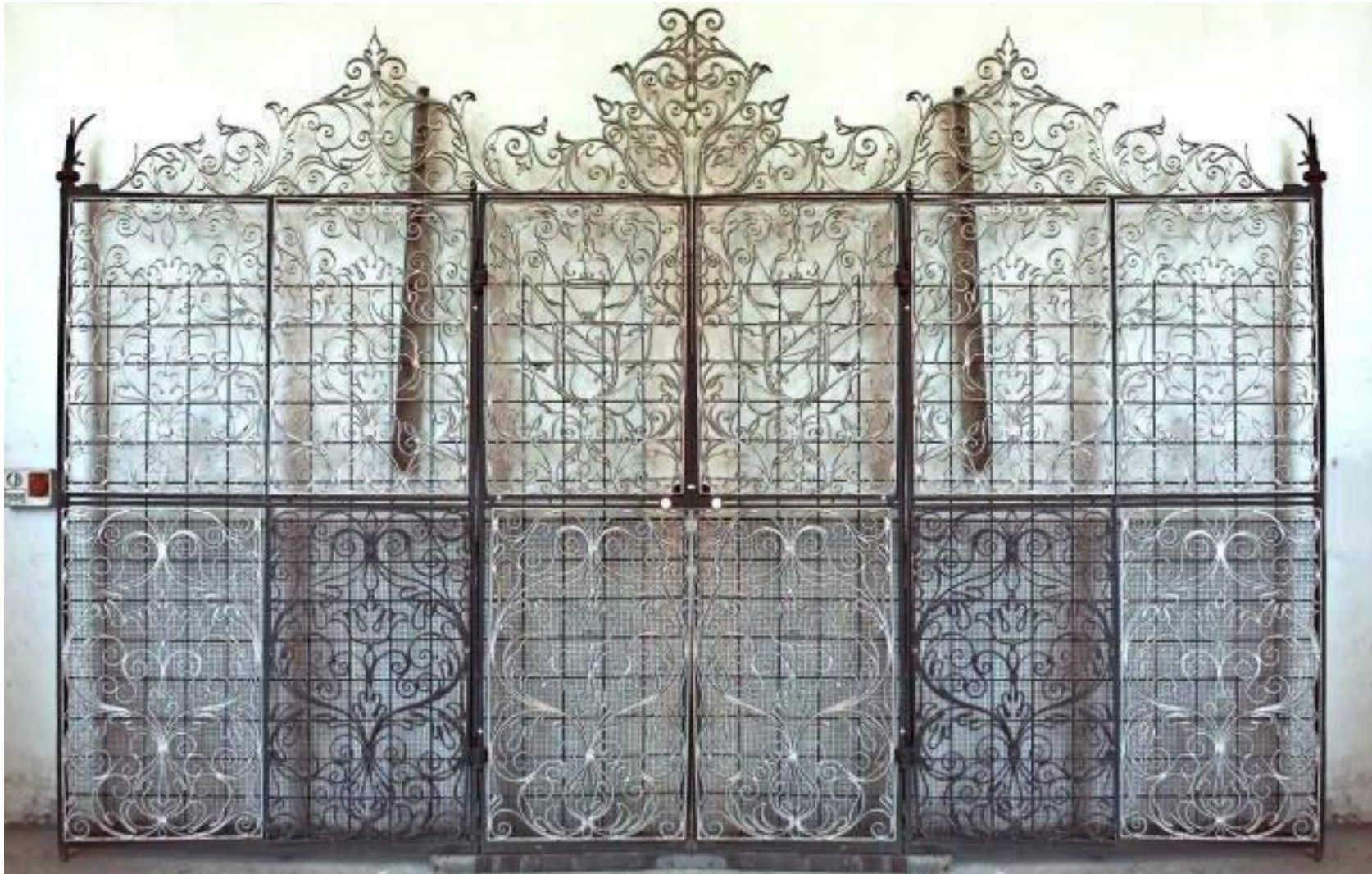
Figura 8 • Villa Barbaro a Maser. Cancellone seicentesco pulito impropriamente con sabbatura a secco e bagno acido e successivamente sottoposto a zincatura a caldo. Tali trattamenti hanno alterato in modo irreversibile le caratteristiche fisiche e chimiche della superficie metallica. Il cancellone, inoltre, è stato rimosso dalla collocazione originaria mediante tagli che hanno lasciato monconi residui delle volute decorative alle estremità superiori destra e sinistra.
