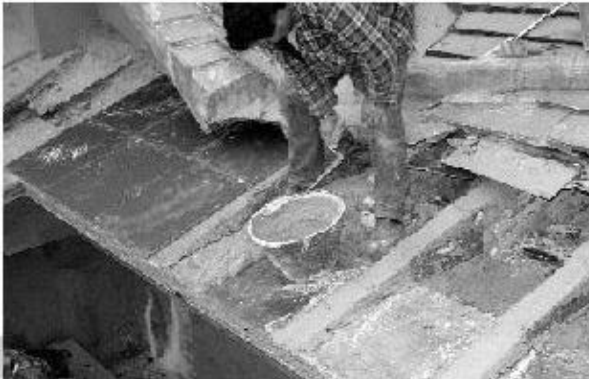
Figura 2 • Messa in opera delle lastre di gronda.
