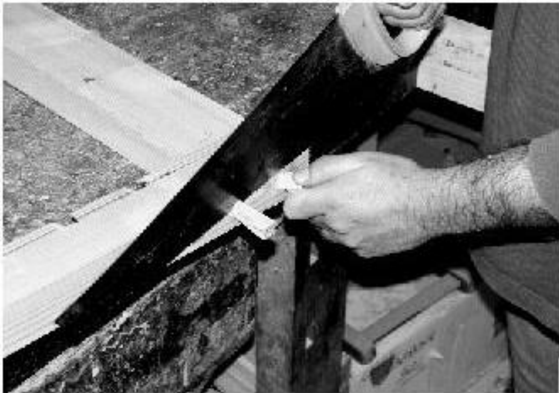
Figura 12 • Taglio delle zeppe di forzatura degli incastri.
