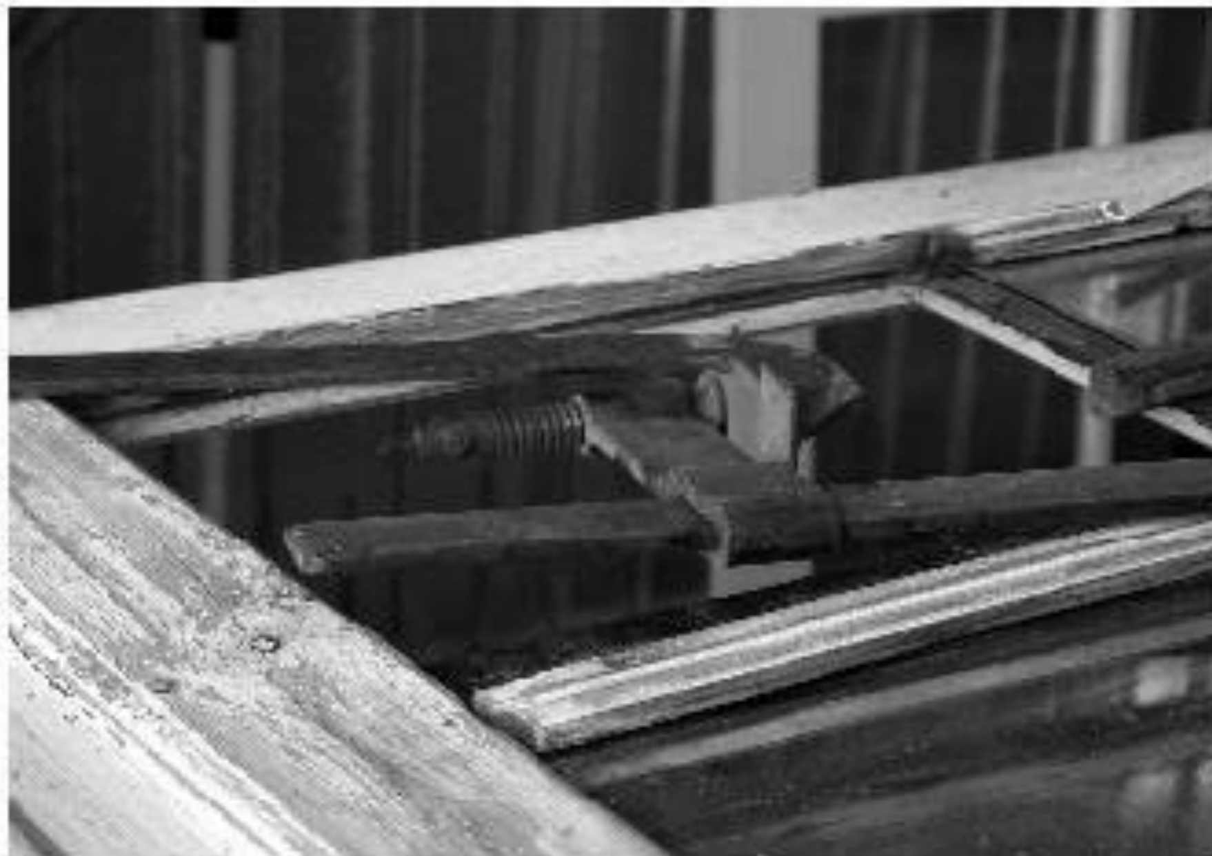
Figura 8 • Impiego di due morsetti per stringere il telaio.
