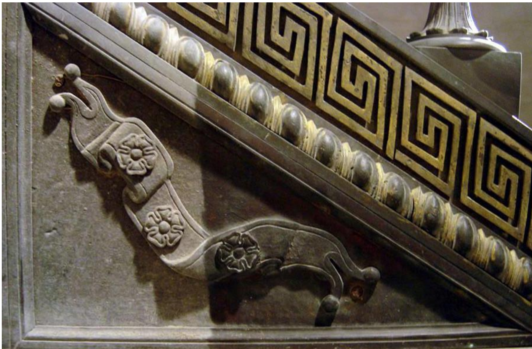
Figura 3 • Palazzo Nobile di Villa Torlonia (Roma). Particolare di una formella della ringhiera durante la stesura del protettivo a base di resina acrilica e benzotriazolo. Il protettivo oltre a proteggere il metallo dalla corrosione, esalta le decorazioni.
