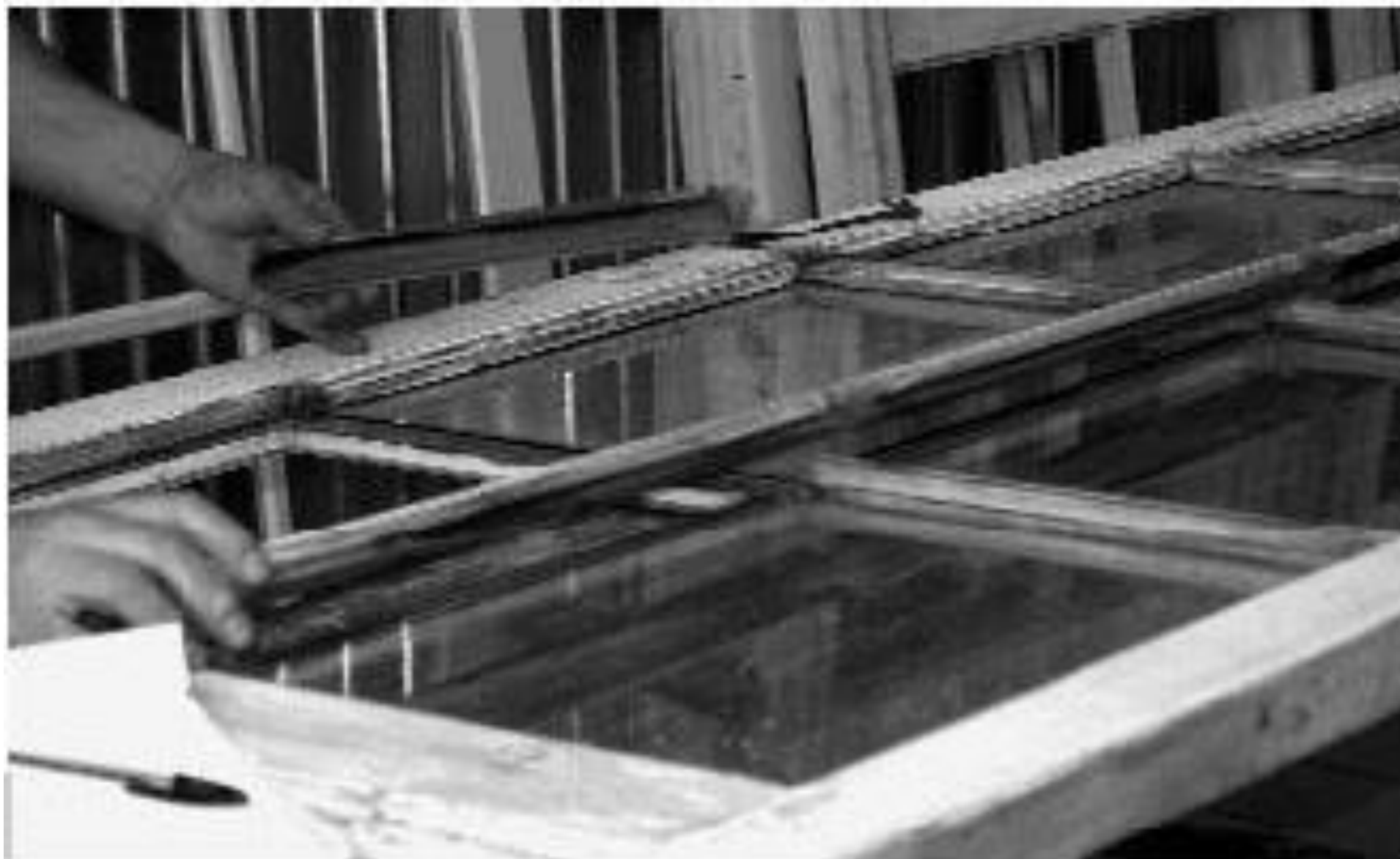
Figura 2 • Progressivo smontaggio dei vetri e dei listelli all'inglese.
