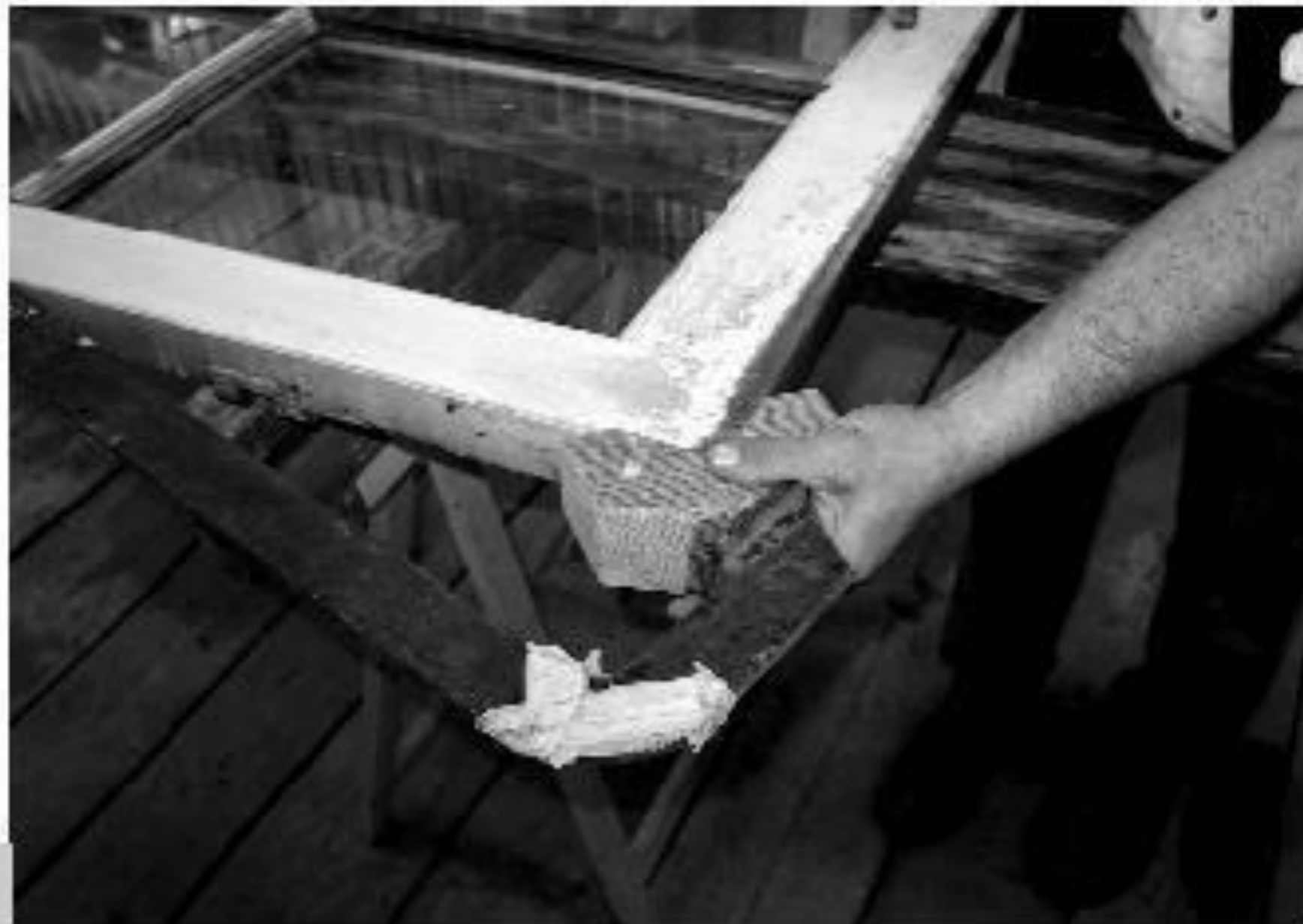
Figura 7 • Operazione di serraggio dell'incastro.
